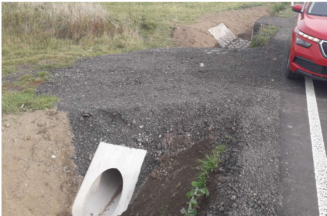
Obrázek 1 – navržené řešení opravy stávajících propustků
