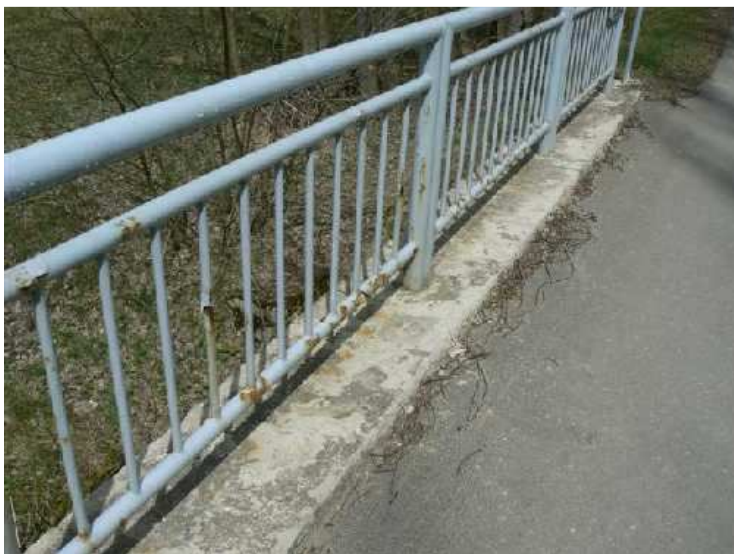
Stav zábradlí, silná koroze spodní trubky
