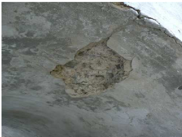
Odpad betonu v místě příčné praskliny
