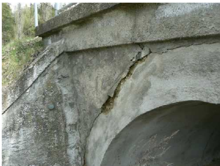
Detail oddělení čelní zdi od klenbového pásu
