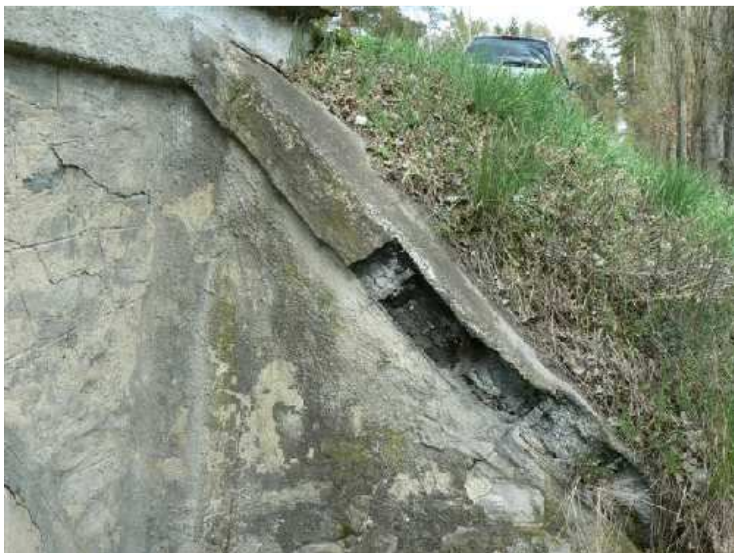
Rozpad křídelní římsy u OP2 vpravo
