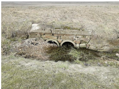
Obr. 1. – Pohled na vtokové (obr. vlevo) a výtokové (obr. vpravo) čelo propustku
