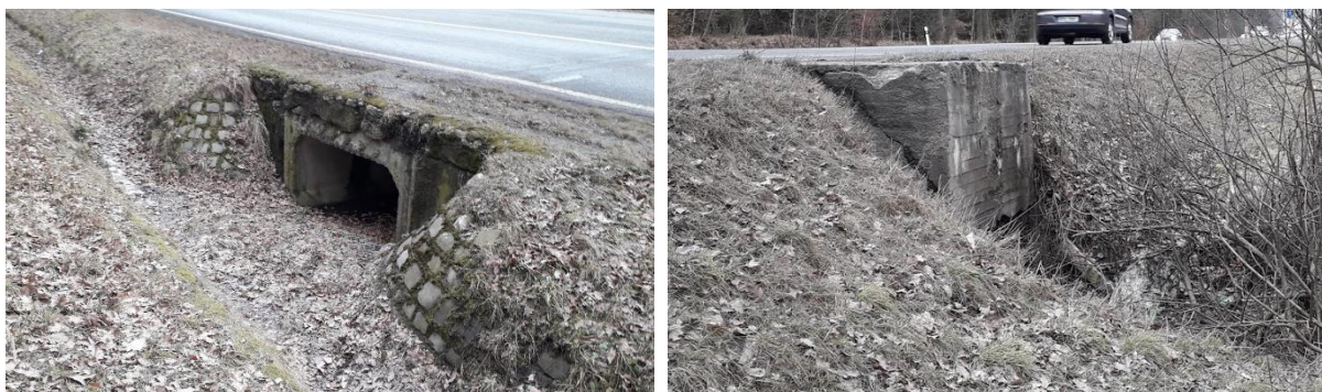
Obr. 2. – Pohled na vtokové (obr. vlevo) a výtokové (obr. vpravo) čelo propustku
