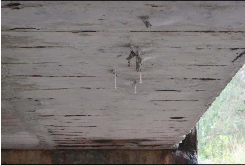
intenzivní aktivní průsaky z výluhy pojiva na spodním líci 10. nosníku v 1. poli
