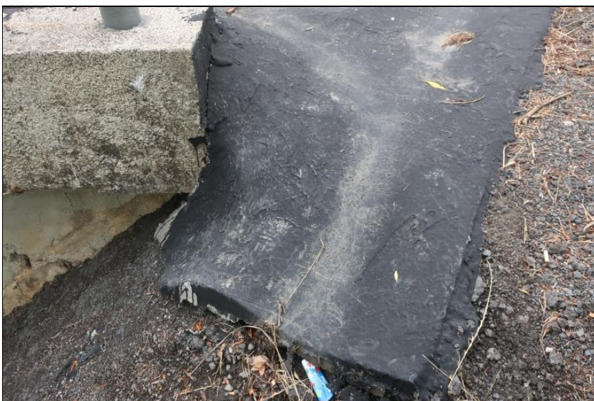
odvodňovací skluz vpravo za O3
