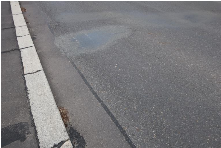
opravy krytu vozovky
