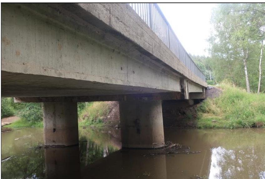
pravý bok mostu od O1
