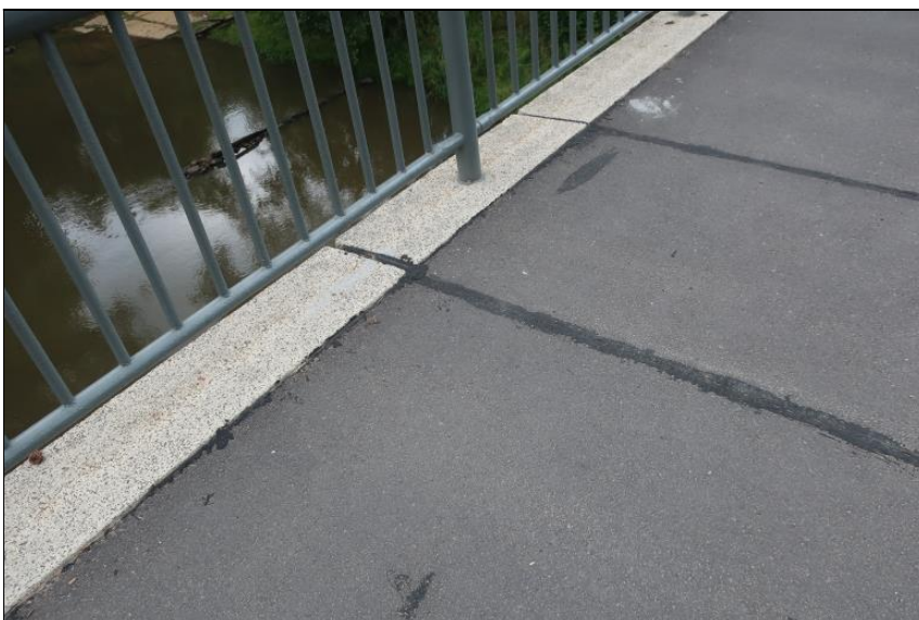
těsnění spár v chodníku nad P2
