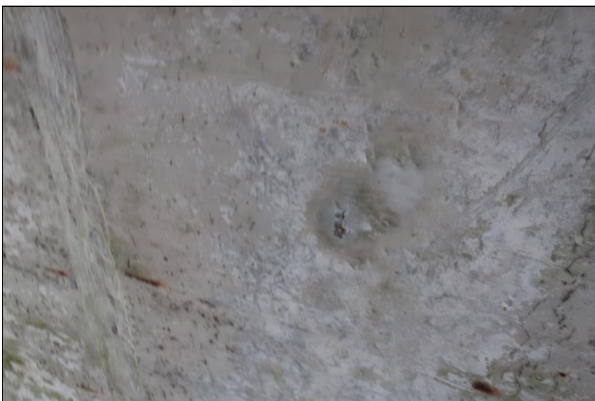
bodový aktivní průsak spodní deskou nosníku
