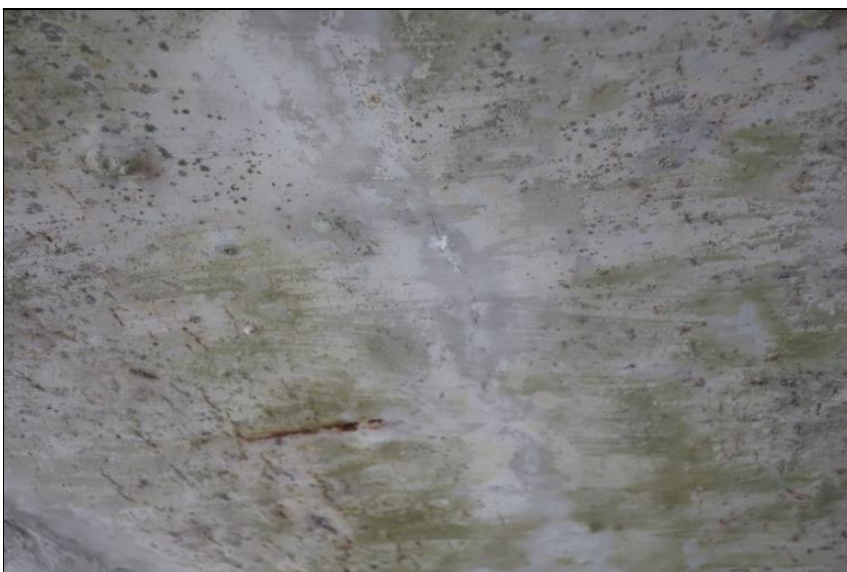
mrazový rozpad a podélná trhлина se stopami po průsacích kopírující trajektorii předpínací výztuže na spodním líci nosníku
