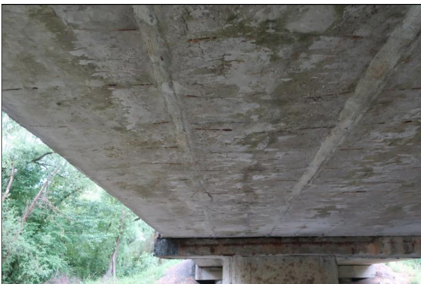
podhled 8.-10. nosníku od O3
