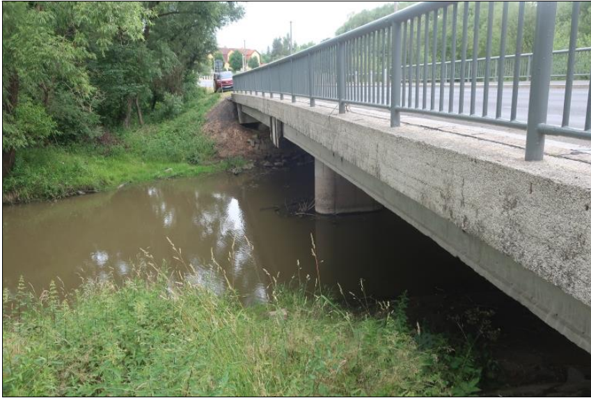
pravý bok mostu od O3
