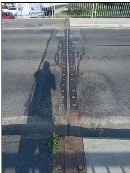
Zanesený a poškozený mostní závěr.
