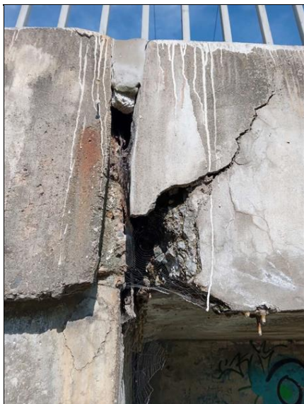
Rozpad betonu.
