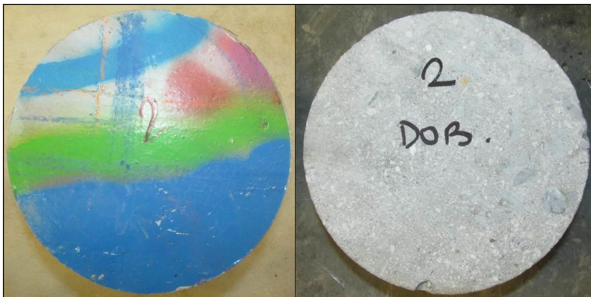
Foto 8: Celkový pohled na čelo vývrtnu CHRL2 před zkouškou (před a po odříznutí vrstvy sanace na líci vývrtnu)
