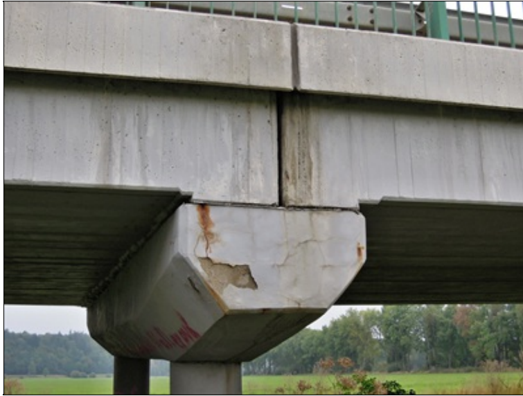
levý bok konstrukce a pilíře P5
