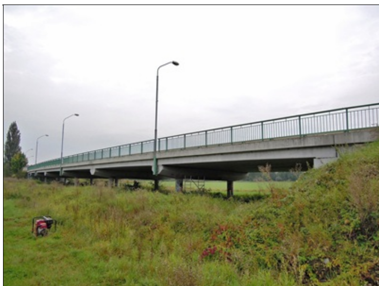
celkový pohled na pravou stranu od opěry 8
