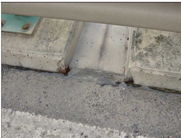
osazení chrliče v levé římse
