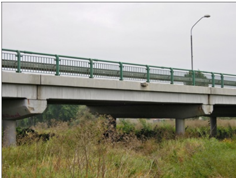
pohled na levou stranu 4.pole; uprostřed rozpětí chrlič odvodňující vozovku
