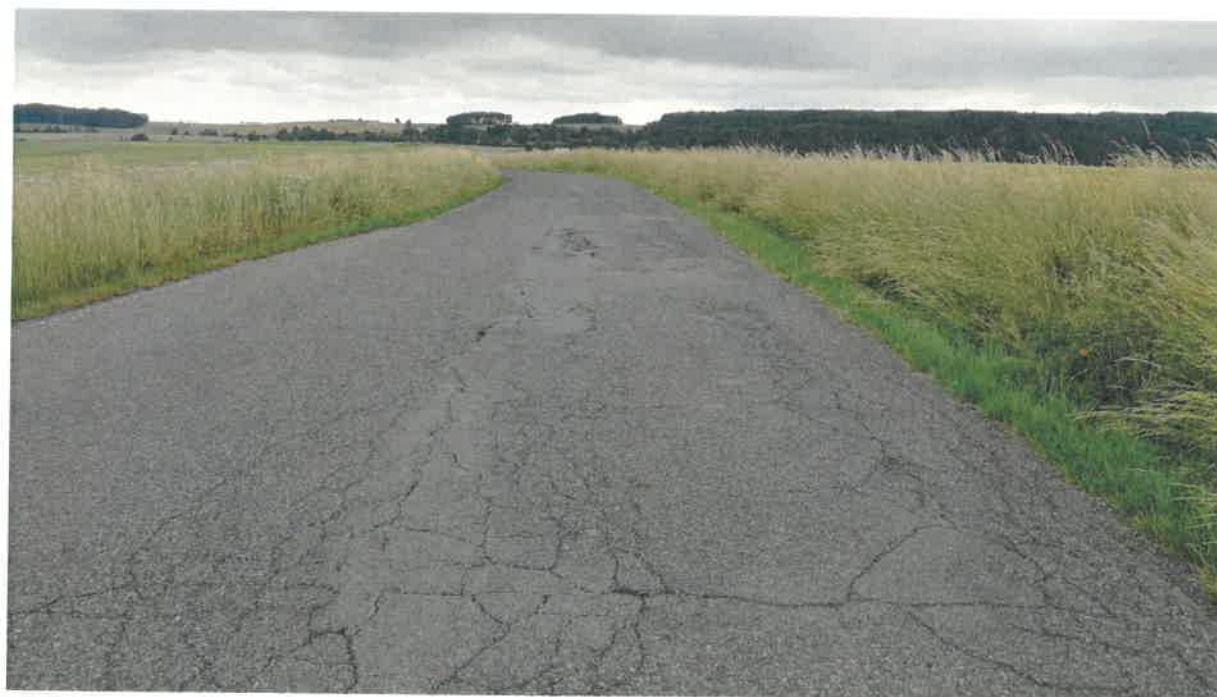
Obr. 10 Místo vrtu JV4 (pohled vpřed)
