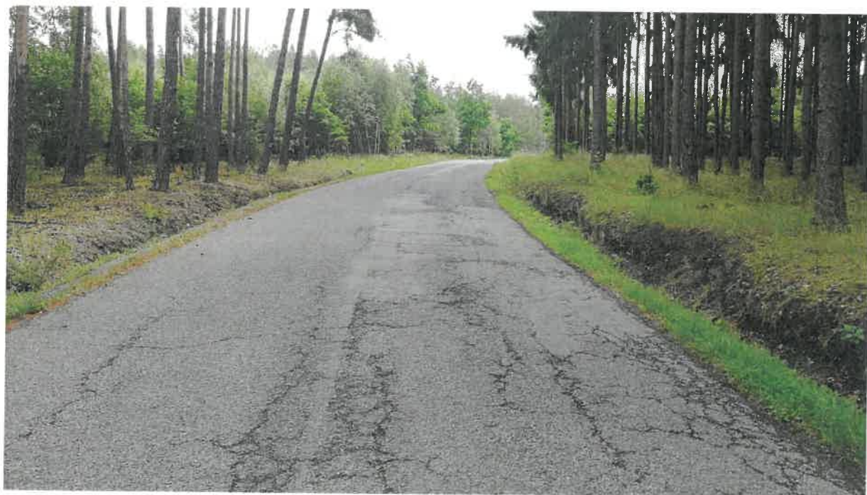
Obr. 16 Místo vrtu JV6 (pohled vpřed)
