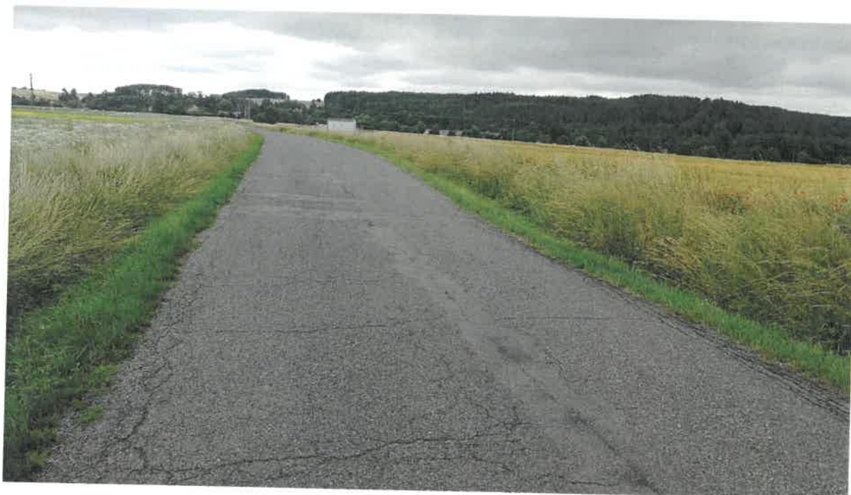
Obr. 7 Místo vrtu JV3 (pohled vpřed)
