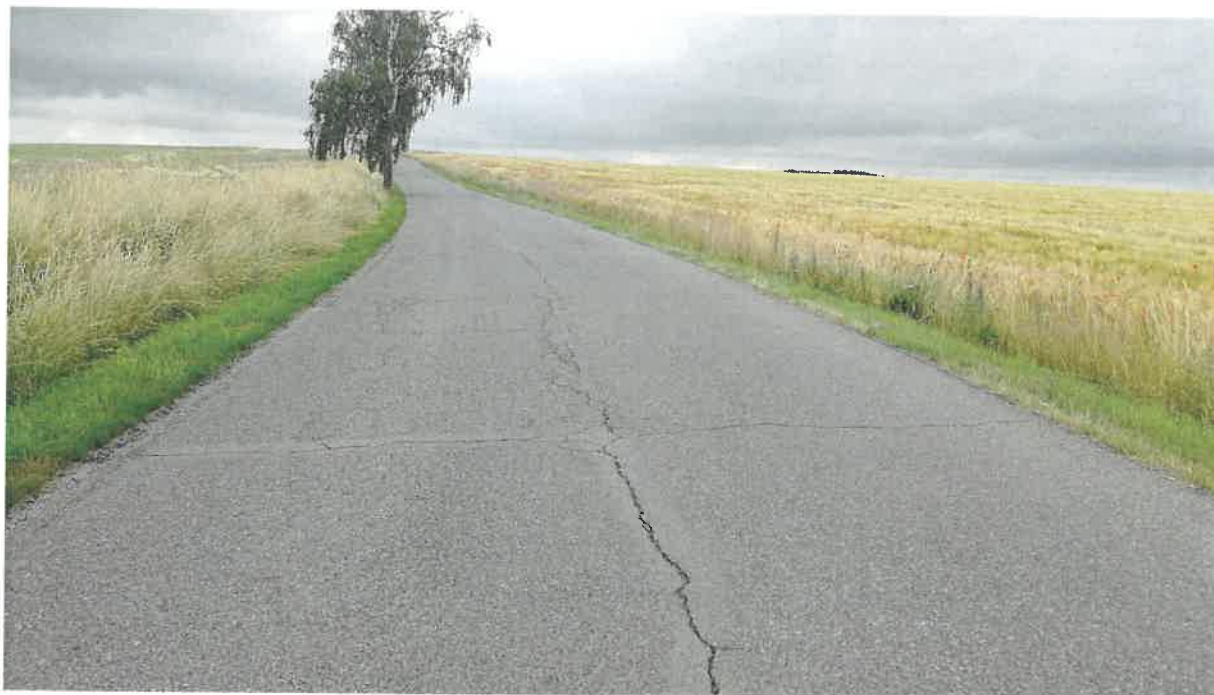
Obr. 13 Místo vrtu JV5 (pohled vpřed)
