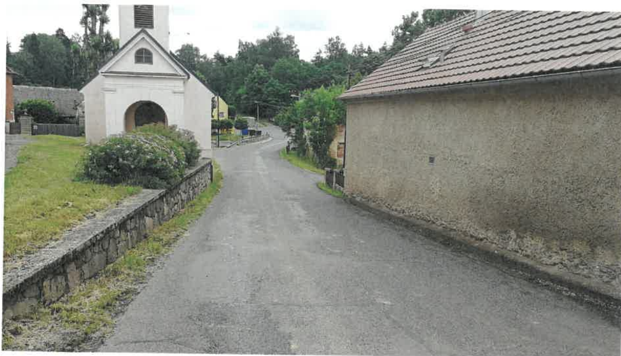
Obr. 1 Místo vrtu JV1 (pohled vpřed)
