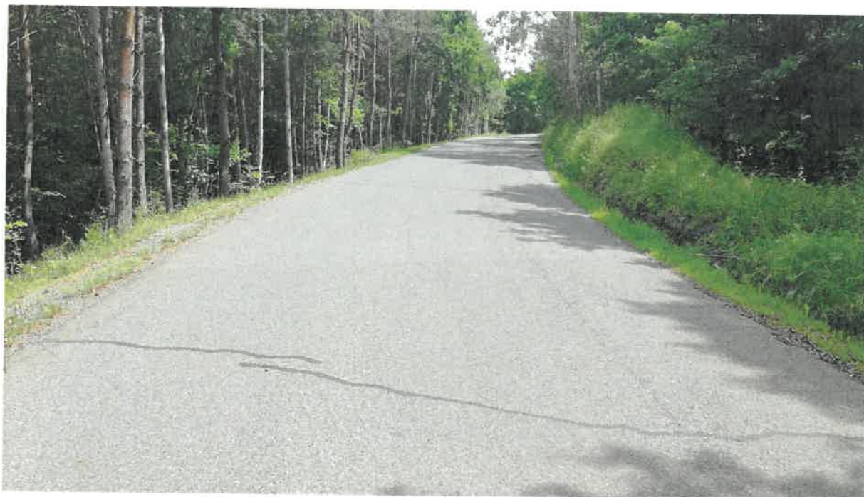
Obr. 19 Místo vrtu JV7 (pohled vpřed)
