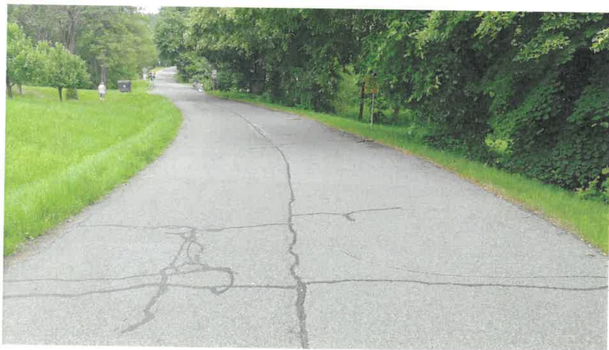
Obr. 22 Místo vrtu JV8 (pohled vpřed)
