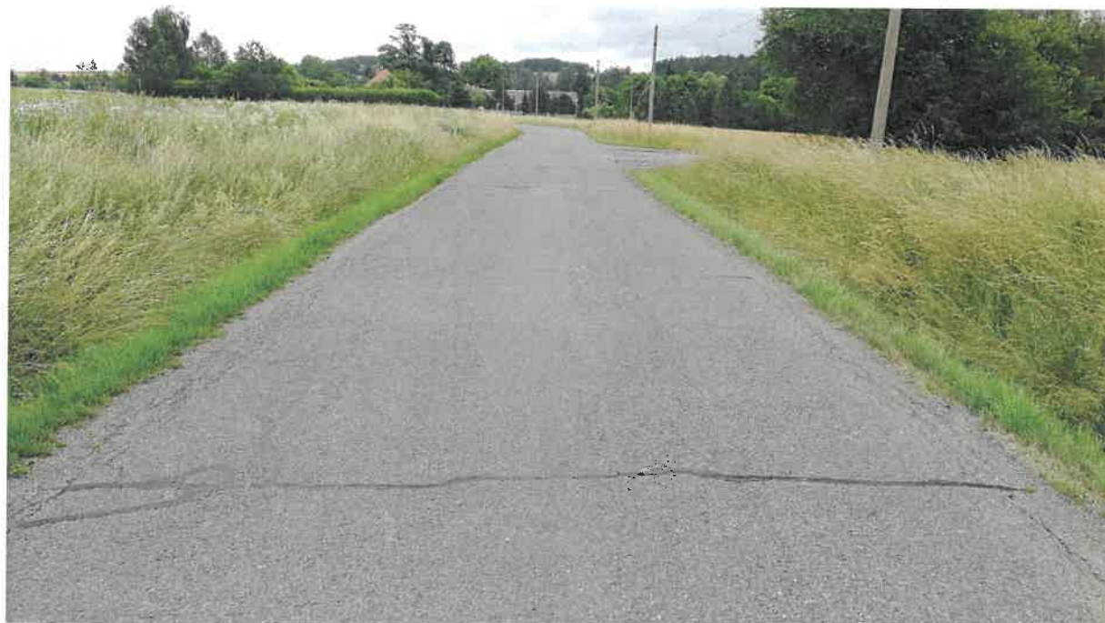
Obr. 4 Místo vrtu JV2 (pohled vpřed)
