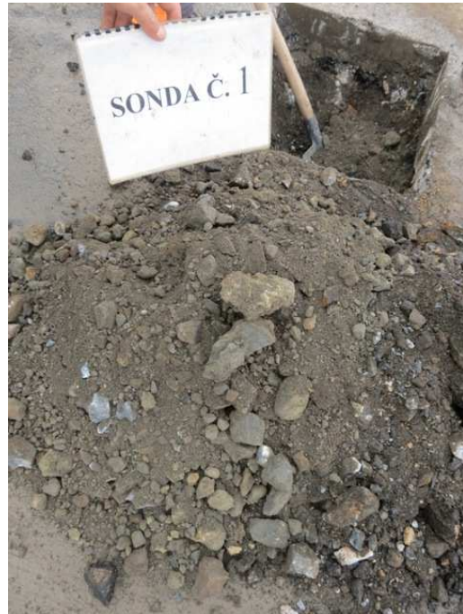
Sonda č.1 – materiál konstrukční vrstvy
