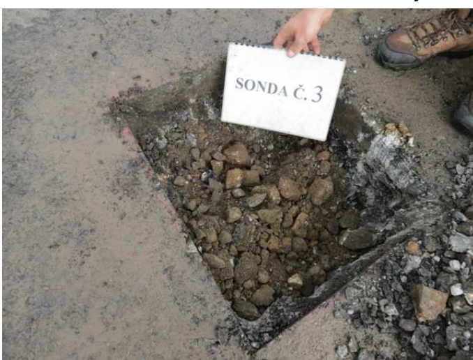
Sonda č.3 – materiál konstrukční vrstvy
