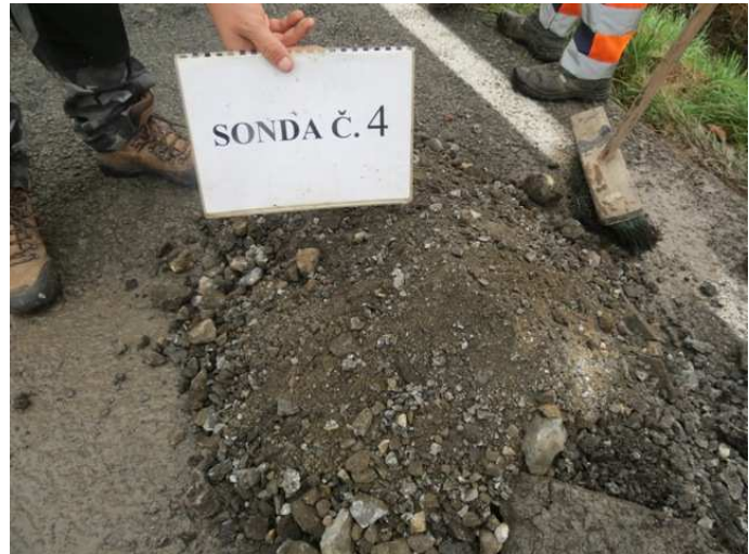
Sonda č.4 – materiál konstrukční vrstvy
