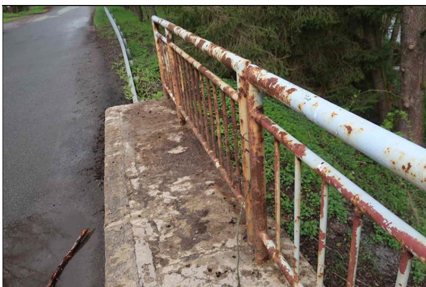
koroze zábradlí
