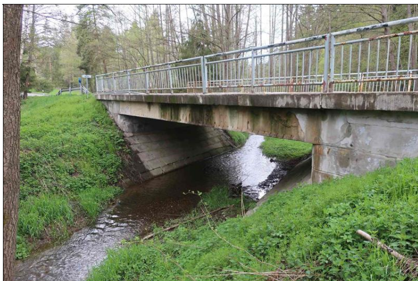
pohled na levou stranu mostu
