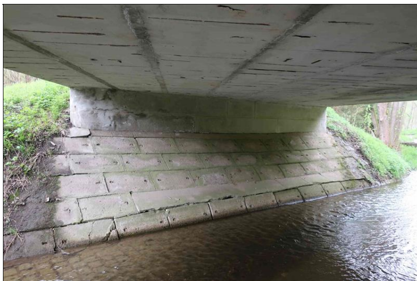
podhled NK od O1
