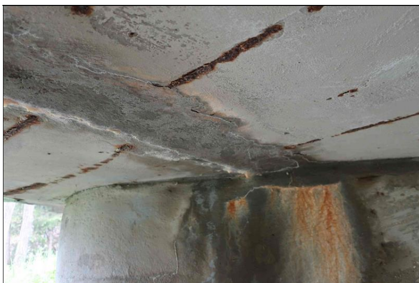
výrazný průsak na líci O1 vpravo
