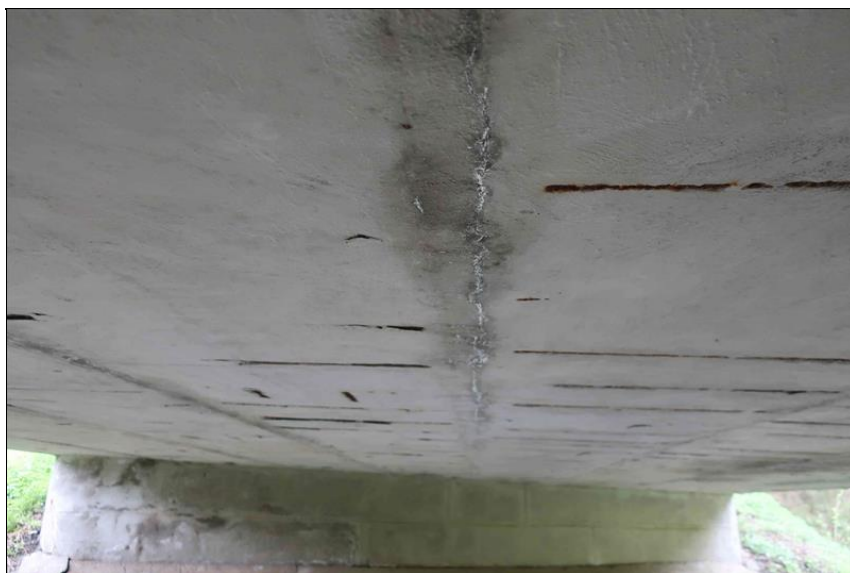
stopy po průsaku s drobnými výluhy pojiva na spodním líci NK
