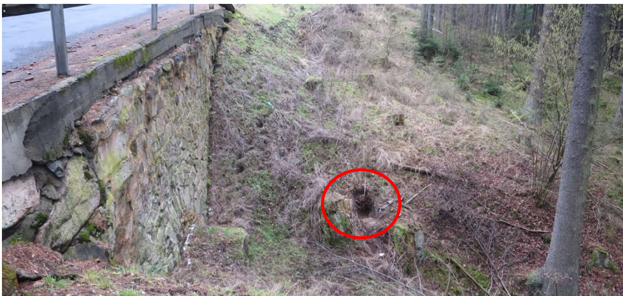
Obrázek č. 2: Propustek č. 2 a místo realizace ručně kopané sondy P2
