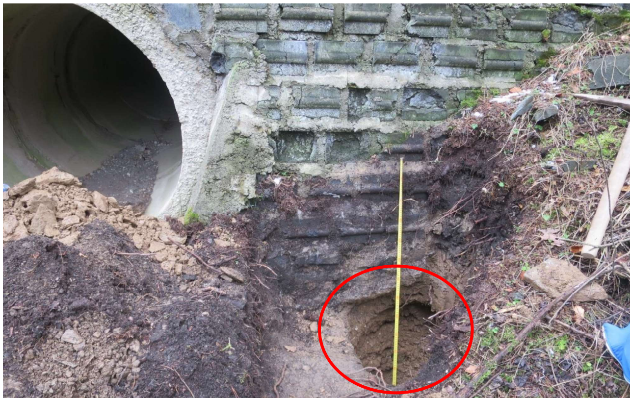
Obrázek č. 3: Propustek č. 3 a místo realizace ručně kopané sondy P3
