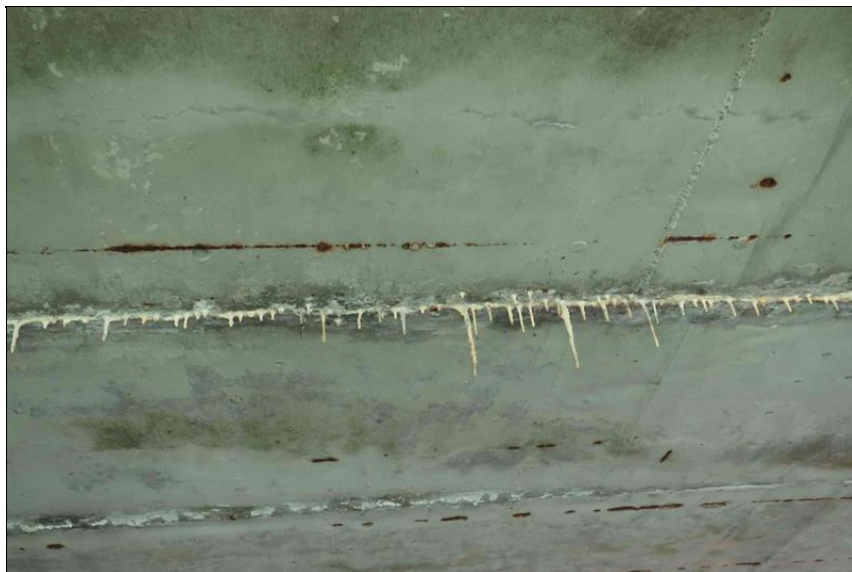
průsaky s výluhy pojiva sparou mezi nosníky v 1. poli
