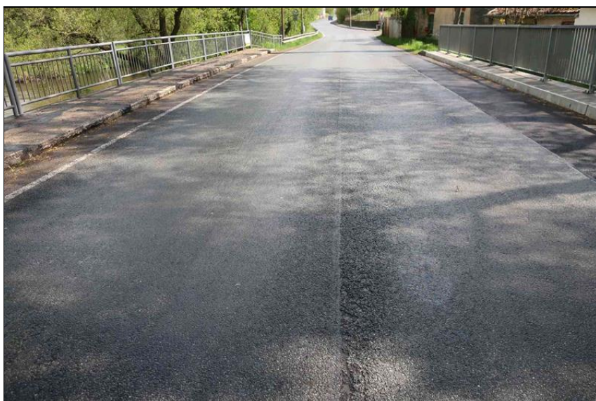
kryt vozovky proti směru staničení
