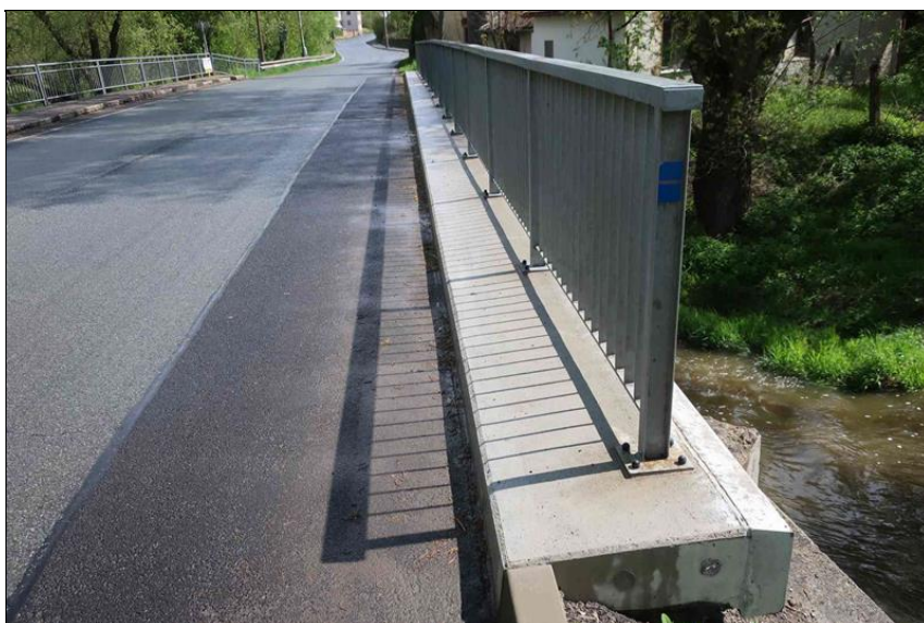
levá římsa a zábradlí po opravě
