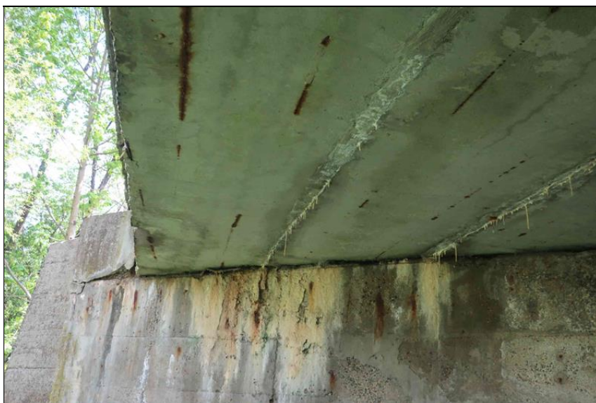
uložení 9. a 10. nosníku na O1
