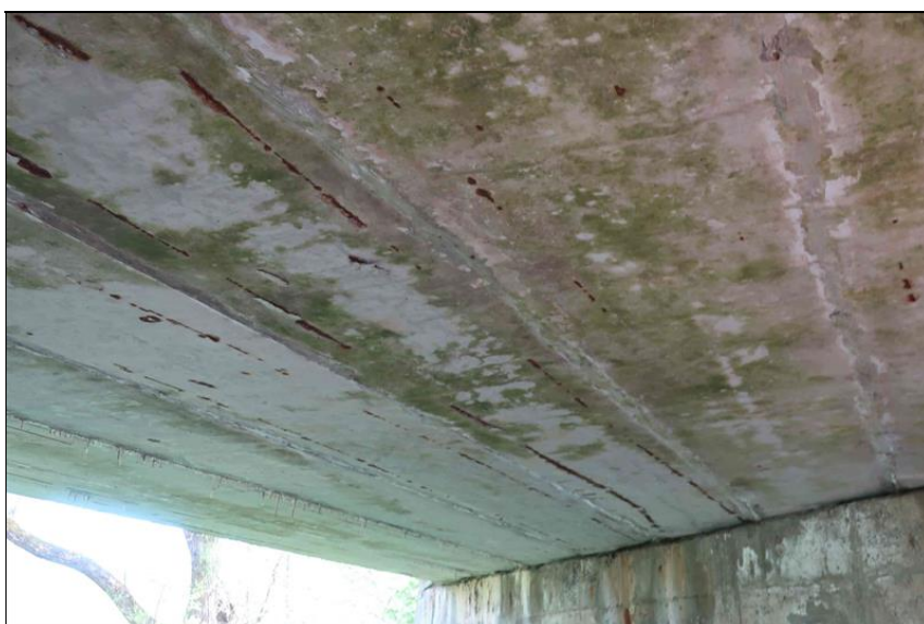
podhled NK ve 2. poli
