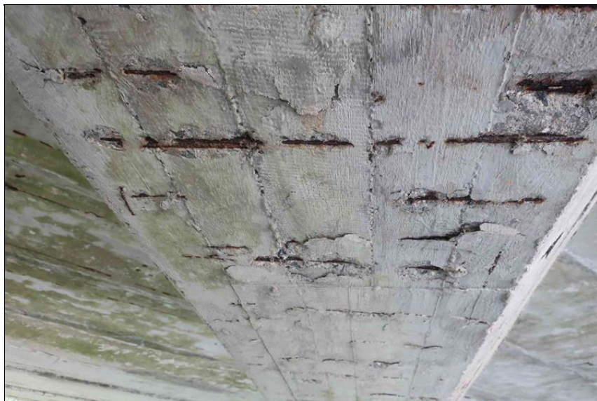
podhled stativa P2 mezi stojkami
