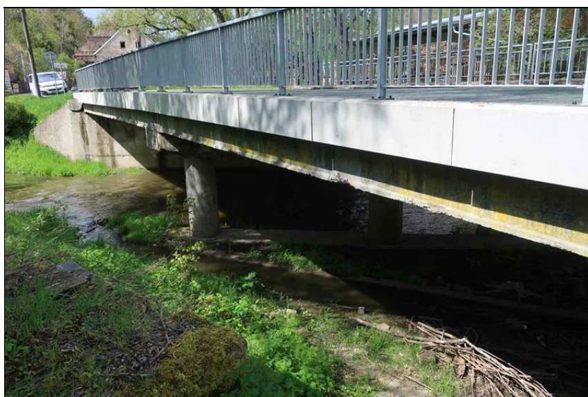
pohled na levou stranu mostu
