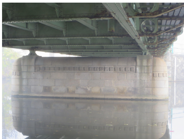
Foto – pilíře mostu, krajní zabudovaný do nábrežní zdi a střední zaoblený po celém obvodu
