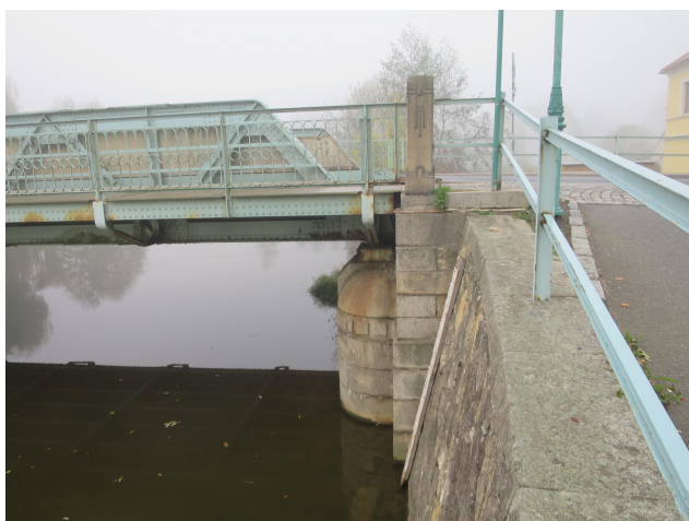
Foto – pilíře mostu, krajní zabudovaný do nábrežní zdi a střední zaoblený po celém obvodu
