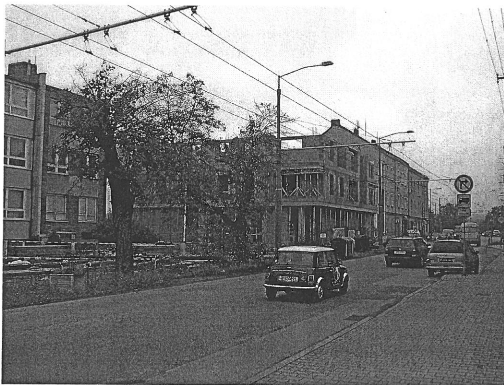
Obr. 1 – pohled proti staničení na začátek úseku, v pozadí dva domy s obchody v přízemí a obytnými dvěma podlaží nad nimi, v popředí jsou objekty nebytového charakteru.
