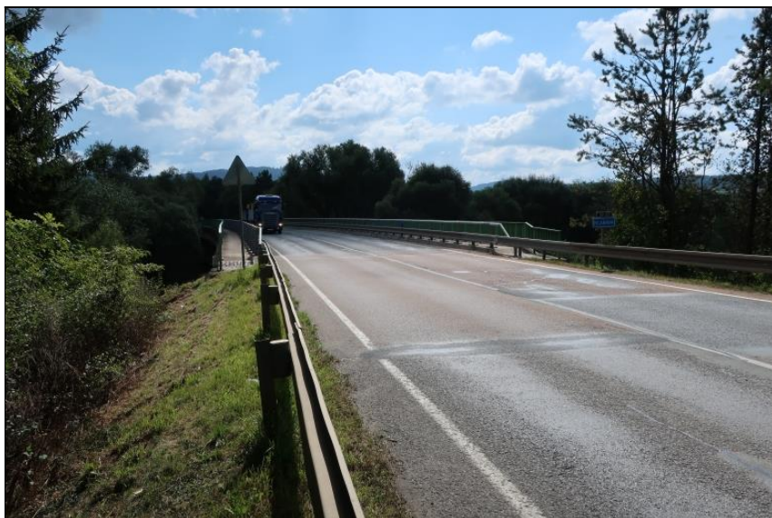
příčné uspořádání na mostě proti směru staničení
