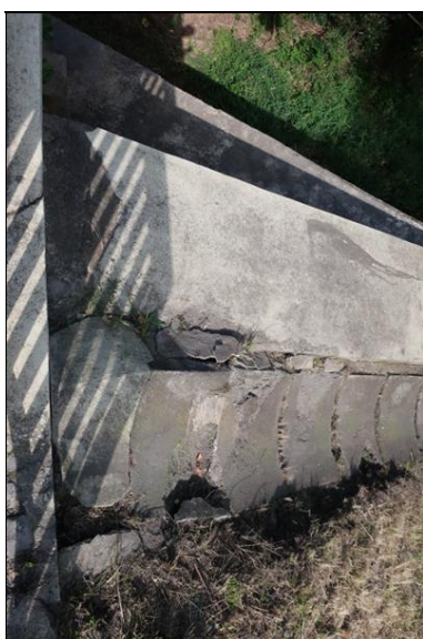
drobné poruchy spárování podél odvodňovacího skluzu
