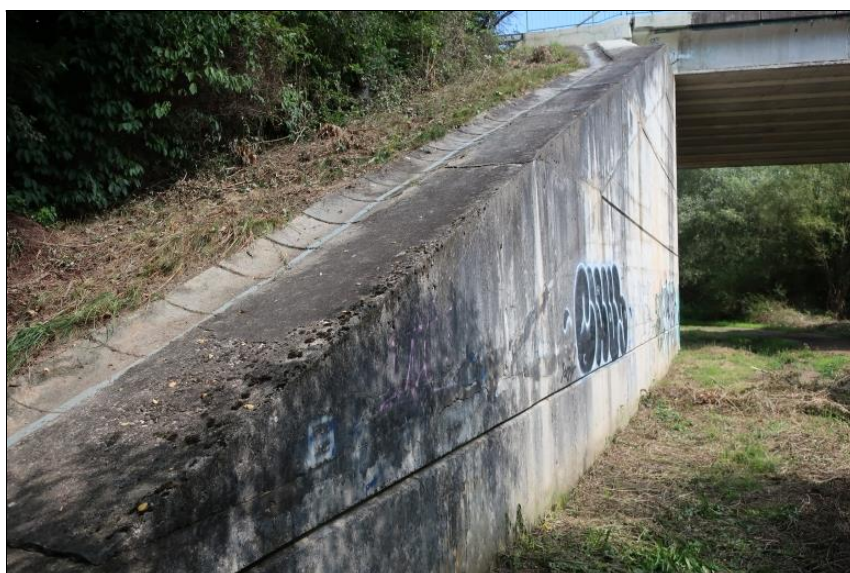
levé křídlo O4
