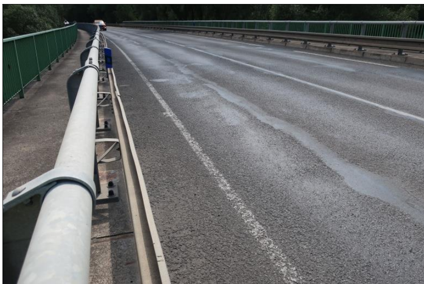
degradace betonu v nášlapné hraně římsy
