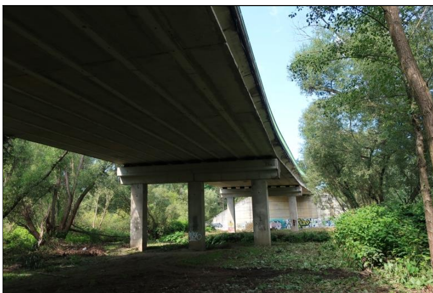
podhled NK od O1
