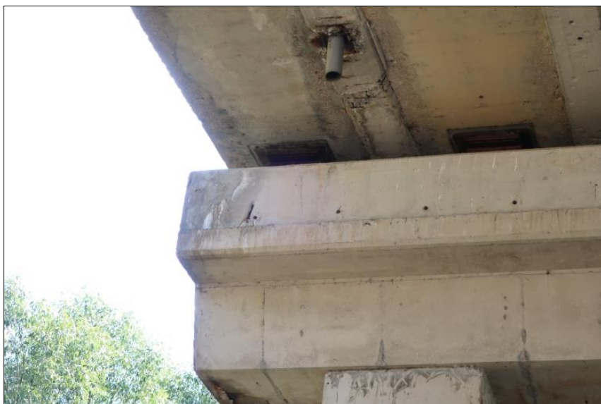
svod odvodňovače u P3
