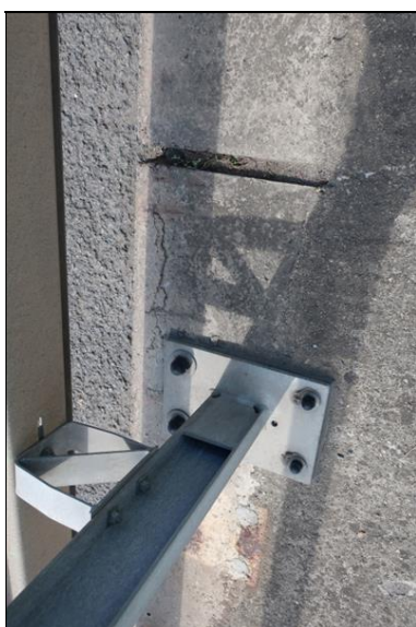
degradace betonu v nášlapné hraně římsy
