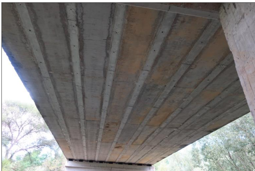
podhled NK ve 2. poli
