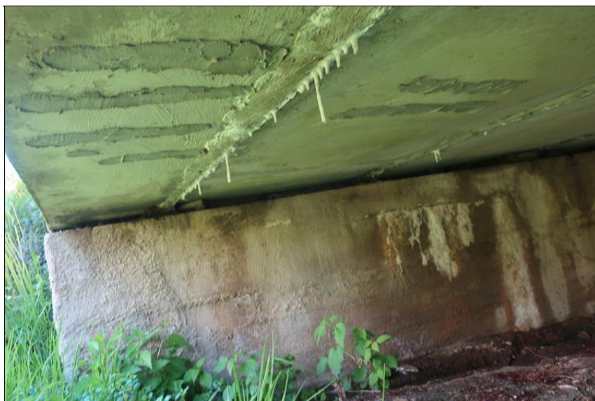
podhled 1. a 2. nosníku před O2
