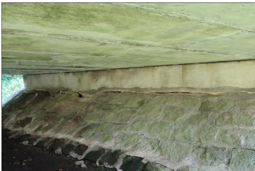
pohled na líc opěry
