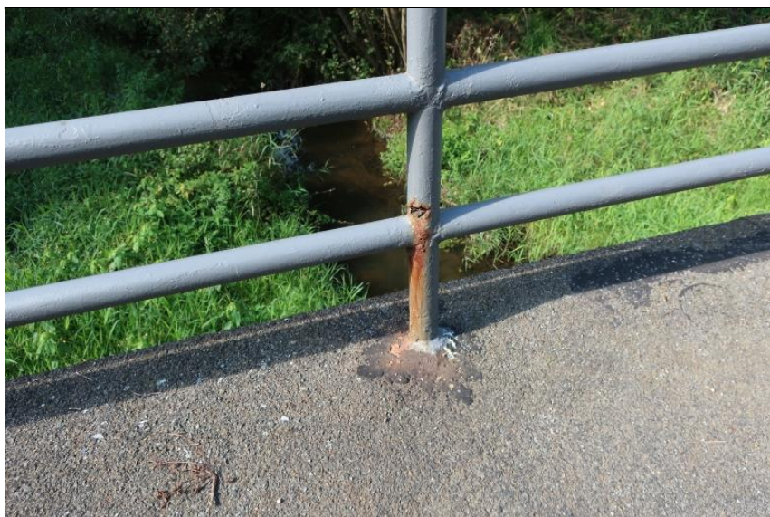
koroze zábradlí
