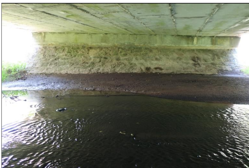
intenzivní průsaky na líci opěry
