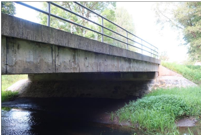
pohled na most
