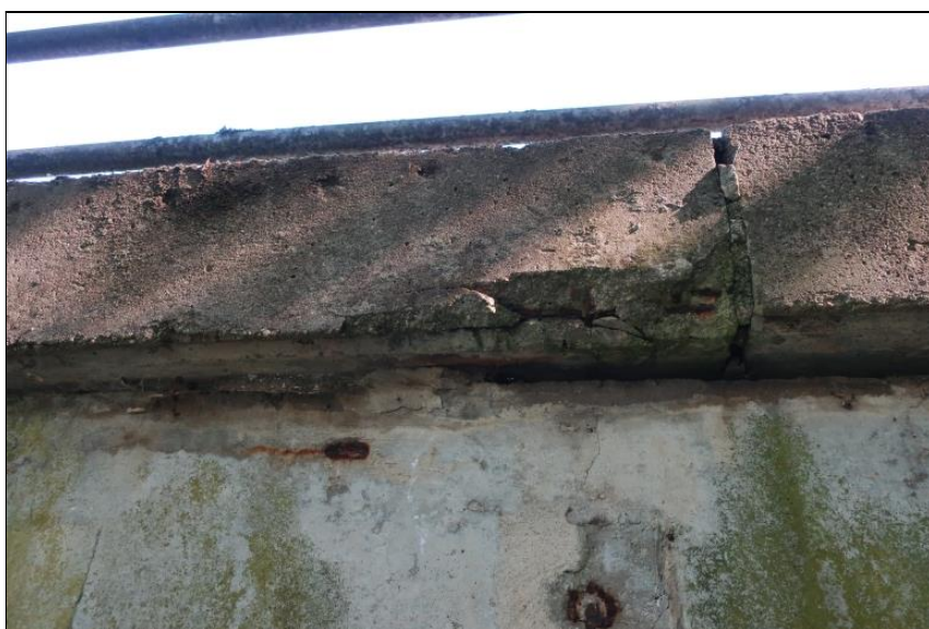
separace krycí vrstvy nad korodující výztuží římsového prefabrikátu
