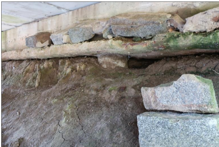
obnažená hlava piloty pod ÚP O1
