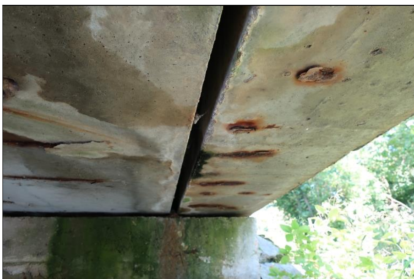
průsak sparou mezi 1. a 2. nosníkem u O1
