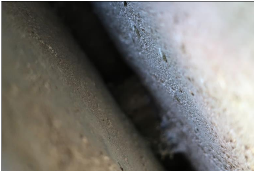
volná spára mezi nosníky - detail
