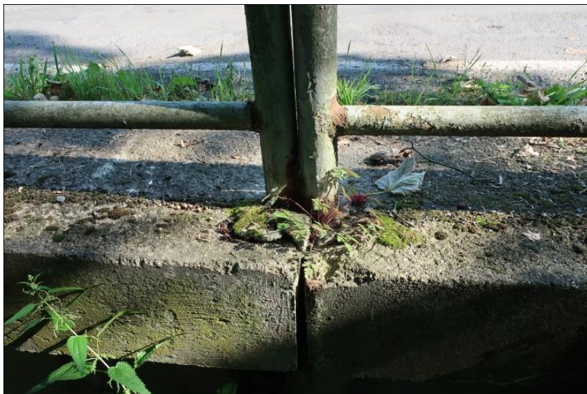
koroze zábradlí
