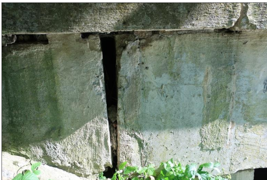
dilatační spára nad O1 zprava
