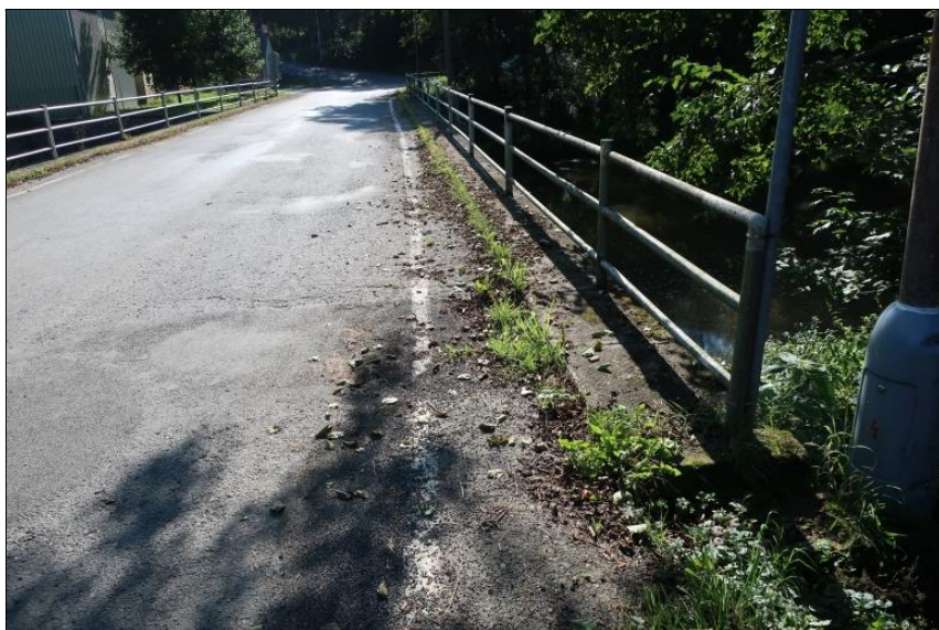
vegetace a nánosy podél pravé římsy
