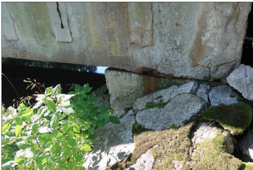
uložení levého krajního nosníku na O1
