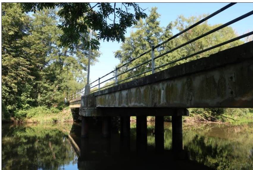
celkový pohled na most
