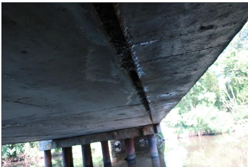
otevřená spára mezi 1. a 2. nosníkem před O3
