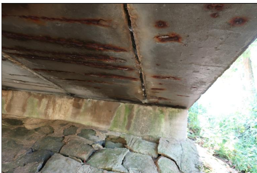
uložení NK na O3 vpravo intenzivní průsaky
