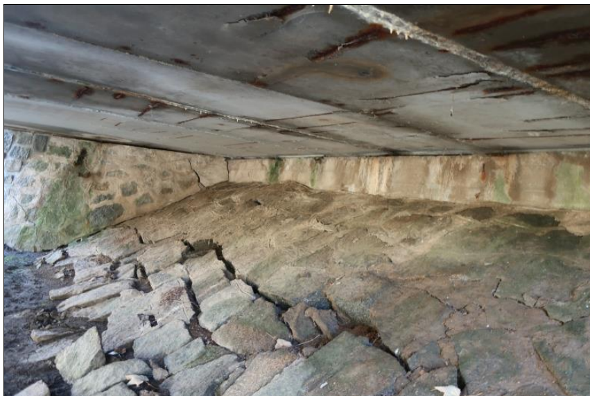
příčný podhled NK před O3
