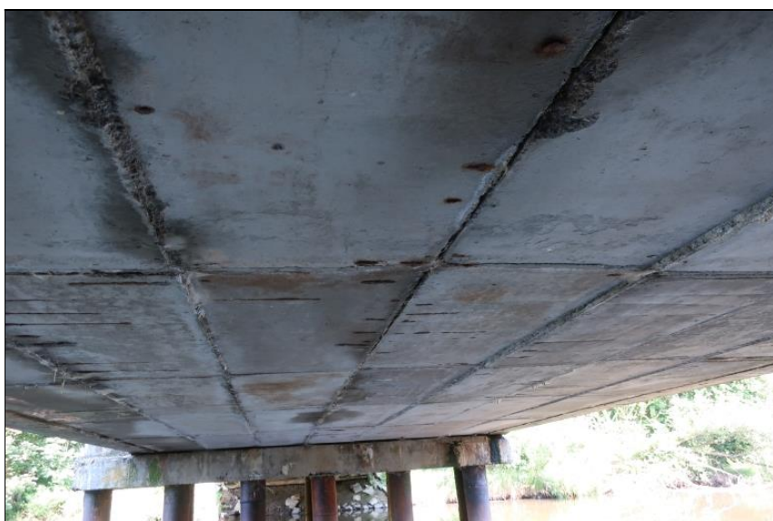
celkový podhled NK ve 2. poli od O3
