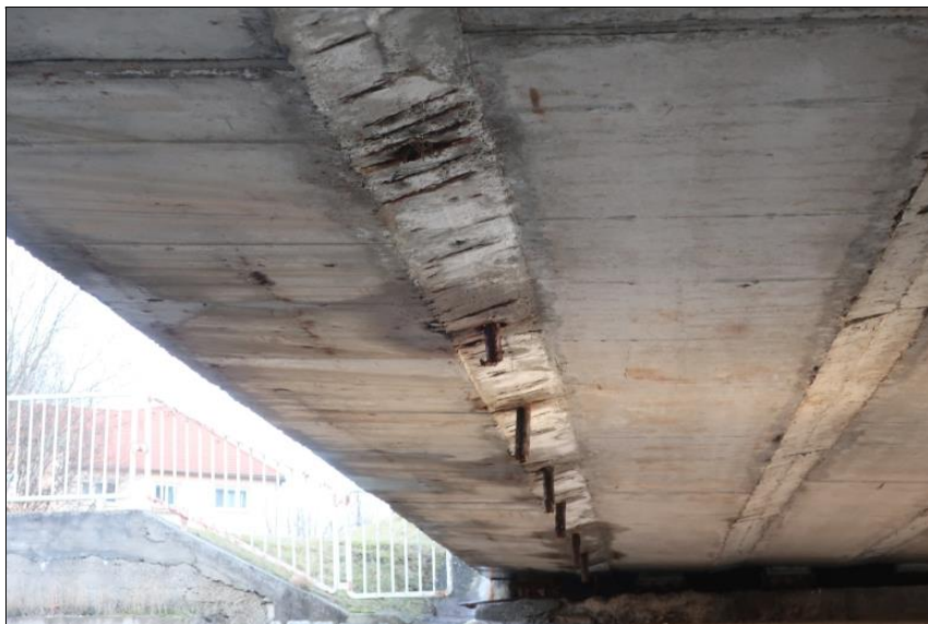
podhled 8. a 9. nosníku od O2
