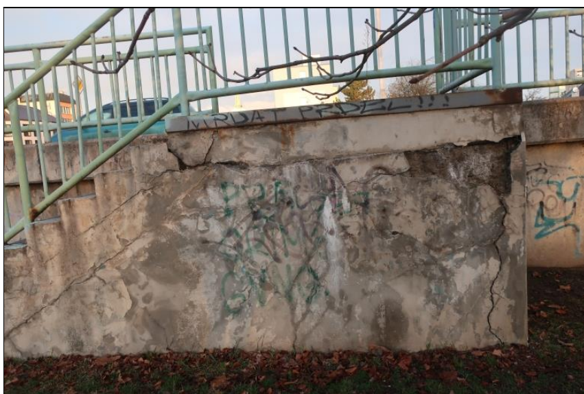
schodiště vlevo za O2
