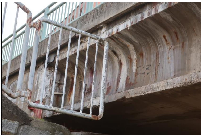
uložení 9. nosníku na O9
