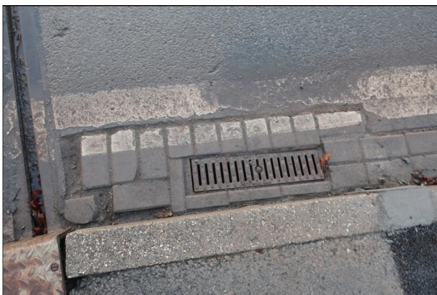
dodatečně provedený odvodňovač vpravo za O2
