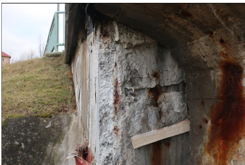
hloubková degradace betonu a intenzivní korze výztuže závěrné zídky O1
