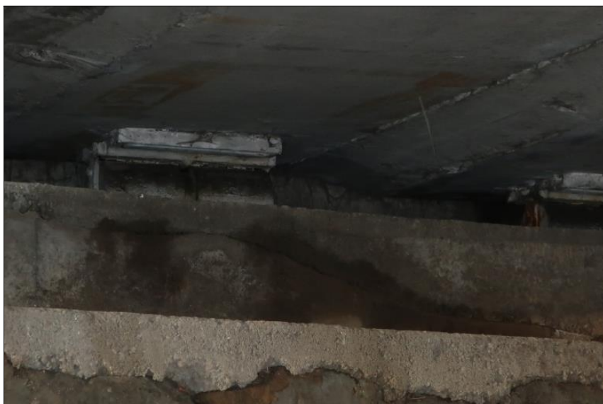
stopy po průsacích na líci O2
