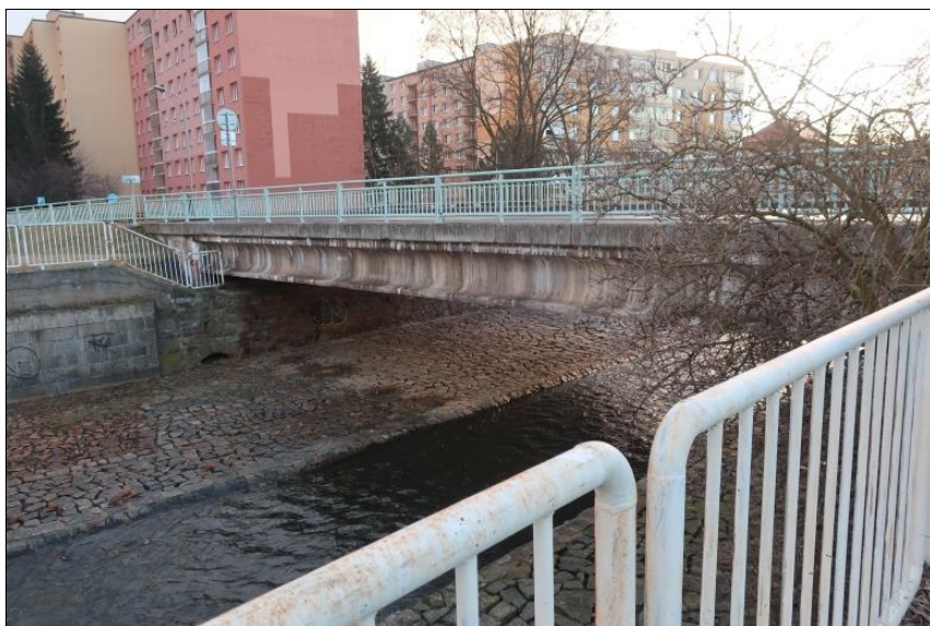
pravý bok mostu od O2
