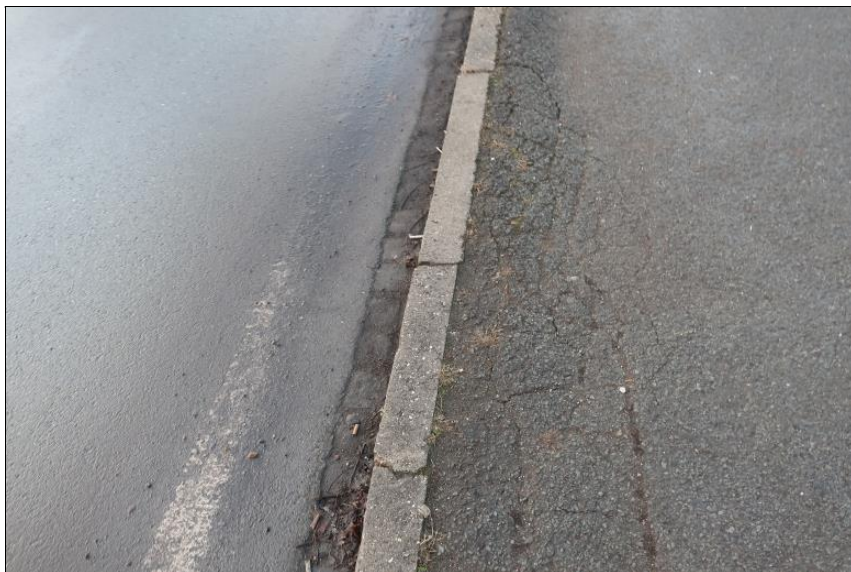
deformace krytu chodníku podél obruby
