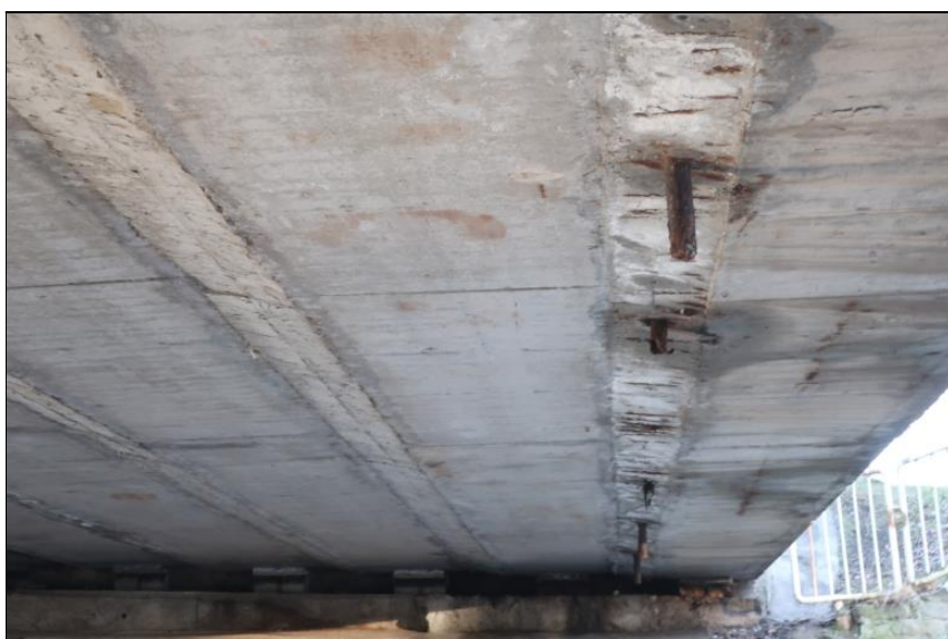
podhled 8. a 9. nosníku od O1
