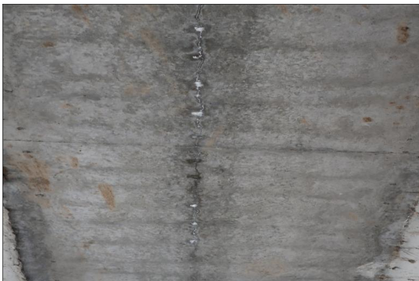
podélná trhlina na spodním líci nosníku s výluhy pojiva
