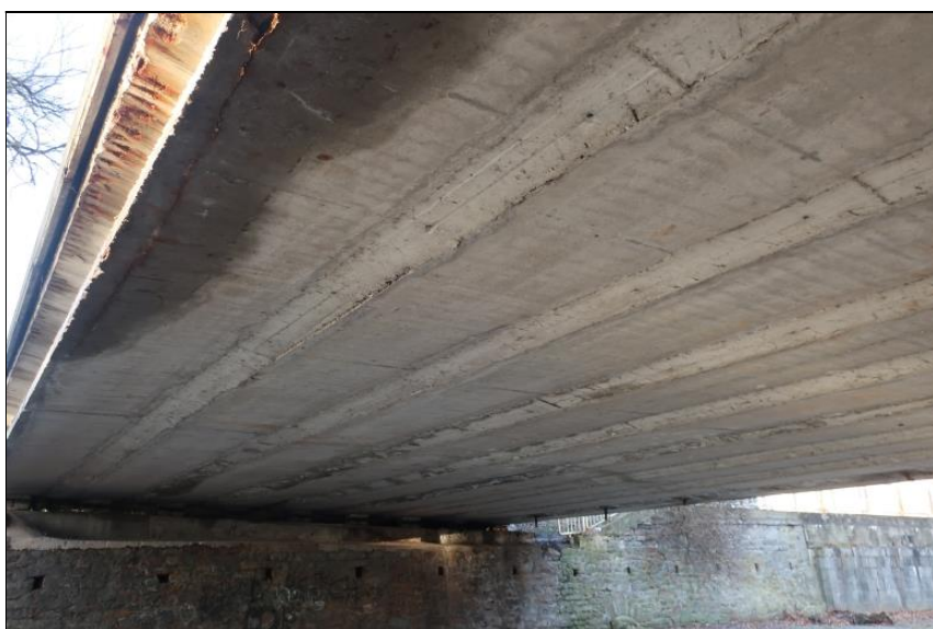
podhled NK od O1
