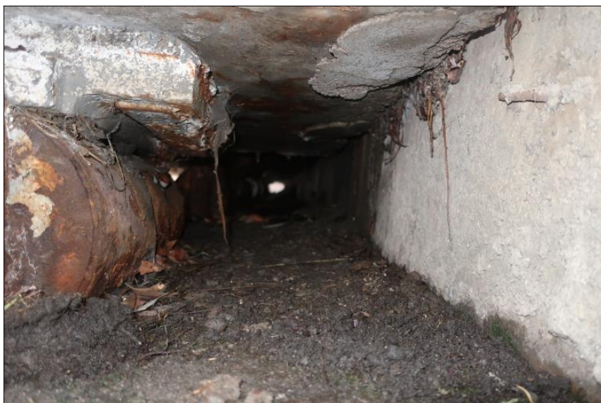
nánosy na ÚP O2 koroze 9. ložiska na O2
