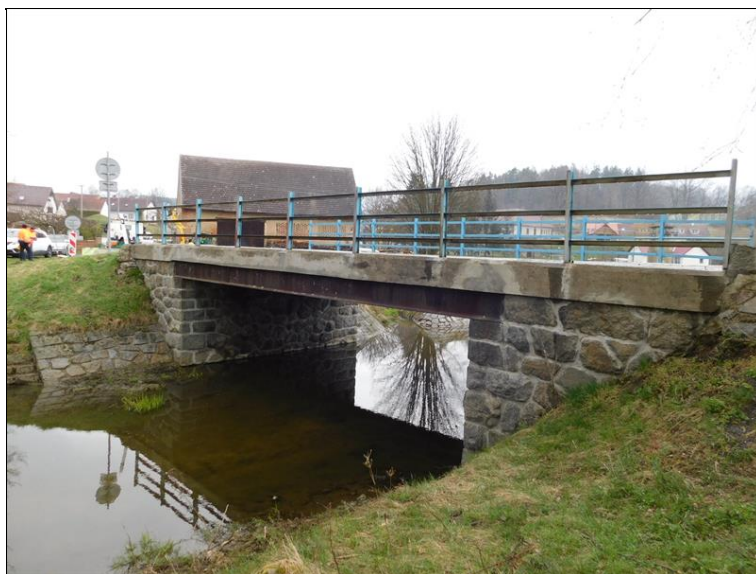
Pohled na pravou stranu mostu
