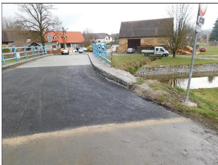
Zvýšené obrubníky na předmostí
