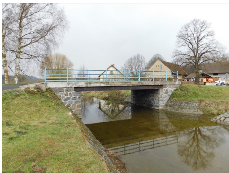
Pohled na levou stranu mostu
