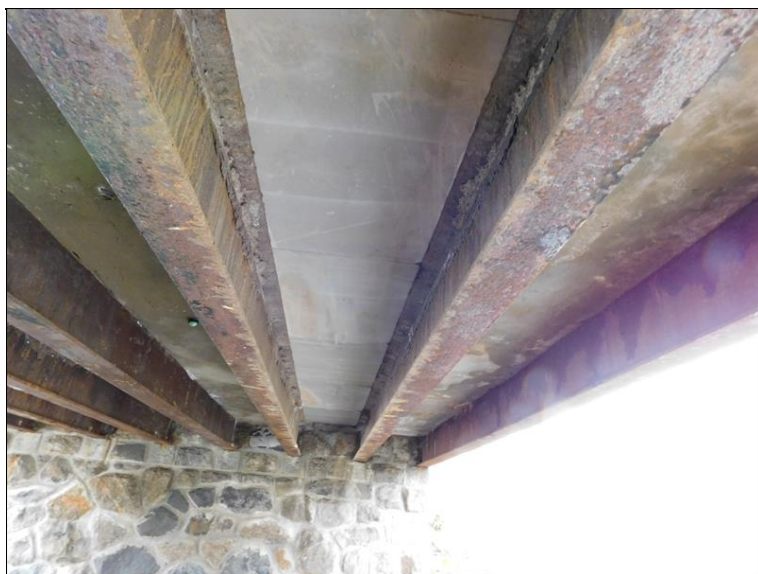
Opravená deska mezi nosníky v místě prolomení původní konstrukce
