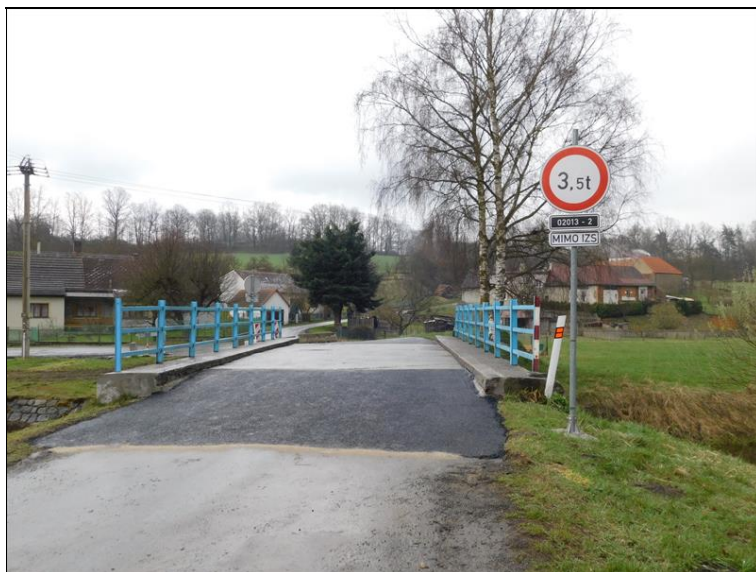
Pohled na most po směru staničení
