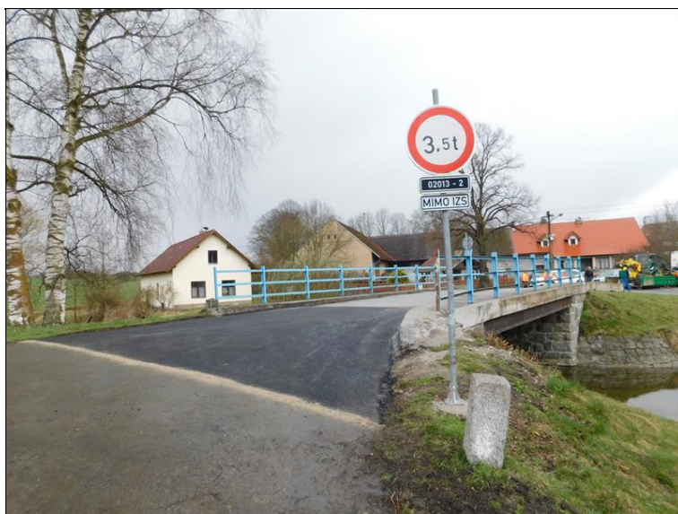
Pohled na most proti směru staničení
