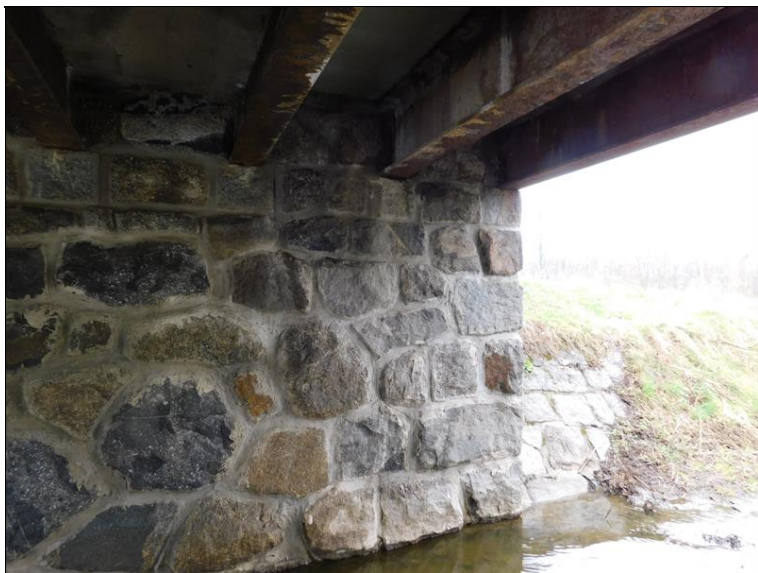
Krajní část opěry 2 na pravé straně - na snímku je patrné uložení krajních nosníků v těsné blízkosti okraje opěry
