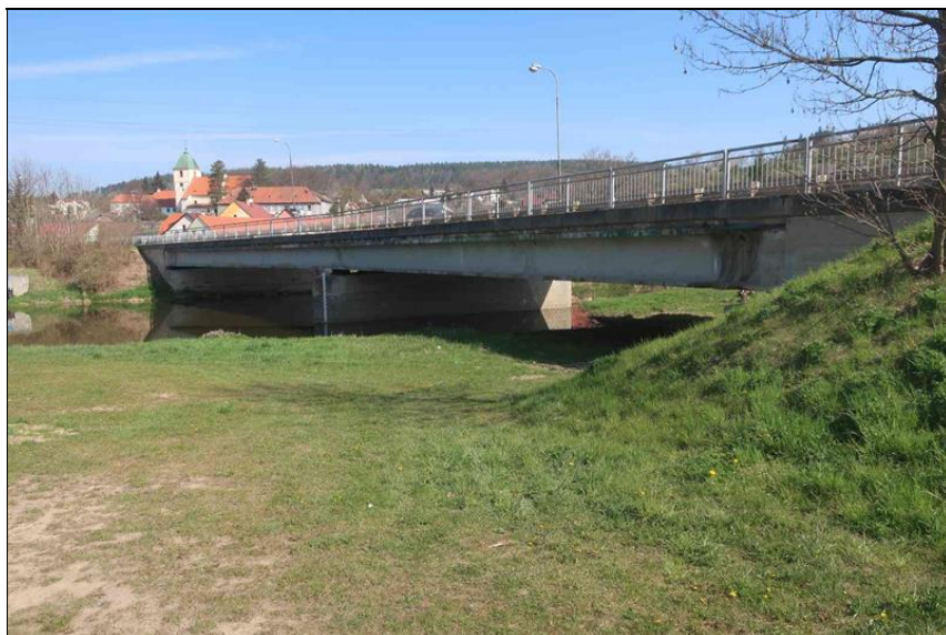
pohled na pravou stranu mostu od opěry 3
