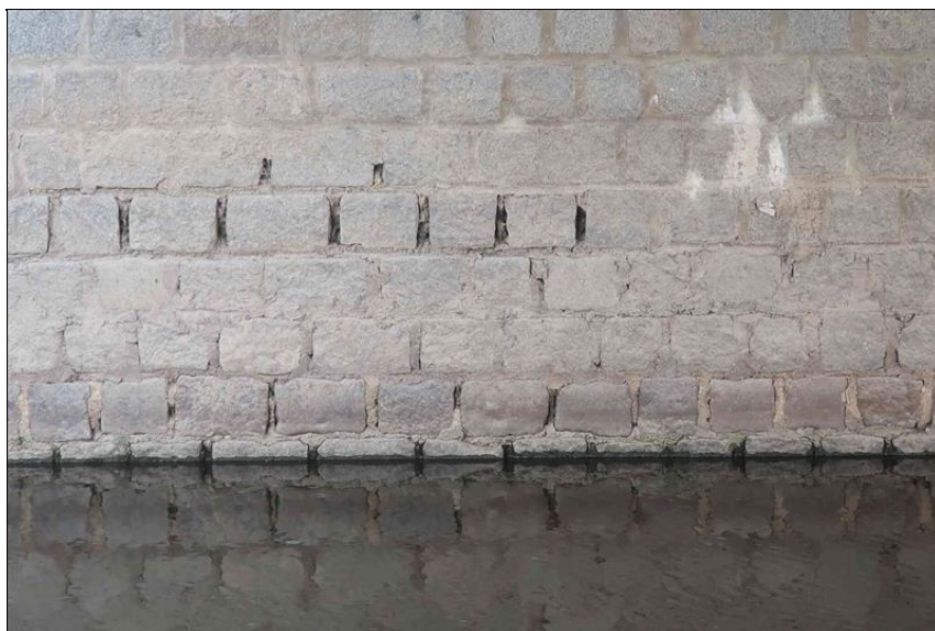
poruchy spárování obkladního zdiva dířku P2
