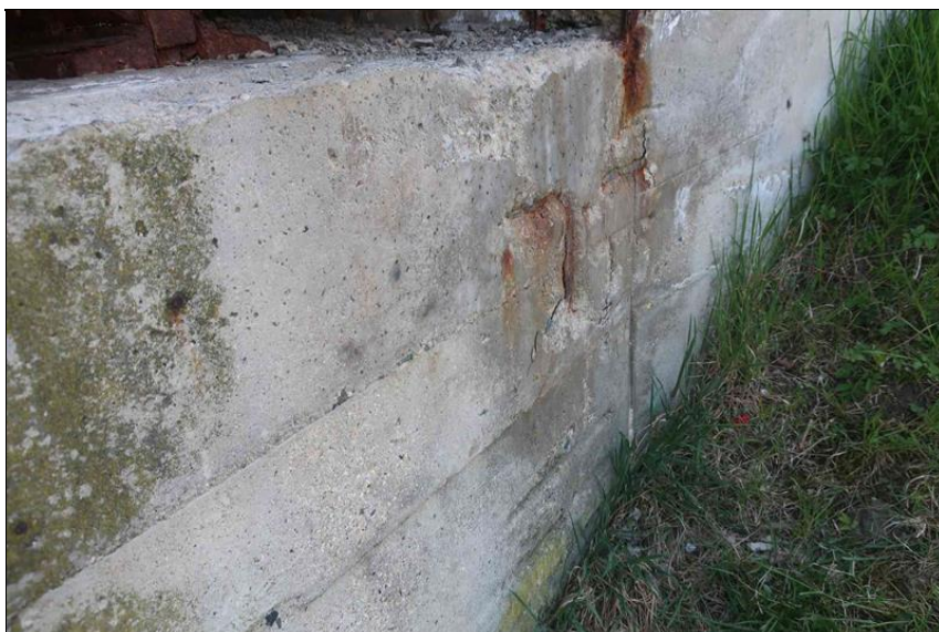
stopy po průsaku z ÚP O3 na její pravý bok
