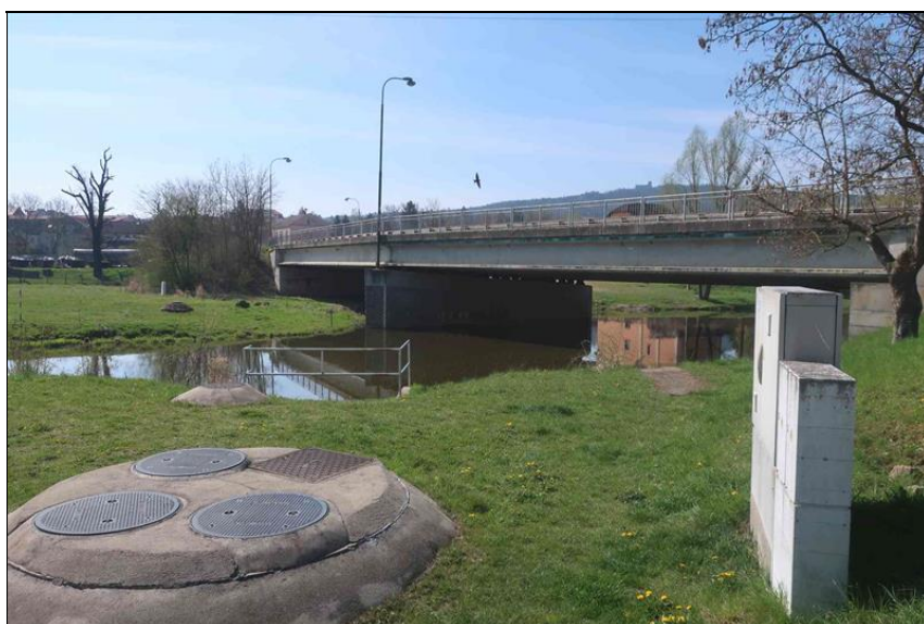
pohled na levou stranu mostu
