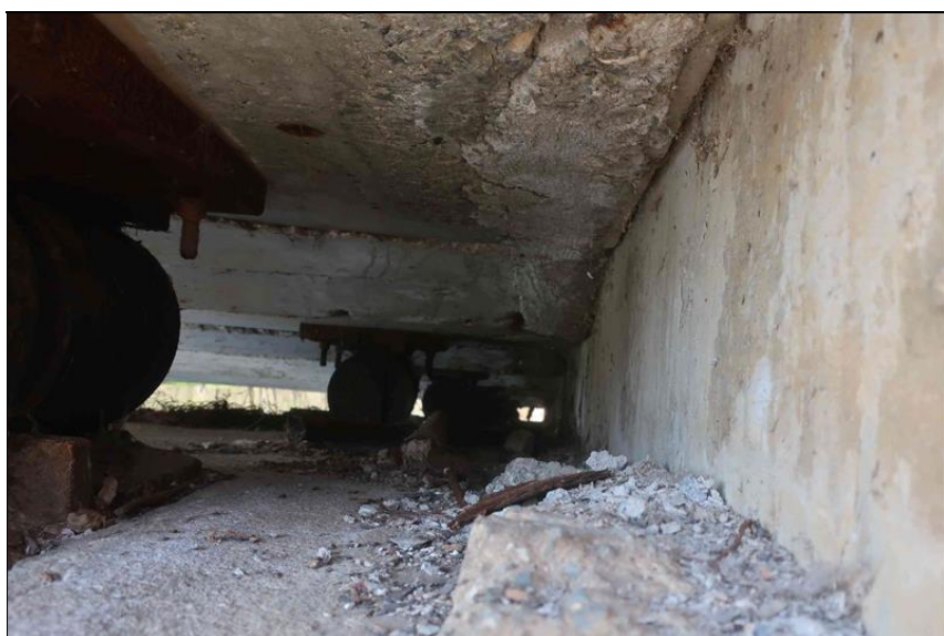
nánosy na ÚP O1, stopy po průsacích na líci ZZ
