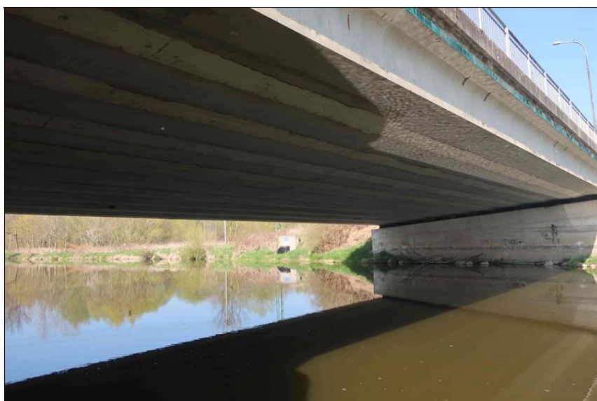
podhled NK v 1. poli
