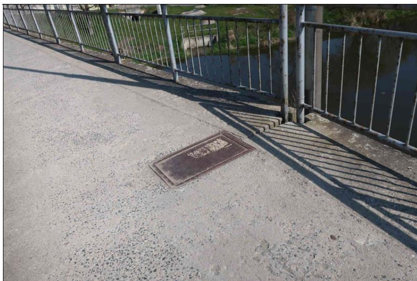
poklop šachty IS v krytu levého chodníku nad P2
