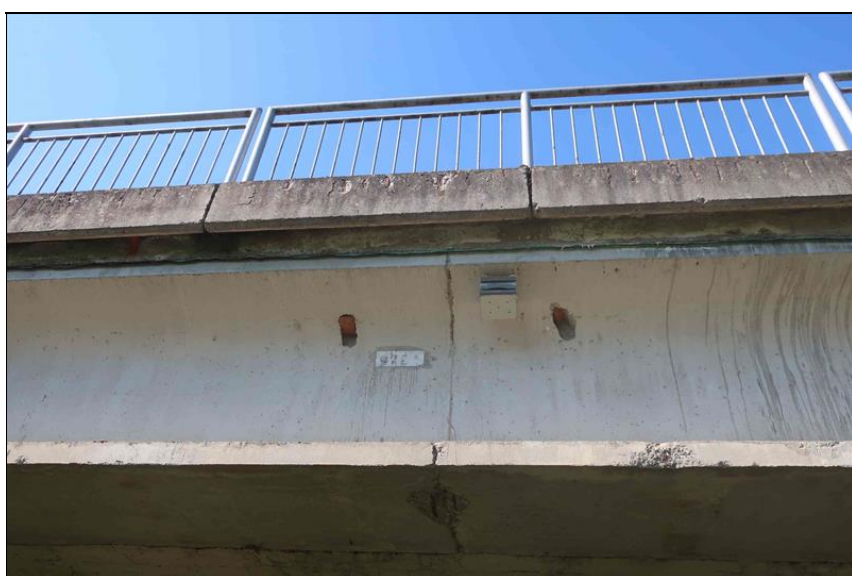
ptačí budka na vnějším boku 1. nosníku ve 2. poli
