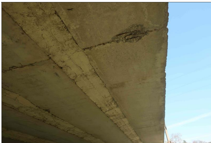
separace krycí vrstvy nad korodující výztuží na spodním líci nosníku ve 2. poli v okolí příčné pracovní spáry mezi dílci nosníku
