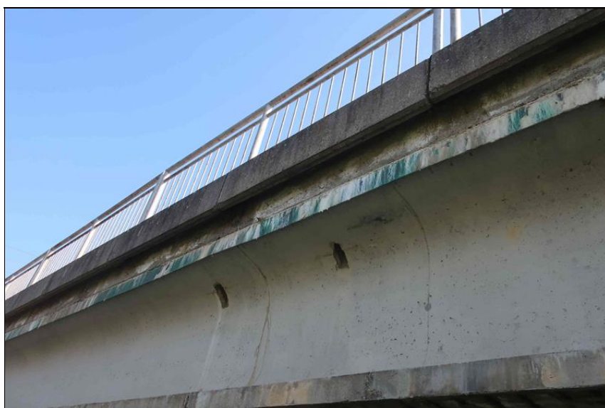
intenzivní výluhy pojiva na okapním plechu
