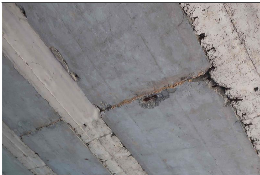
separace krycí vrstvy nad korodující výztuží na spodním lici nosníku ve 2. poli v okolí příčné pracovní spáry mezi dílci nosníku
