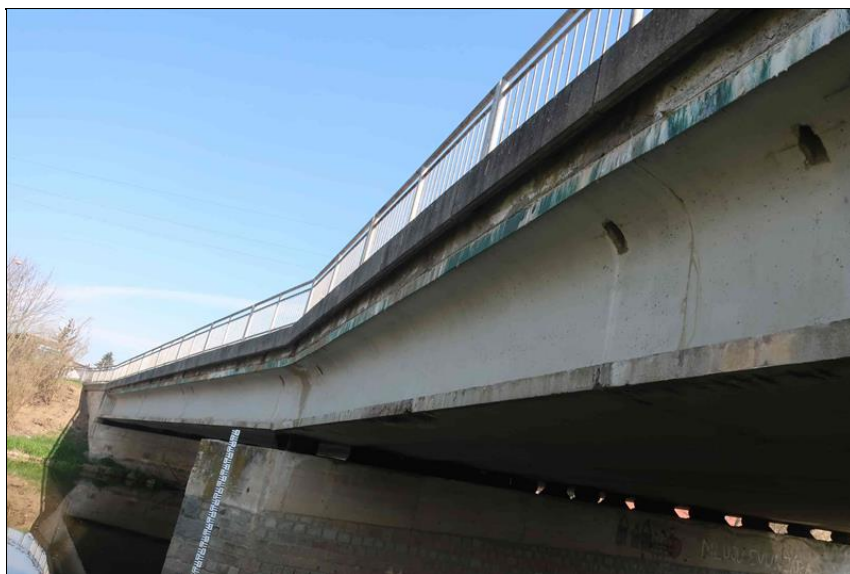
pravá strana NK - pohled z 2. pole
