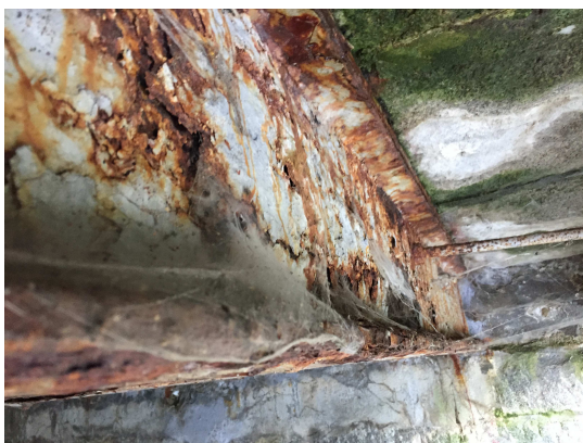
Konstrukce ocelových nosníků zasažena korozí
