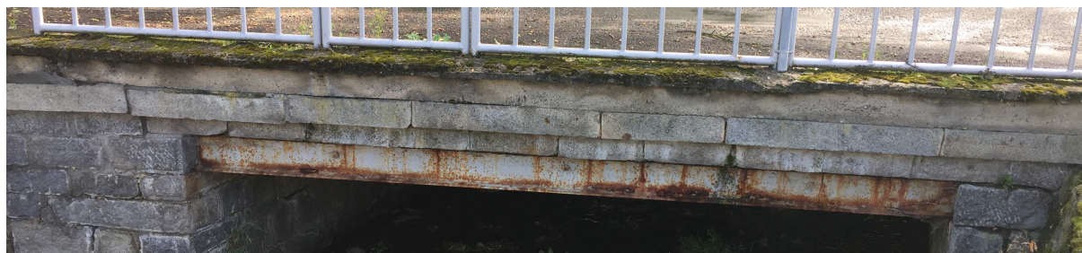
Skladba na ocelových nosnících nad kamennou částí opěry
