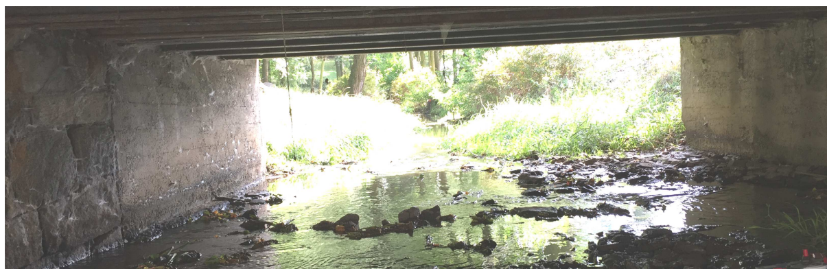
Návaznost nové betonové části na starší kamennou
