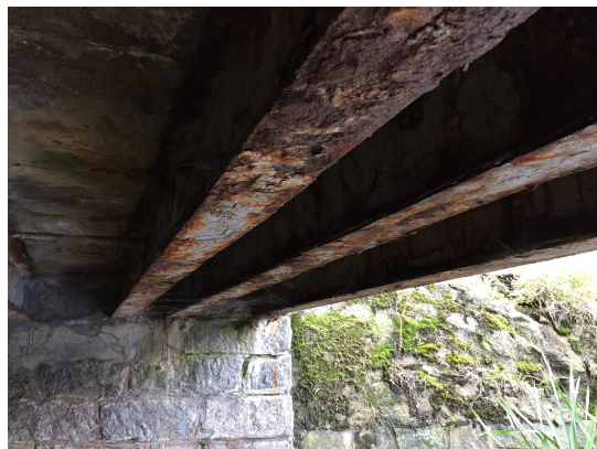
Konstrukce ocelových nosníků zasažena korozí
