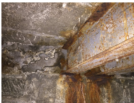
Konstrukce ocelových nosníků zasažena korozí, protékání vody do uložení nosníků
