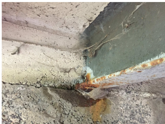
Konstrukce ocelových nosníků zasažena korozí, protékání vody do uložení nosníků
