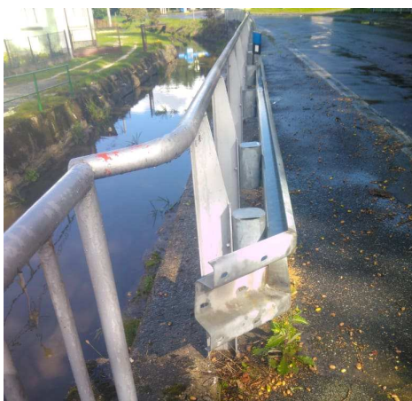
Stávající zakončení svodidla před zábradlím mostu
