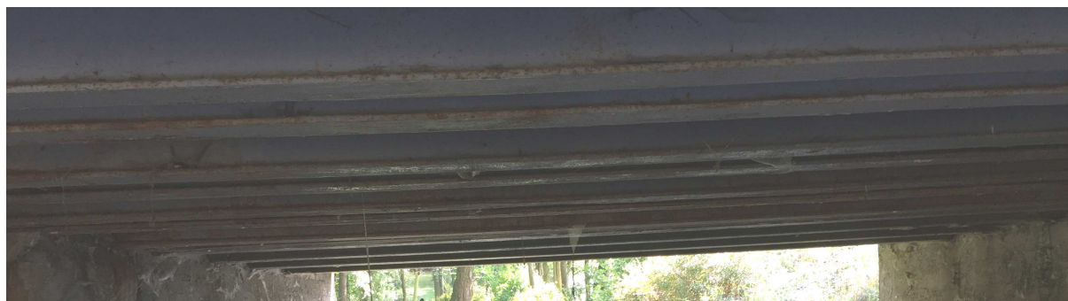
Nosná konstrukce - ocelové nosníky
