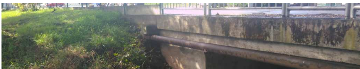
Skladba na ocelových nosnících nad betonovou částí opěry
