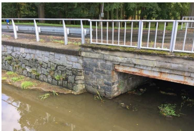
Stávající zakončení svodidla před zábradlím mostu
