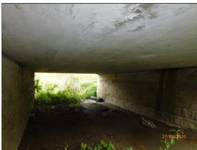
Podhled NK ve 3. poli.
