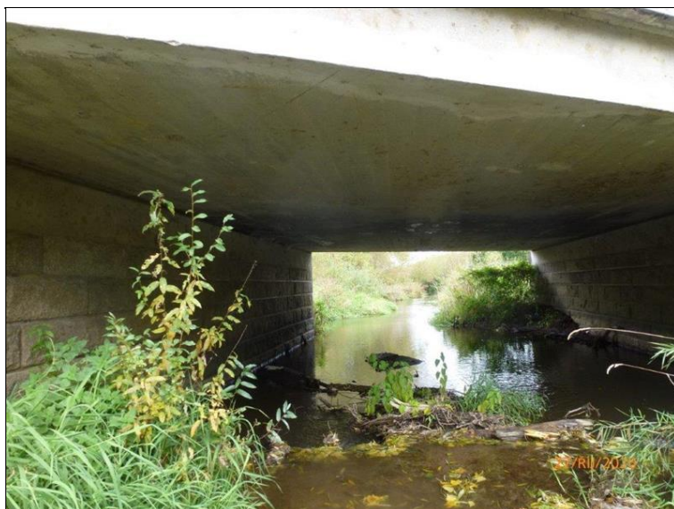
Podhled NK ve 2. poli.
