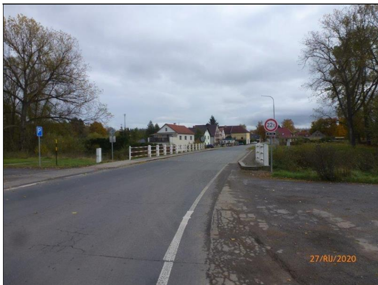
Pohled na most ve směru staničení.
