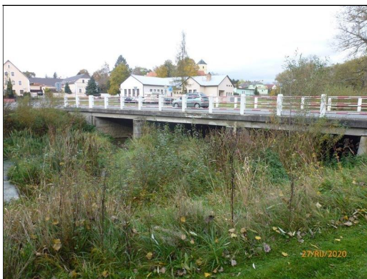
Pohled na pravou (návodní) stranu mostu od OP4.
