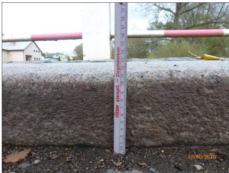
Výška žulové obruby na levé straně.
