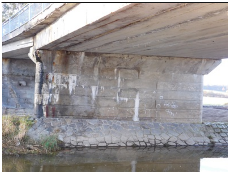
Pohled na pilíř 2
