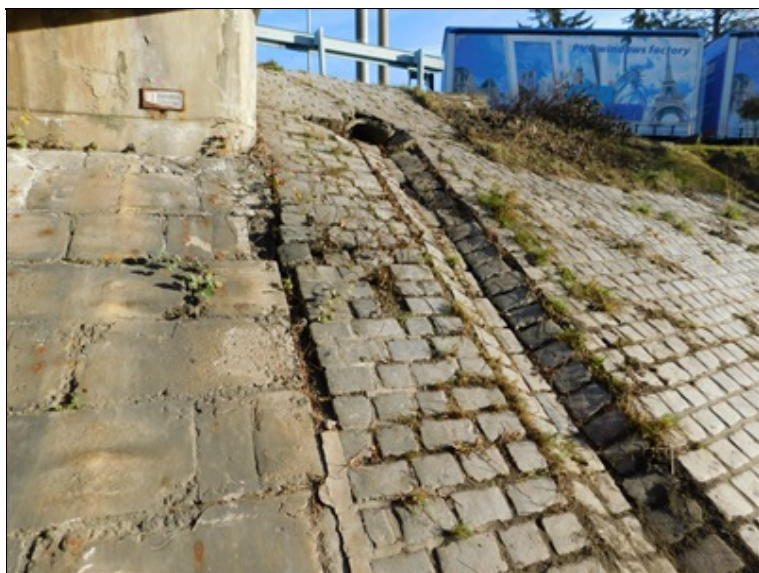
Opevnění svahu podél opěry 4
