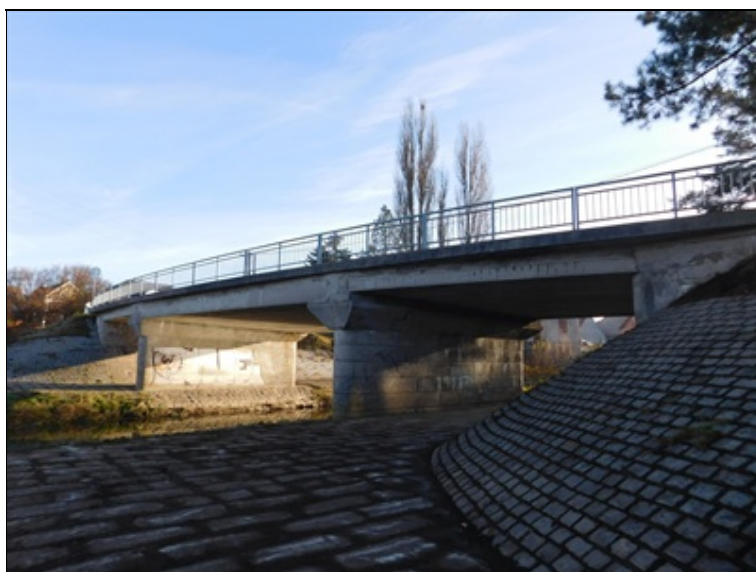
Pohled na most z levé strany
