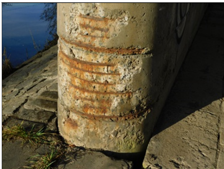
Pata dříku opěry 3
