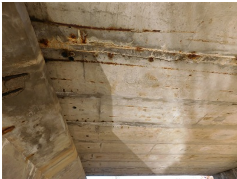
Spodní líc nosné konstrukce v poli 3
