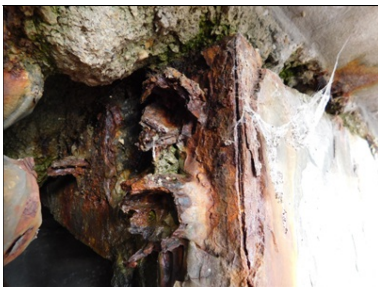
Kotvy pravého krajního nosníku nad pilířem 2
