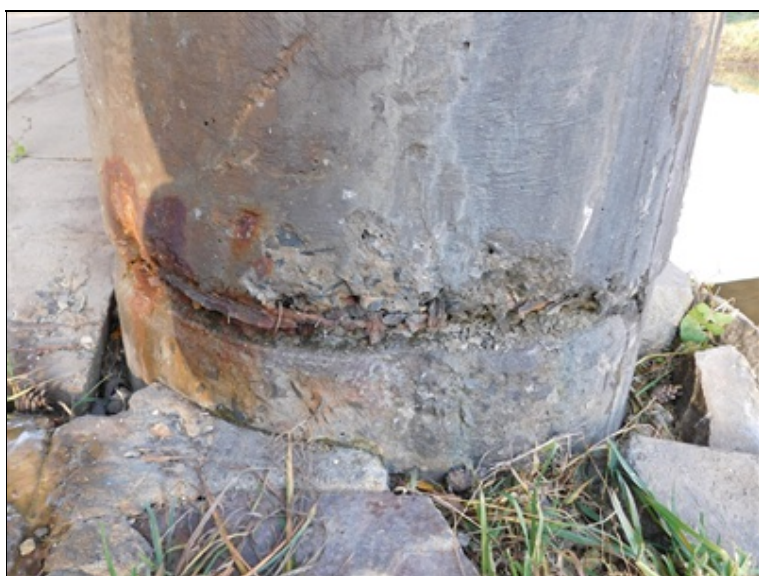
Pata dříku pilíře 2 na pravé straně
