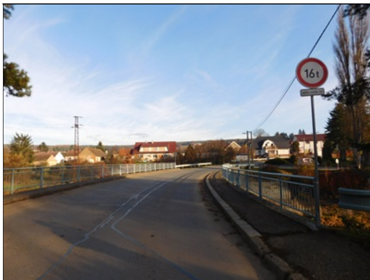
Pohled po směru staničení
