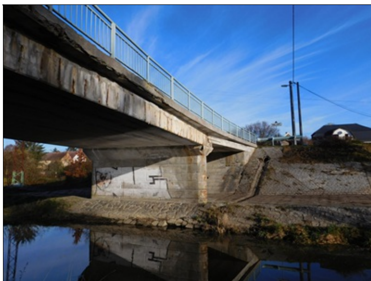
Pravá strana mostu
