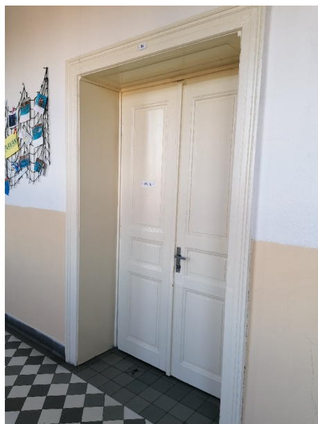
VSTUPNÍ DVEŘE DO UČEBEN NEVYHVOUJÍ POŽADÁVKŮM BEZBARIÉROVOSTI. PŘI OTEVŘENÍ AKTIVNÍHO KŘÍDLA JE ZAJIŠTĚN VOLNÝ PRŮCHOD 650 mm. S OHLEDEM NA HISTORICKOU HODNOTU BUDOVY BYLO DOHODNUTO SE ZÁSTUPCI ŘÍDÍCÍHO VÝBORU NŘM VLÁDY ČR PŘI KONZULTACÍCH DNI DNE 5. BŘEZNA 2020 ŽE SE TYTO DVEŘE PONECHAJÍ VE STÁVAJÍCÍM STAVU A POKUD BUDE POTŘEBA ZAJIŠTIT BB PRŮCHOD, ZAJIŠTÍ OTEVŘENÍ OBOU DVEŘNÍCH KŘÍDEL ŽÁCI ČI PEDAGOGICKÝ PERSONÁL. JE VYCHÁZEJO ZE SKUTEČNOSTI, ŽE IMOBILNÍ OSOBA SE PO BUDOVĚ NEBUDE POHYBOVAT SAMÁ A BUDE VŽDY MOŽNOST JI TÍMTO OPATŘENÍM ZAJIŠTIT BB PŘÍSTUP DO UČEBEN. TOTO OPATŘENÍ SE TYKA VŠECH NADZEMNÍCH PODLAŽÍ S UČEBNAMI (1.NP - 4.NP)
