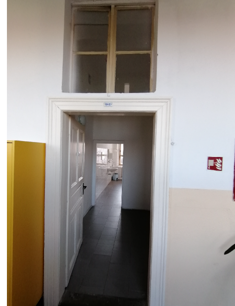
STÁVAJÍCÍ DŘEVĚNÉ KAZETOVÉ DVEŘE SE DOPLNÍ SAMOZAVÍRAČEM SE ZPOŽDOVÁNÍM ZAVÍRÁNÍ A POSILOVÁNÍM OTEVÍRÁNÍ PRO BB DVEŘNÍ KŘÍDLA (NAPŘ. GEZE TS5000S ECLINE)
