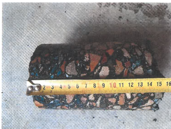
Jádrový vývrt č.5
