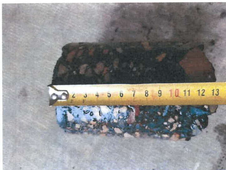
Jádrový vývrt č.3
