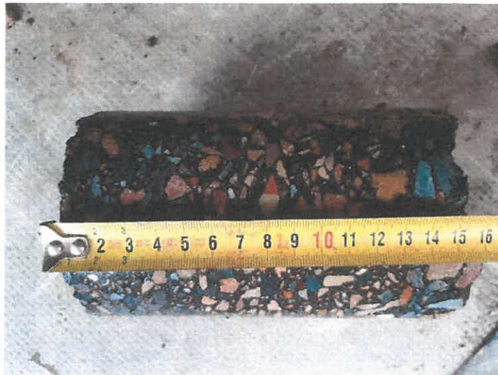
Jádrový vývrt č. 1
