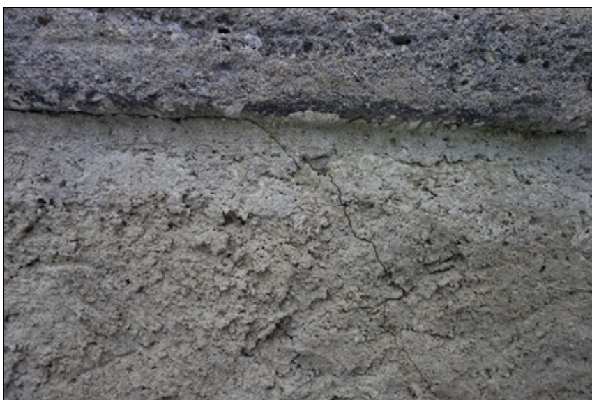
Trhlina v zábradlí 015 DSC01620.JPG
