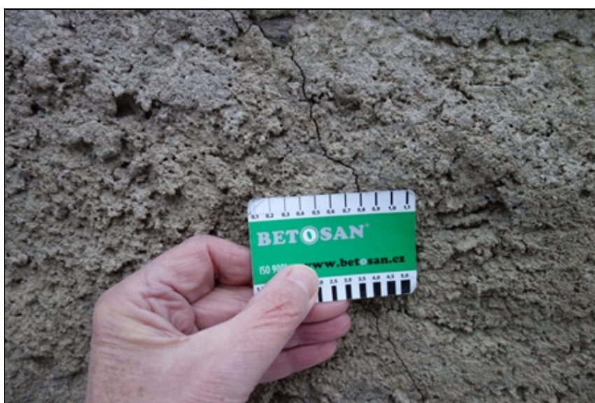
Trhlina v zábradlí 018 DSC01623.JPG
