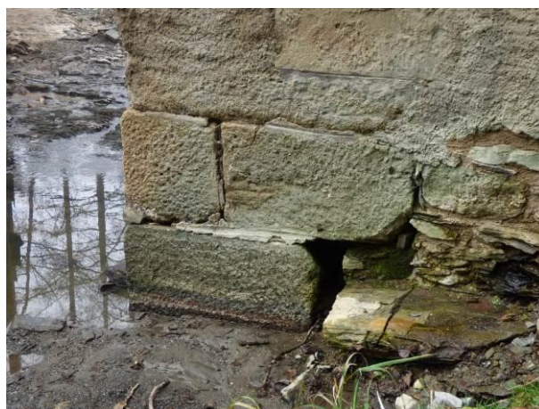
Obrázek 2: Rozvolněné zdivo a dutiny u paty jižní strany žihelské opěry
