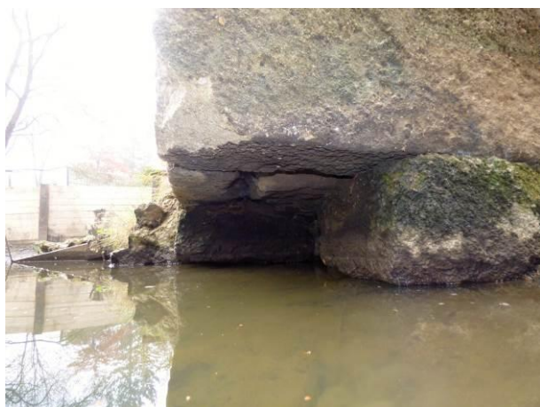
Obrázek 1: Vypadlý kvádr lícového zdiva na jv. nároží středního pilíře
