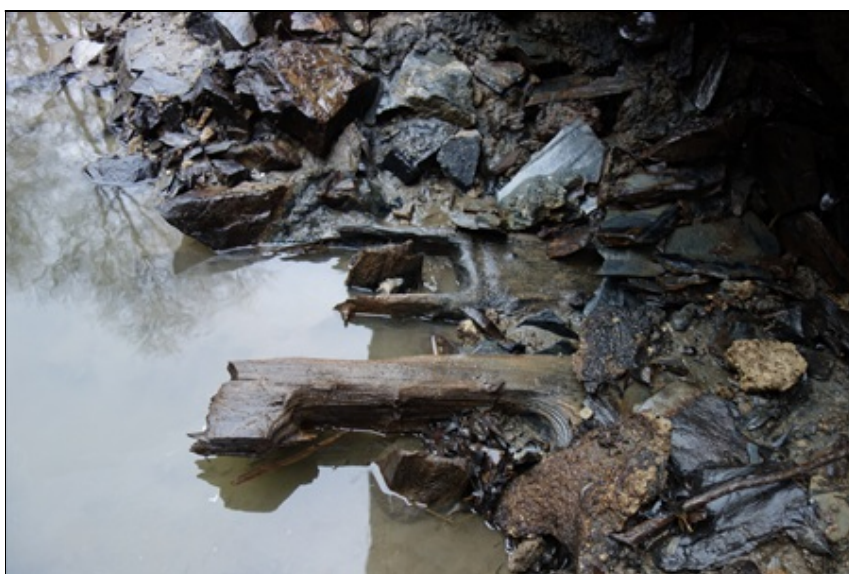
Obnažený dřevěný rošt pod povodním koncem středního pilíře 012 DSC01651.JPG
