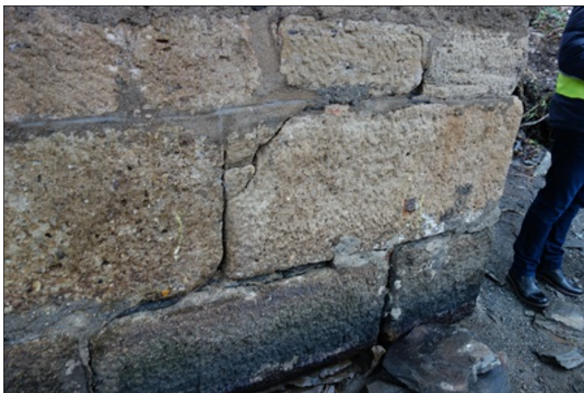
Rozvolněné zdivo povodního konce levobřežní opěry 008 DSC01636.JPG
