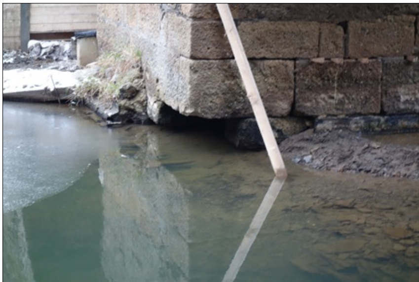
Otvor po vypadlém kvádru - střední pilíř, počátek snižování hladiny 010 DSC01631.JPG
