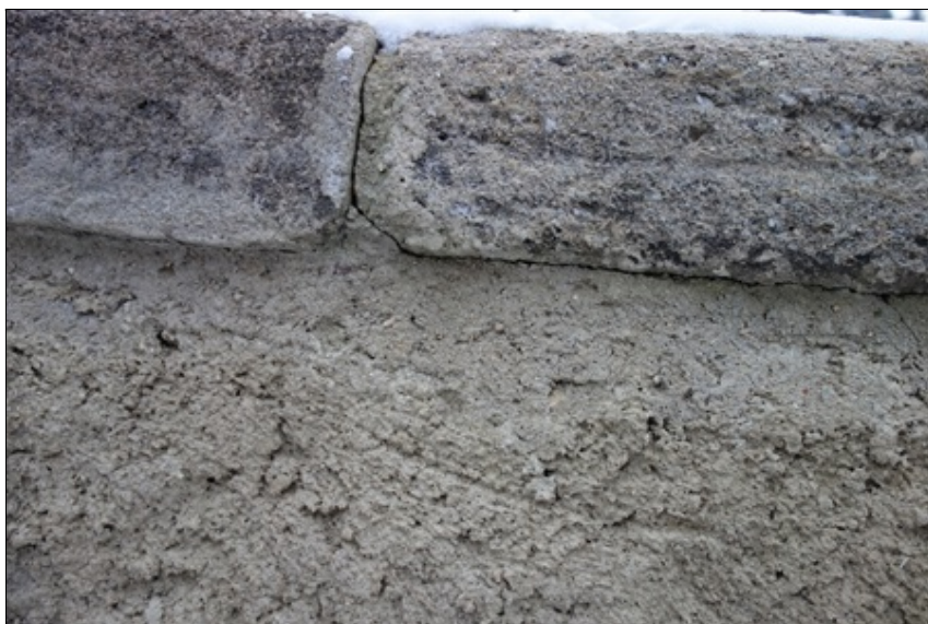
Trhlina v povodním zábradlí 014 DSC01619.JPG
