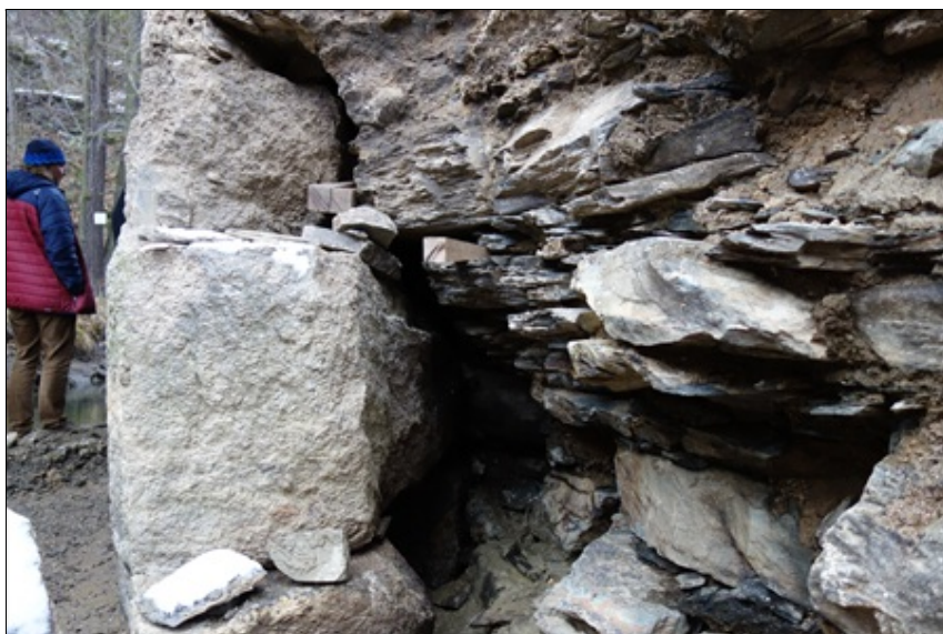
Pohled z protivodní strany do kaverny za lícovým zdívem středního pilíře 011 DSC01637.JPG
