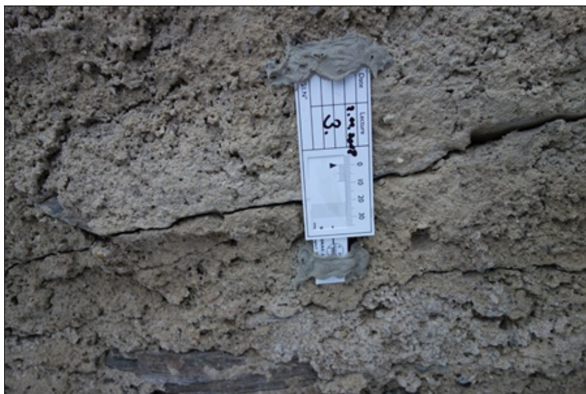
Trhlina v zábradlí 019 DSC01624.JPG
