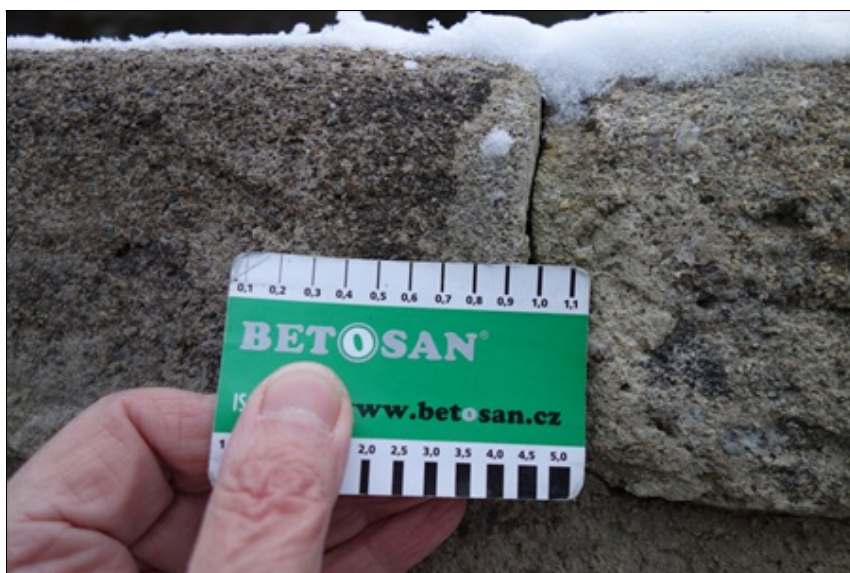
Trhlina v zábradlí 017 DSC01622.JPG
