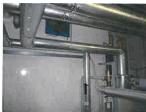
Obr. 11, 12: Výměňíková stanice SZT, v opraveném stavu jsou izolace potrubních rozvodů
