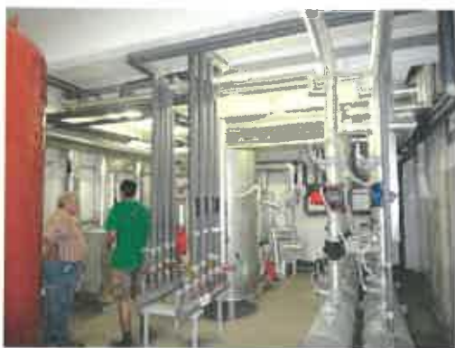
Obr. 11, 12: Výměňíková stanice SZT, v opraveném stavu jsou izolace potrubních rozvodů
