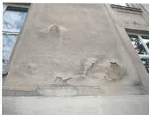
obr. 4: Na fasádě jsou praskliny, omítka odpadává
