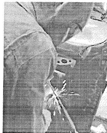
MIG pájení zachovává pevnost oceli a chrání antikorozi zinkový povrch
