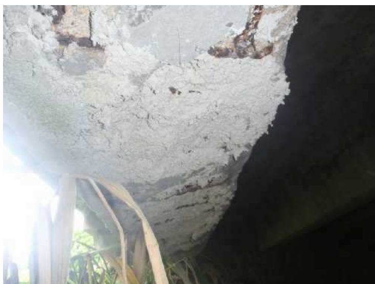
Pokus o opravu krajního trámu.
