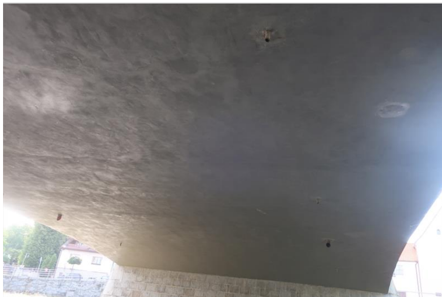
podhled NK 1. pole od O1
