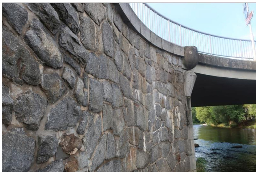
levé křídlo opěry C3
