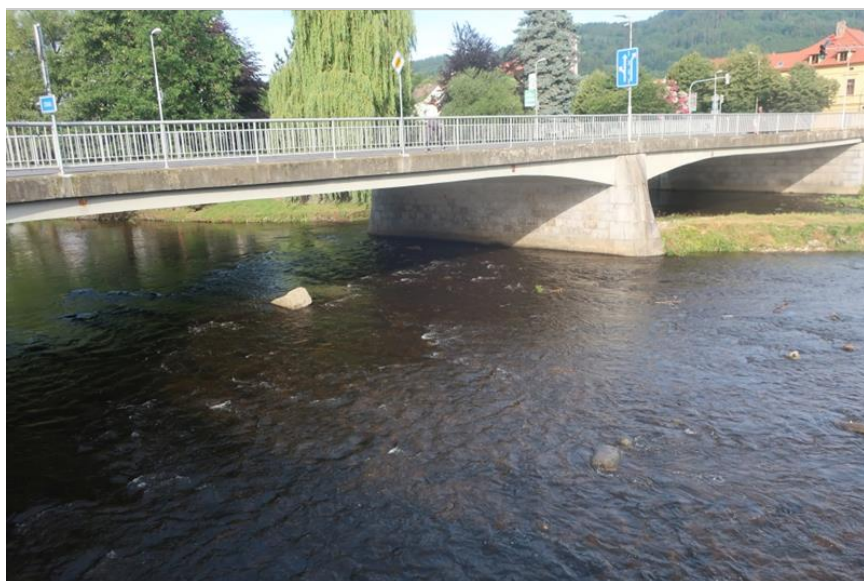
pohled na levou stranu mostu z pravého břehu
