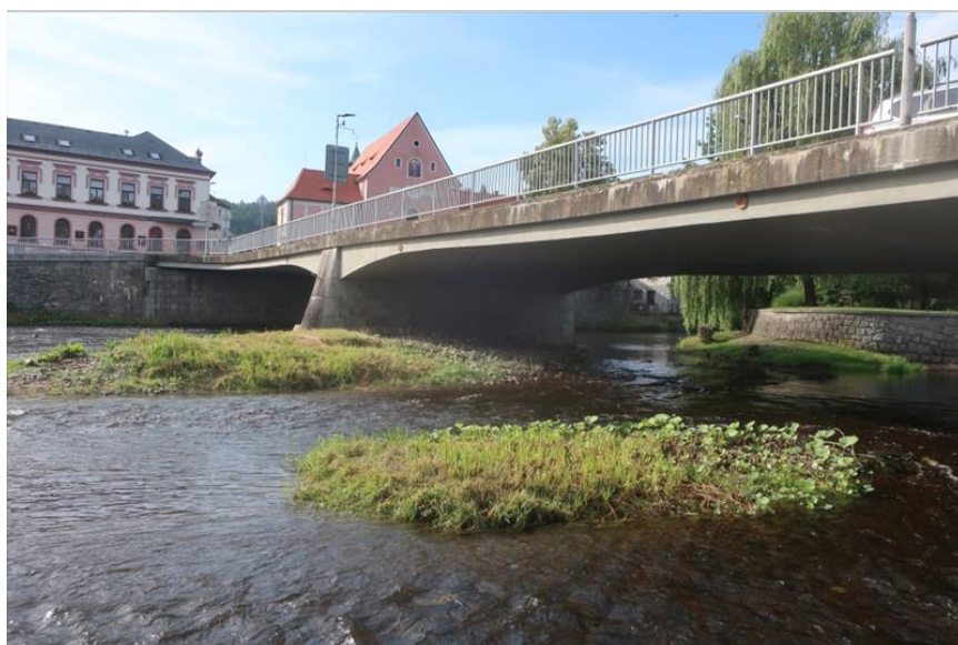
pohled na levou stranu mostu z levého břehu
