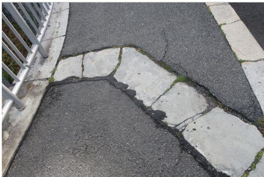
zakrytí dilatační spáry nad C3 v oblasti levého chodníku
