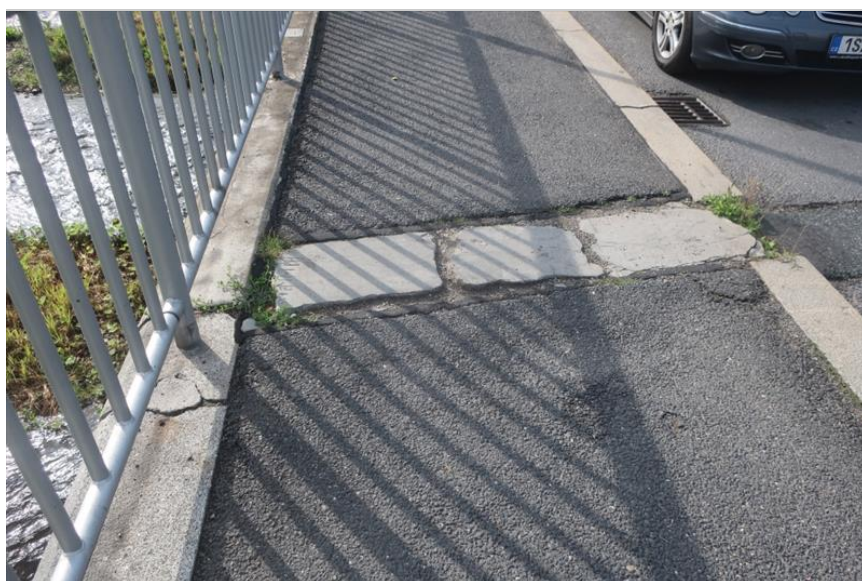
zakrytí dilatační spáry nad O1 v oblasti levého chodníku
