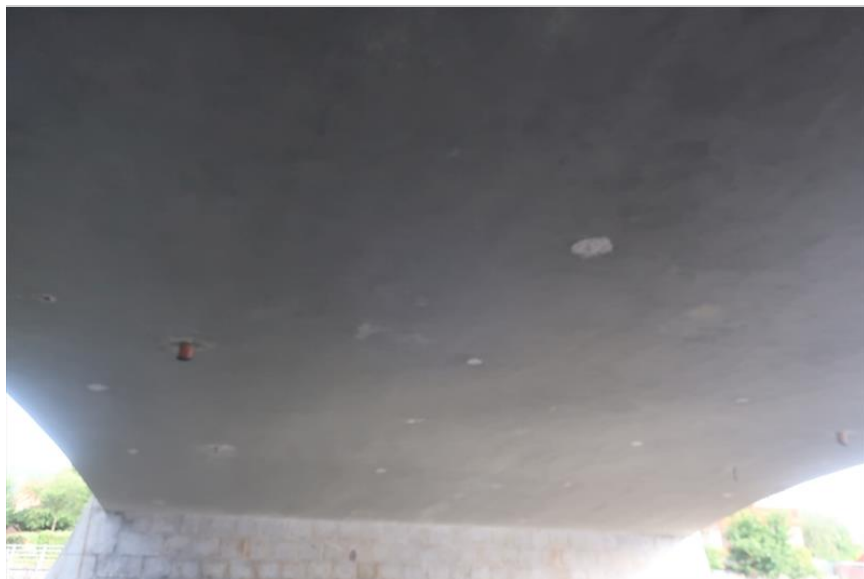
podhled NK 2. pole za pilířem P2
