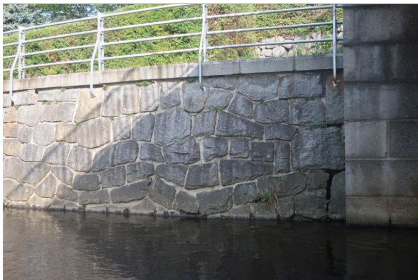
nábřežní zed' navazující na pravý bok O1
