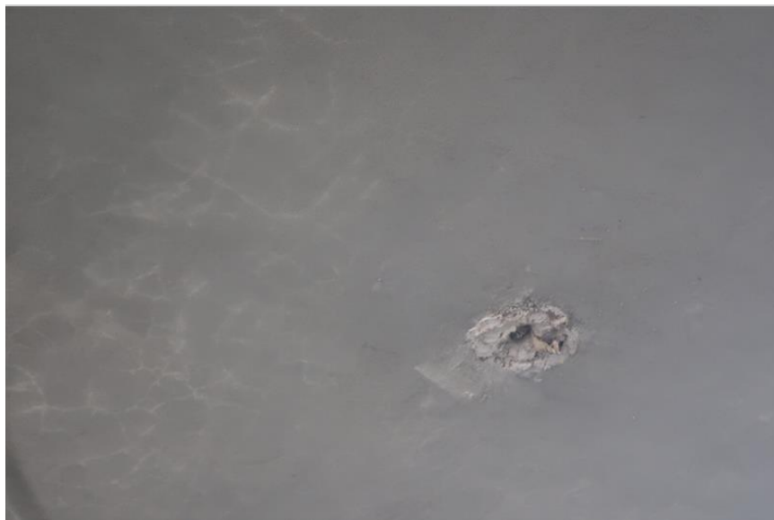
otvor na spodní lici NK 2. pole
