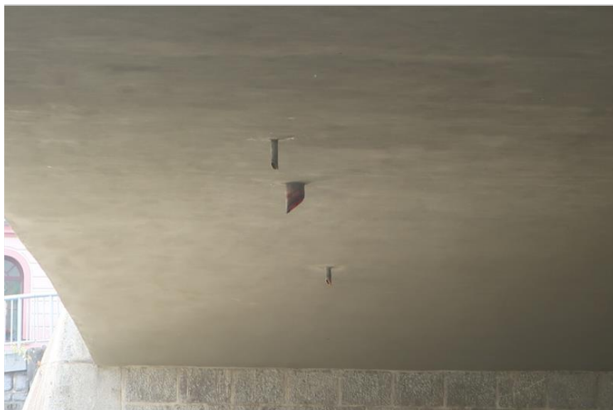
vyústění svodů odvodnění na spodním lici NK 1. pole vlevo
