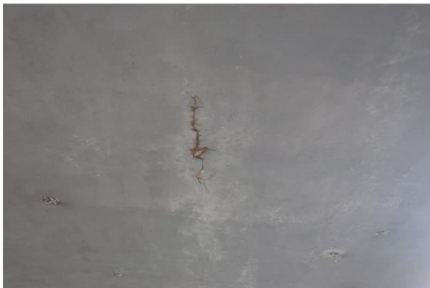
podélná trhlina se stopami po průsacích a se stopami koroze na spodním lici NK 2. pole
