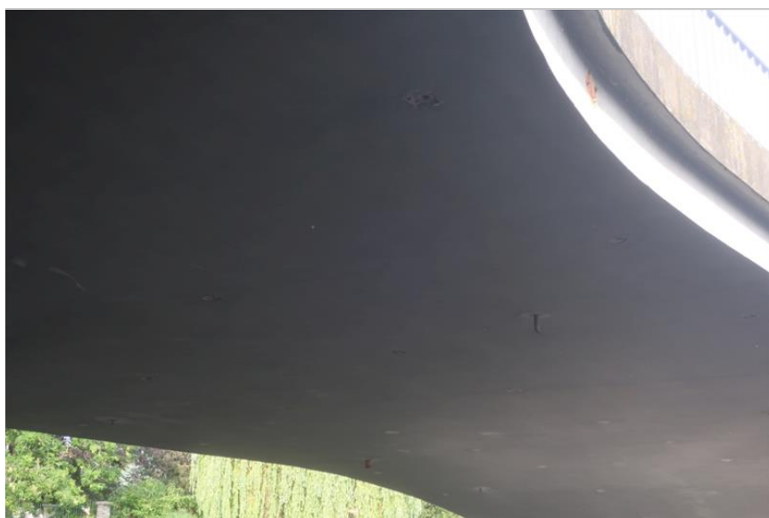
podhled NK 2. pole od O3
