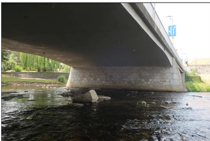
podhled NK ve 2. poli od O3 proti směru staničení
