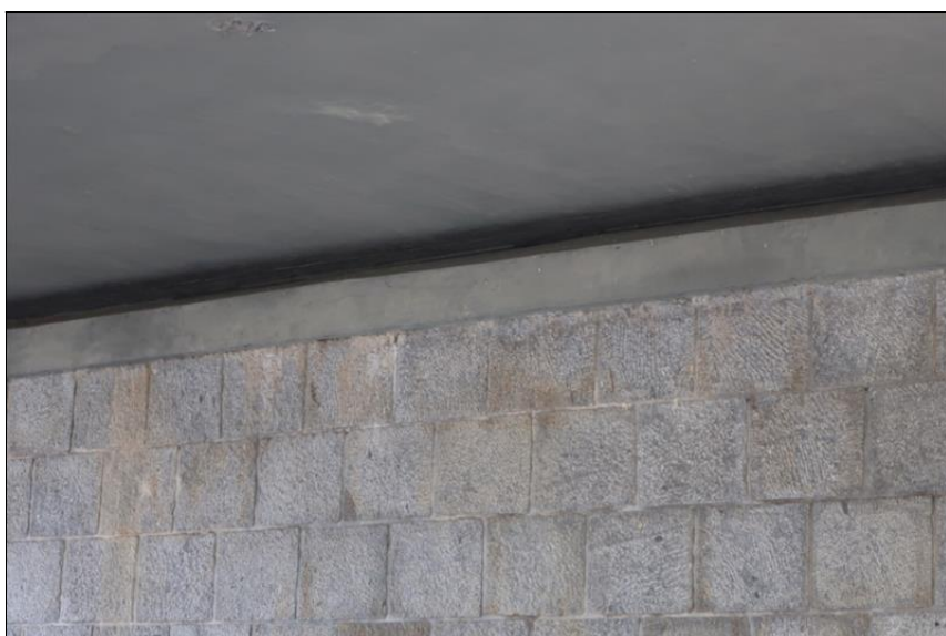
stopy po průsacích s výluhy pojiva na líci obkladního zdiva O3
