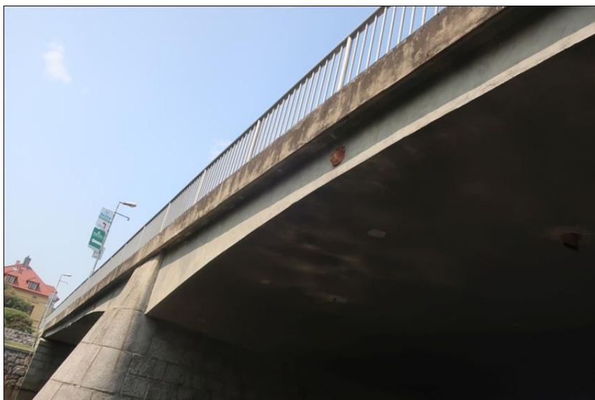
kryt otvoru v pravém boku desky 2. pole
