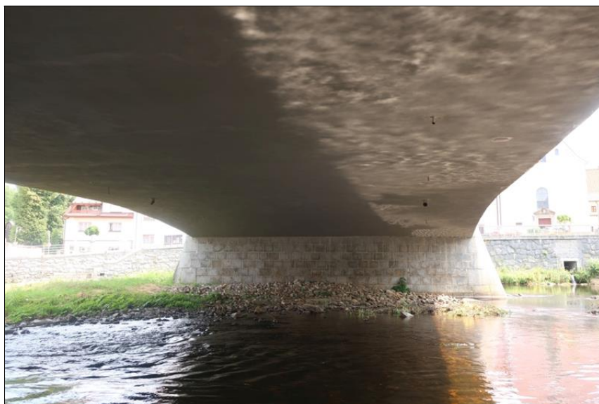
podhled NK od O1 k P2
