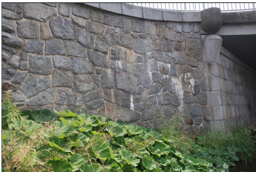
levé křídlo O3
