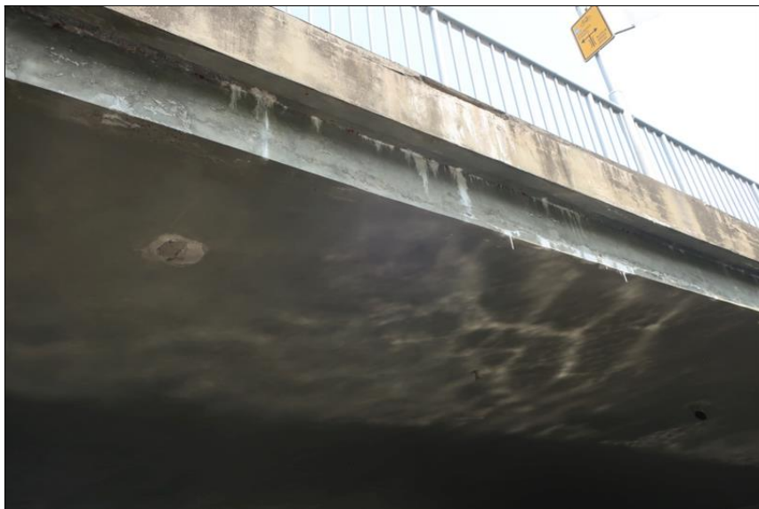
trhliny s výluhy pojiva na levém boku desky v 1. poli
