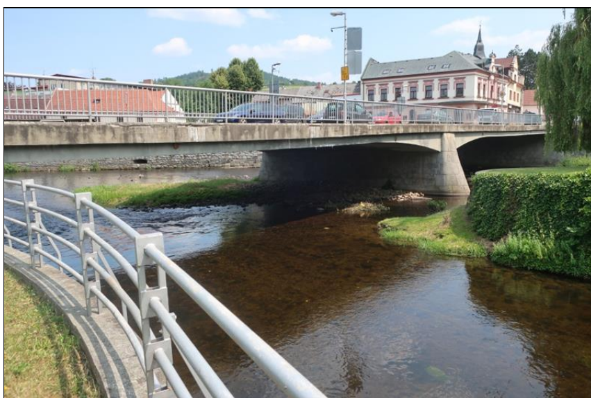
pravý bok mostu od O1
