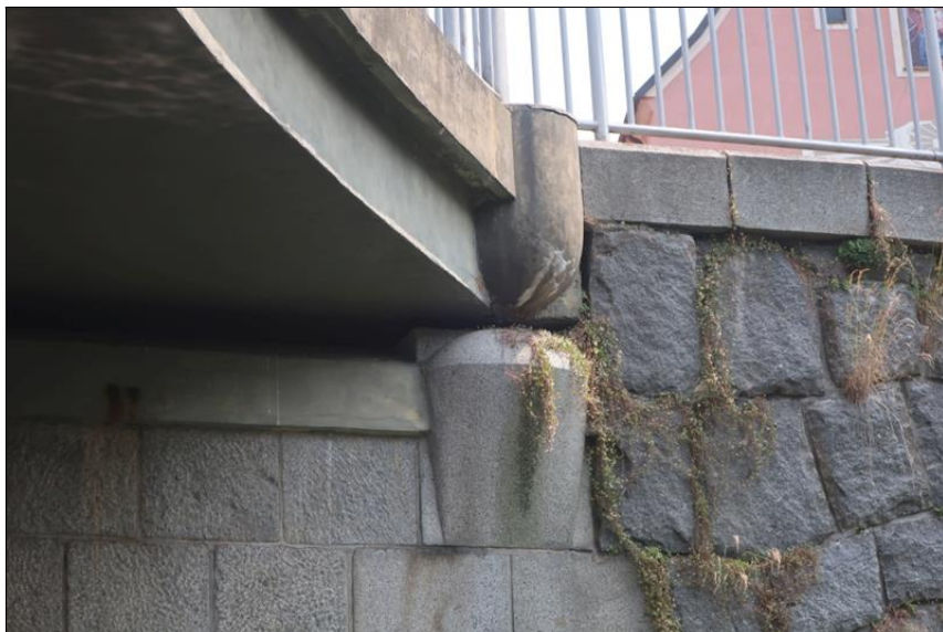
vegetace ve spárování pravého křídla O3
