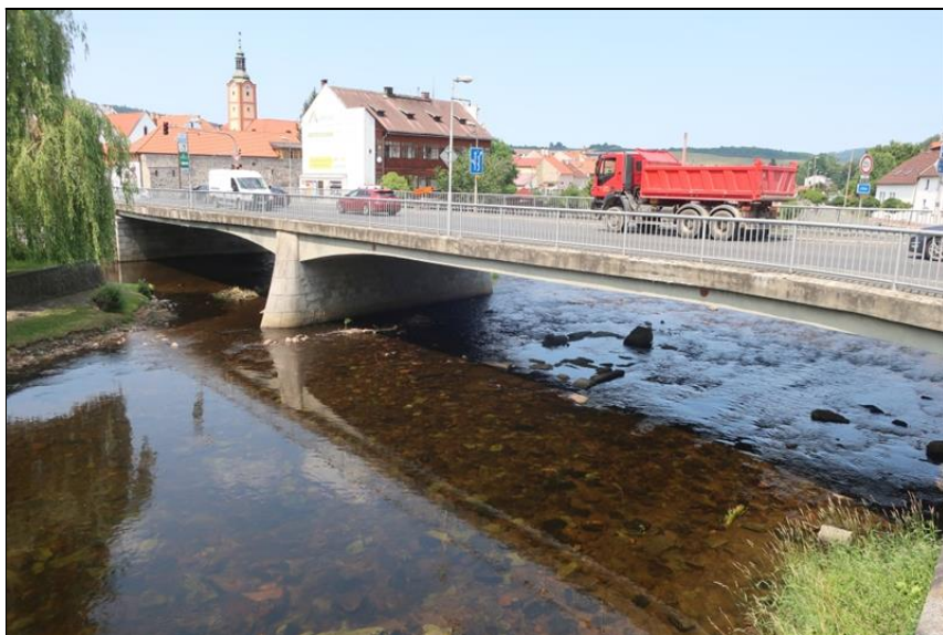
pohled na pravou stranu mostu
