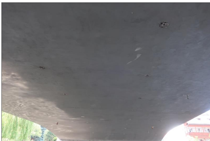
DTTO, drobné stopy po průsacích v výluhy pojiva
