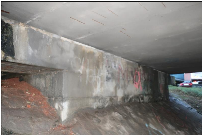
pohled na O1 zprava
