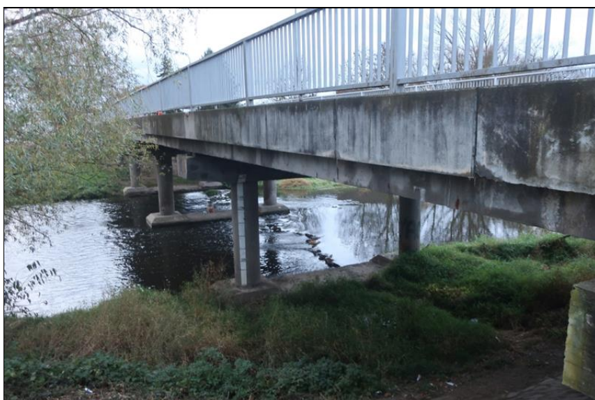
levý bok mostu od O1 ve směru staničení
