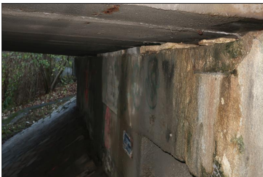
aktivní průsaky na lici O1
