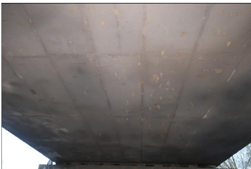
podhled NK ve 3. poli
