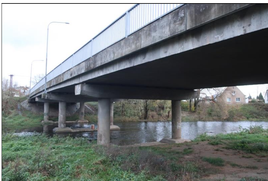
pravý bok NK od P5 proti směru staničení
