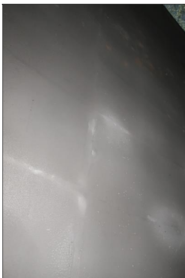
stopy po průsacích podélnými sparami i na spodním líci 6. pole
