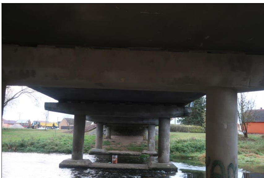
podhled NK od P2 ve směru staničení
