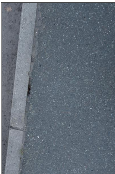
otevřená spára mezi krytem chodníku a obrubou
