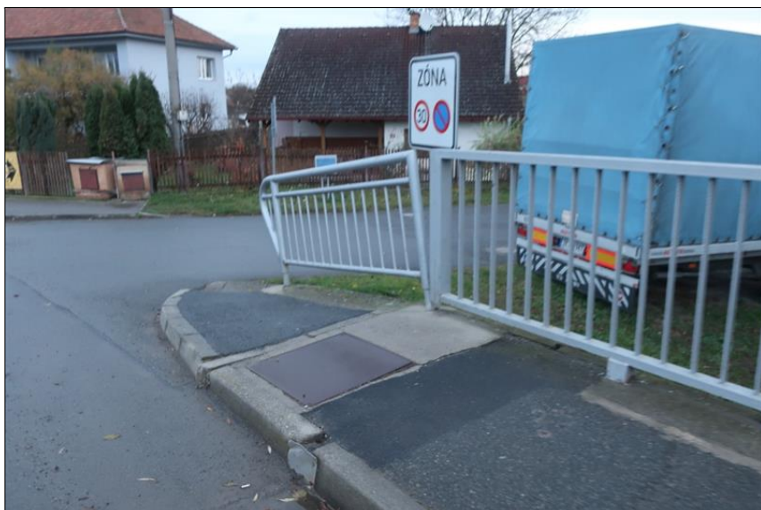
zábradlí vlevo před mostem
