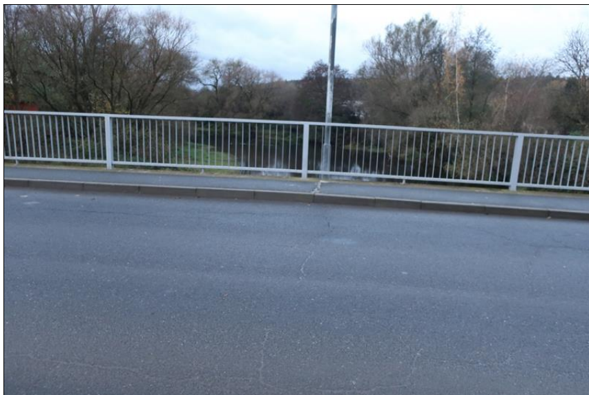
otevřená spára mezi krytem chodníku a obrubou
