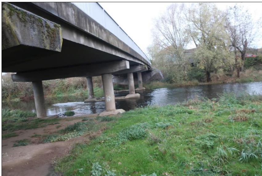
stopy po průsacích podélnými sparami i na spodním líci 6. pole
