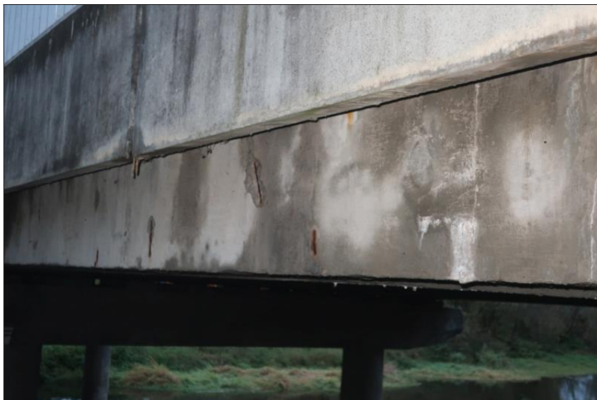
levý bok NK v 1. poli výluhy pojiva z dobetonávky kotvy příčného sepnutí
