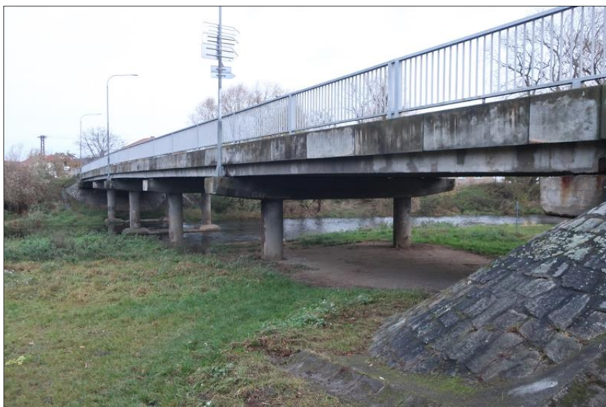
pohled na pravý bok mostu od O6
