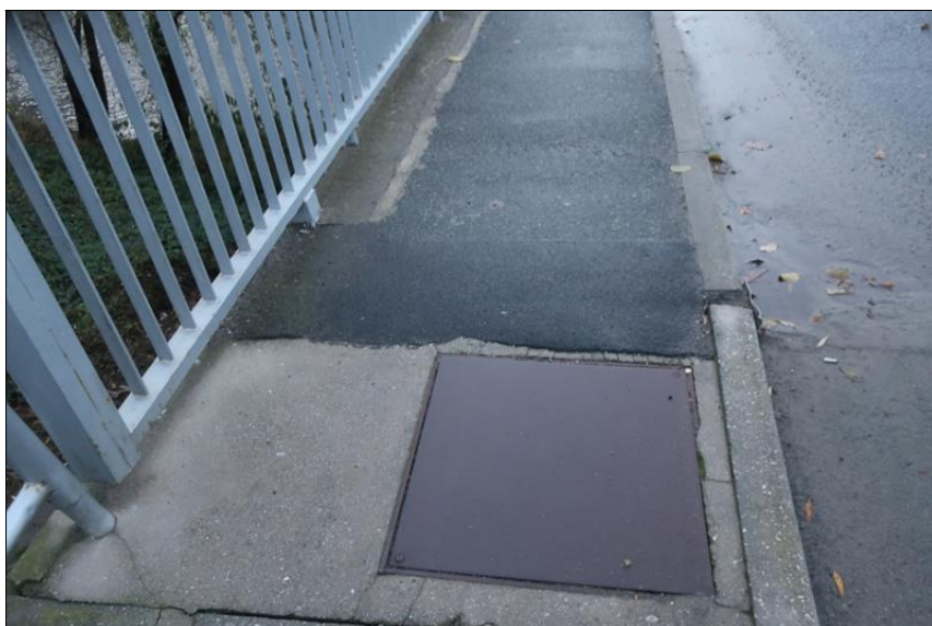
poklop šachty IS v levém chodníku
