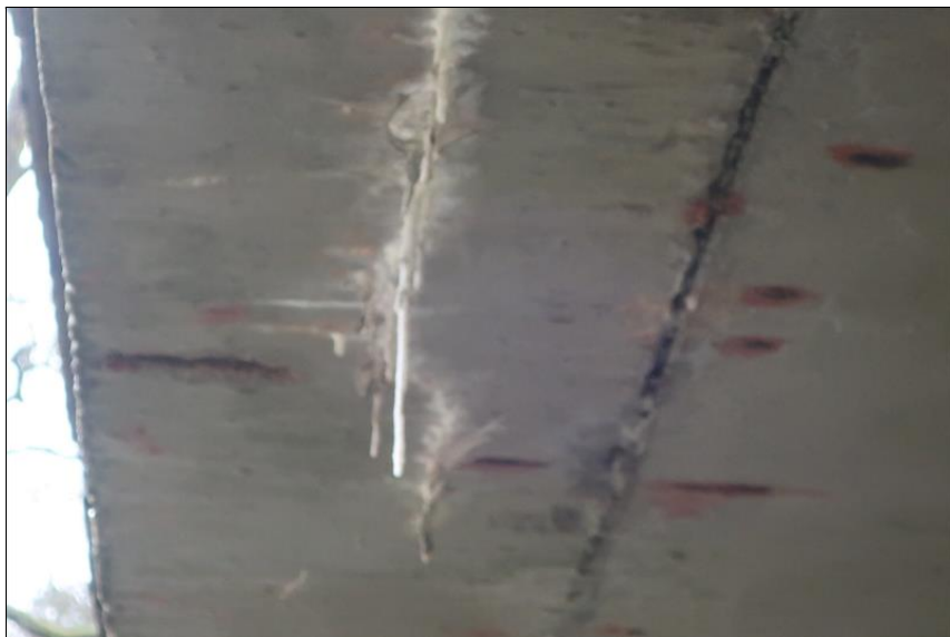
DTTO s aktivním průsakem a výluhem pojiva
