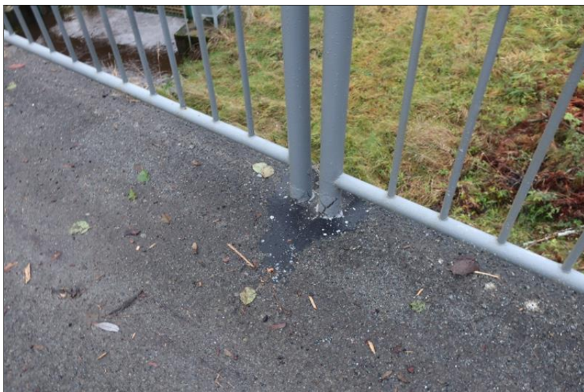
detail kotvení zábradlí do římsy
