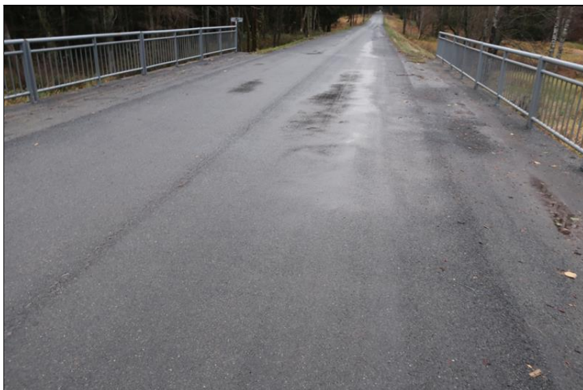
pohled na kryt vozovky
