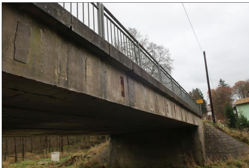
separace dobetonávek kotev příčného sepnutí na vnějším boku levého krajního nosníku
