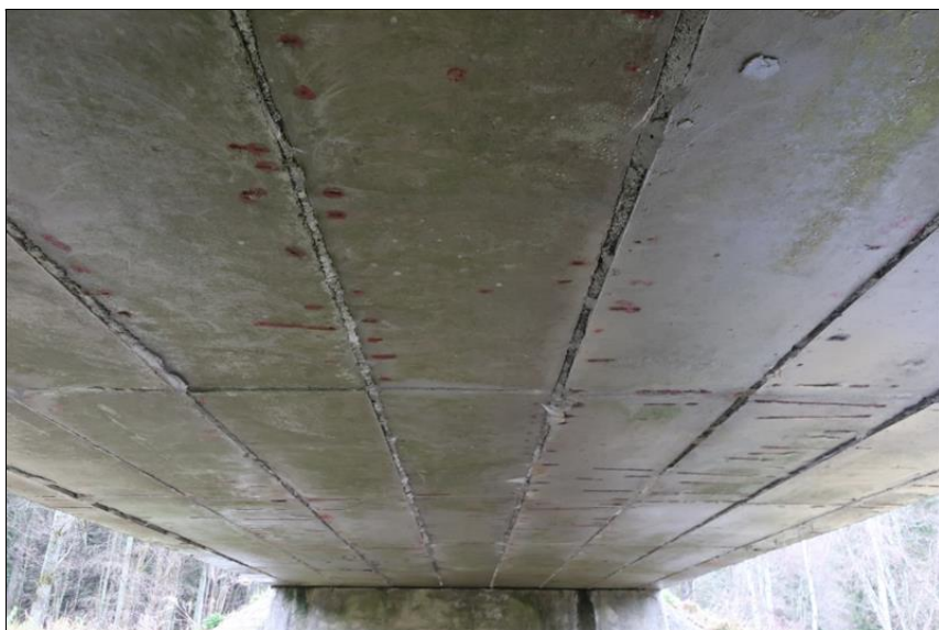
podhled NK od O1
