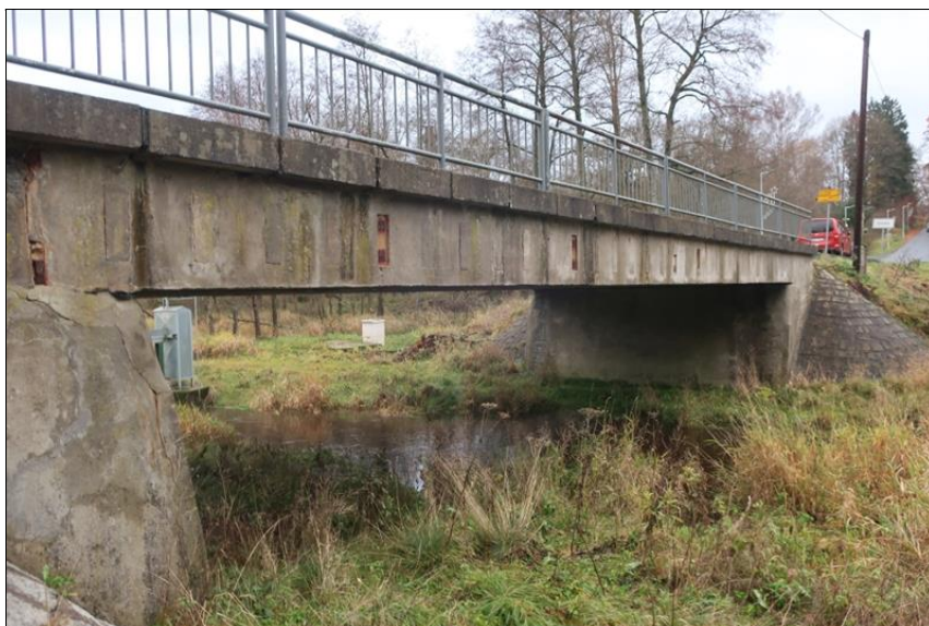
pohled na levý bok mostu
