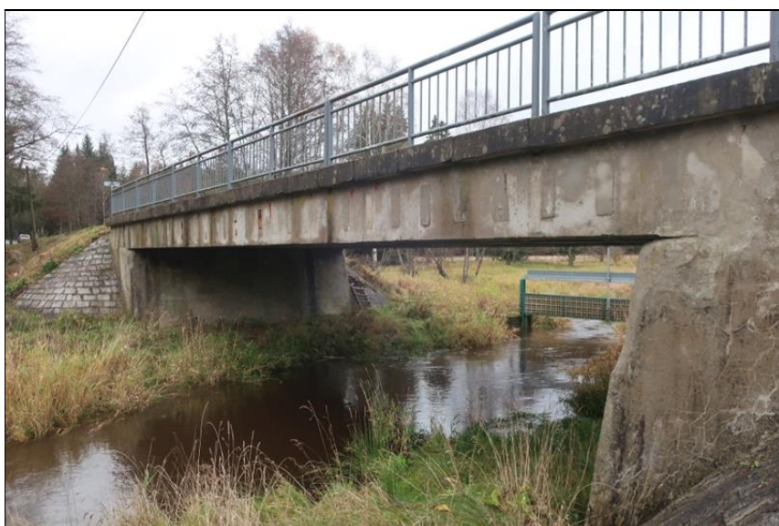
pohled na most
