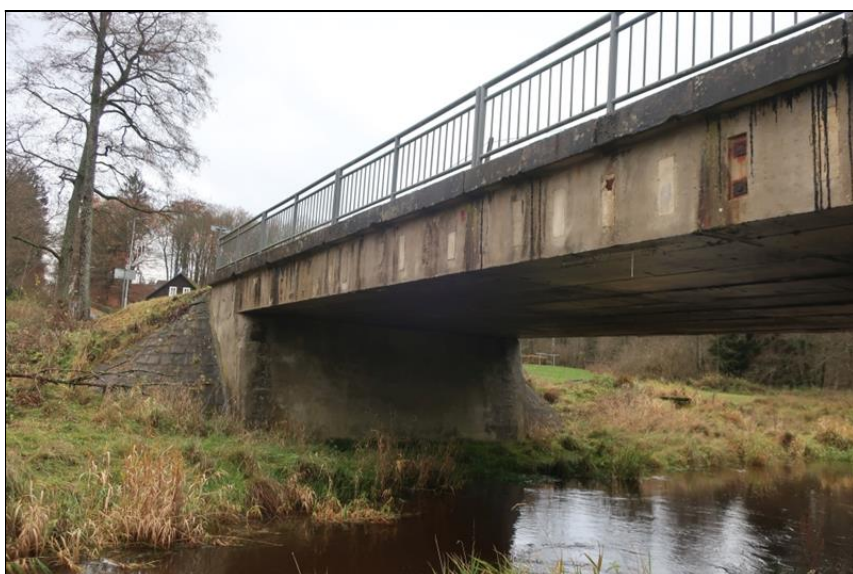
pohled na pravou stranu mostu
