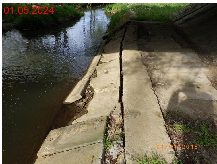
Rozvolněné betonové zpevnění břehů
