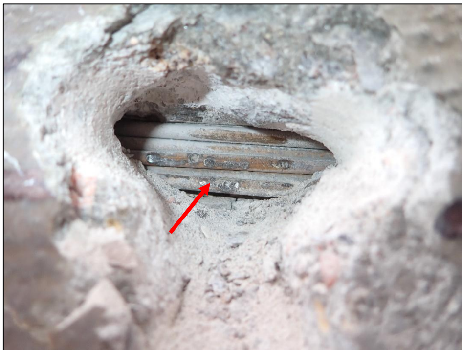
Foto 12: Detail sondy P12, předpínací výztuž nosník KA-61, bok nosníku č. 9, poloha viz Příloha 1. Na předpínací výztuži byla nalezena koroze. Hodnocení korozního stavu přepínací výztuže: stupeň 3. Kanálek vyplněn z méně než 10% injektážní směsí. Krytí předpínací výztuže cca 40 mm.
