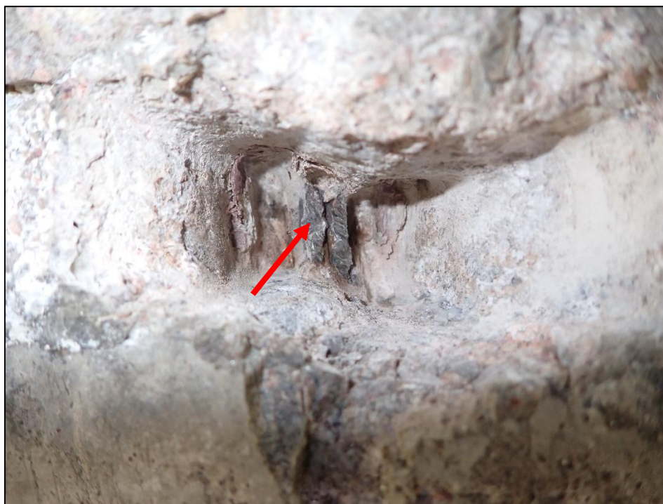
Foto 15: Detail sondy P15, předpínací výztuž nosník KA-61, spodní líc nosníku č. 6, poloha viz Příloha 1. Na předpínací výztuži byla nalezena koroz. Hodnocení korozního stavu předpínací výztuže: stupeň 3. Kanálek byl zcela vyplněn injektážní směsí. Krytí předpínací výztuže cca 40 mm.
