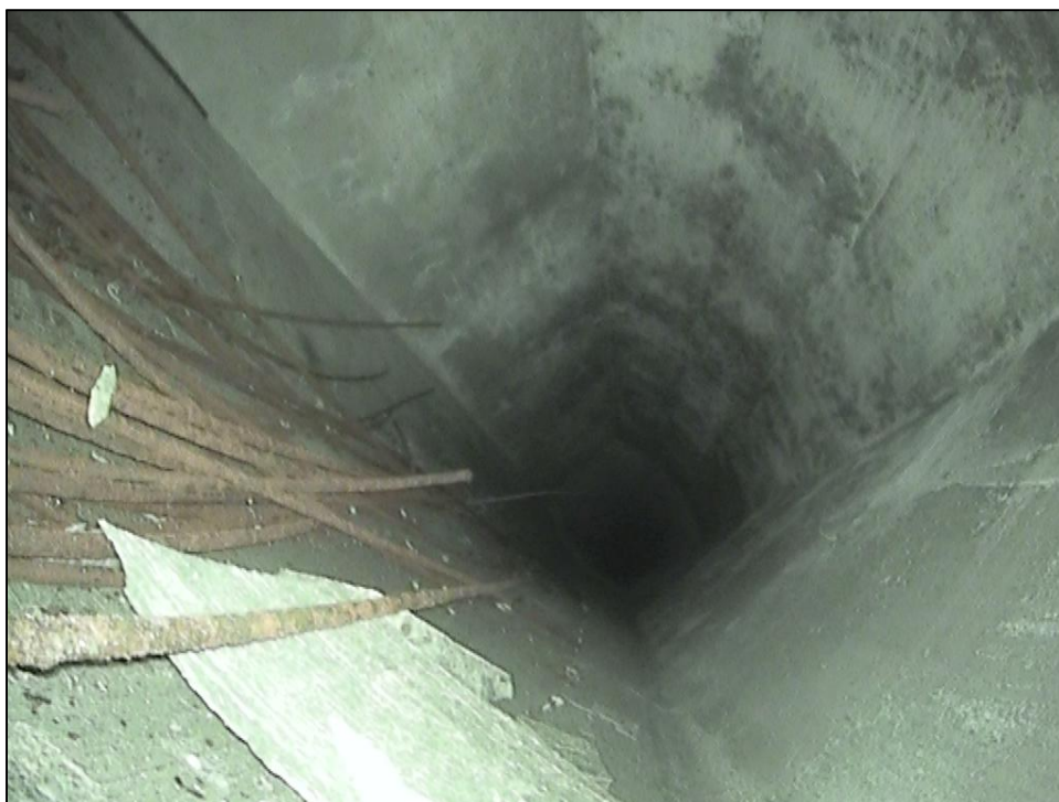
Foto 7: Detail vnitřního povrchu komory nosníku. Sonda E7, nosník č. 7. Pohled k opěře O2. Neaktivní stopy po průsacích spojené s výluhy. Lokální degradace povrchu betonu. Lokální koroze měkké výztuže nosníku. Na dně komory zkorodované zbytky předpínací výztuže.
