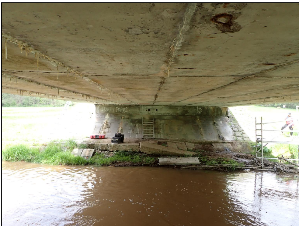
Foto 4: Celkový pohled na opěru O2. Výrazné stopy po průsacích. V oblastech průsaků dochází k degradaci betonu a korozi obnažené výztuže úložného prahu opěry. Dochází k sedání zpevnění svahů pod opěrou.
