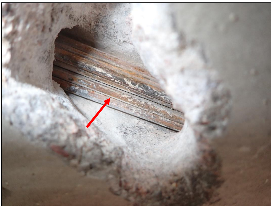
Foto 5: Detail sondy P5, předpínací výztuž nosník KA-61, spodní líc nosníku č. 1, poloha viz Příloha 1. Na předpínací výztuži byla nalezena koroz. Hodnocení korozního stavu přepínací výztuže: stupeň 3. Kanálek vyplněn z méně než 10% injektážní směsí. Krytí předpínací výztuže cca 40 mm.
