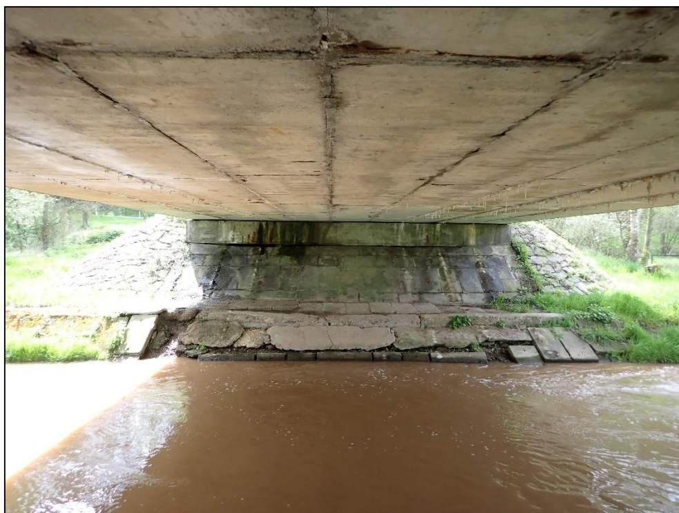
Foto 2: Celkový pohled na opěru O1. Výrazné stopy po průsacích. V oblastech průsaků dochází k degradaci betonu a korozi obnažené výztuže úložného prahu opěry. Dochází k sedání zpevnění svahů pod opěrou. Obnažené hlavy pilot v místě vetknutí do úložného prahu.
