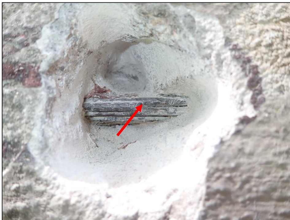
Foto 4: Detail sondy P4, předpínací výztuž nosník KA-61, bok nosníku č. 9, poloha viz Příloha 1. Na předpínací výztuži byla nalezena koroze. Hodnocení korozního stavu přepínací výztuže: stupeň 2. Kanálek zcela vyplněn injektážní směsí. Krytí předpínací výztuže cca 45 mm.
