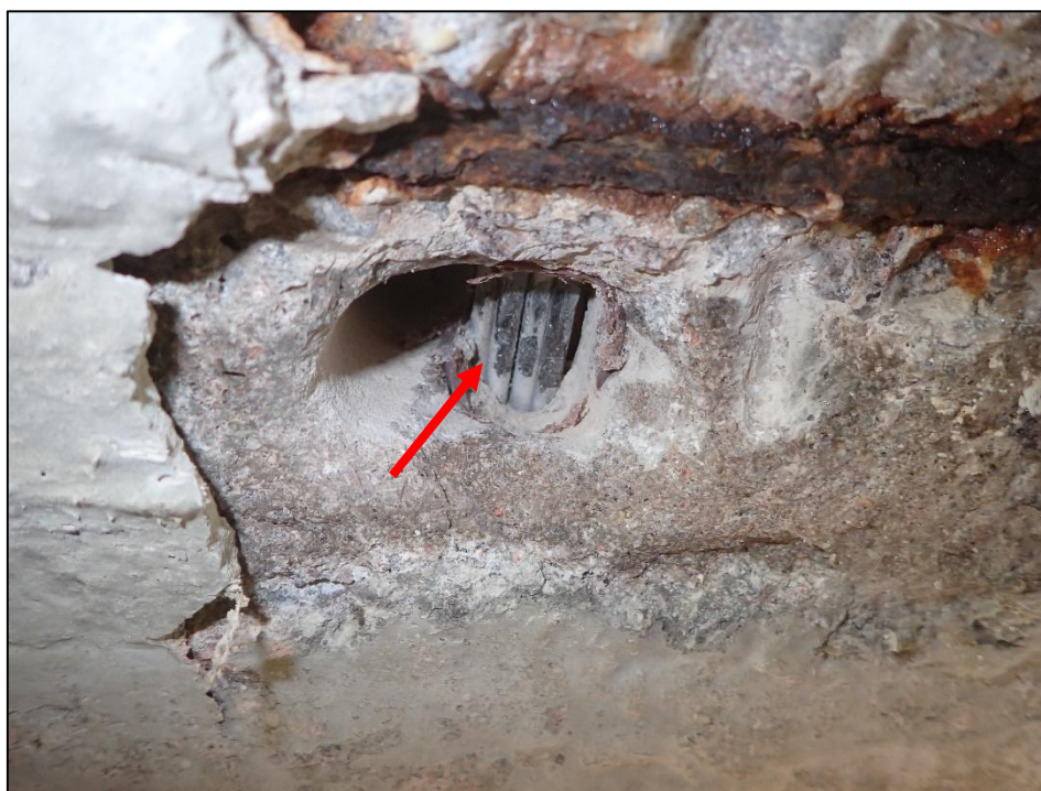
Foto 16: Detail sondy P16, předpínací výztuž nosník KA-61, spodní líc nosníku č. 3, poloha viz Příloha 1. Na předpínací výztuži byla nalezena koroz. Hodnocení korozního stavu předpínací výztuže: stupeň 2. Chránička zcela vyplněna injektážní směsí. Krytí předpínací výztuže cca 40 mm.
