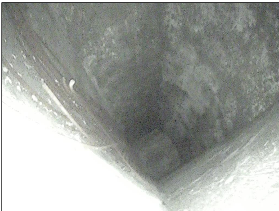
Foto 3: Detail vnitřního povrchu komory nosníku. Sonda E3, nosník č. 3. Pohled k opěře O2. Neaktivní stopy po průsacích spojené s výluhy. Lokální degradace povrchu betonu. Lokální koroze měkké výztuže nosníku. Na dně komory zkorodované zbytky předpínací výztuže.
