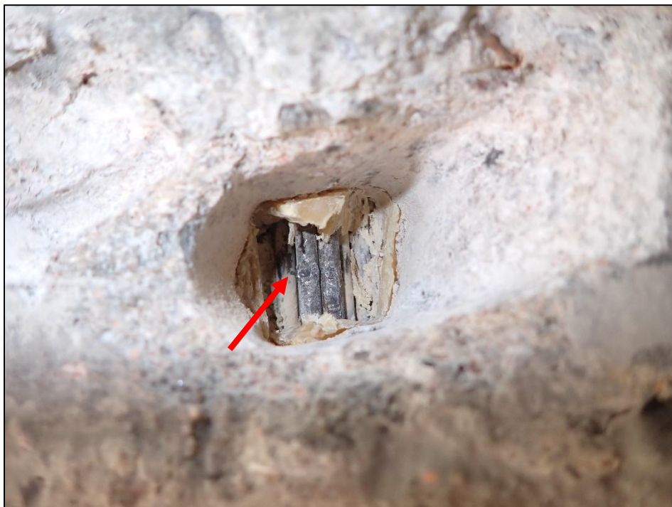
Foto 17: Detail sondy P17, předpínací výztuž nosník KA-61, spodní líc nosníku č. 2, poloha viz Příloha 1. Na předpínací výztuži byla nalezena koroze. Hodnocení korozního stavu předpínací výztuže: stupeň 2. Chránička zcela vyplněna injektážní směsí. Krytí předpínací výztuže cca 40 mm.
