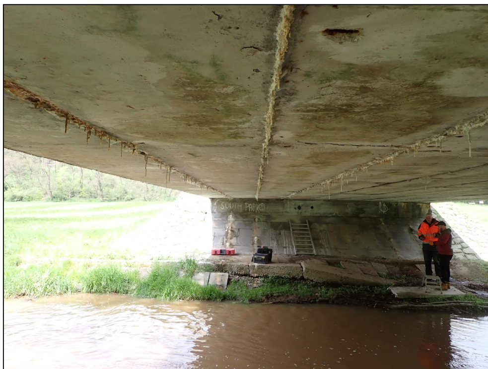
Foto 5: Pohled na spodní líc nosníků. Na spodním lici nosníků jsou patrné podélné intenzivně prosakující spáry mezi nosníky, resp. prosakující příčné pracovní spáry mezi dílci daného nosníku. Ojedinele jsou patrné trhliny s výluhy pojiva kopírující trajektorii před. výztuže.
