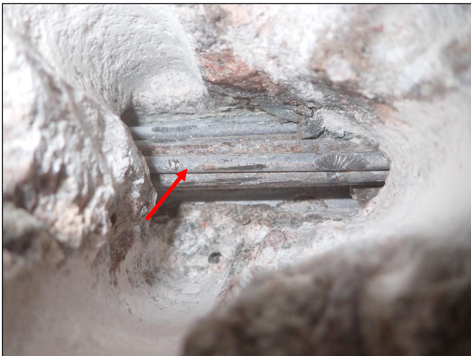
Foto 23: Detail sondy P23, předpínací výztuž nosník KA-61, spodní líc nosníku č. 2, poloha viz Příloha 1. Na předpínací výztuži byla nalezena koroze. Hodnocení korozního stavu předpínací výztuže: stupeň 2. Kanálek vyplněn z více než 50% injektážní směsí. Krytí předpínací výztuže cca 50 mm.
