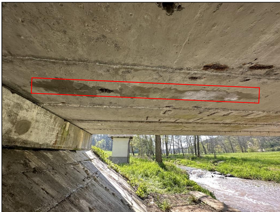
Foto 6: Nosník č. 4 – předpínací výztuž (bez chráničky), celkový pohled na zkušební oblast s vyznačenou sítí bodů
