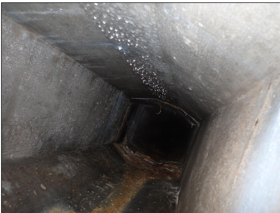
Foto 1: Detail vnitřního povrchu komory nosníku. Sonda E1, nosník č. 1. Pohled k opěře O2. Aktivní stopy po průsacích spojené s výluhy. Lokální degradace povrchu betonu. Lokální koroze měkké výztuže nosníku.
