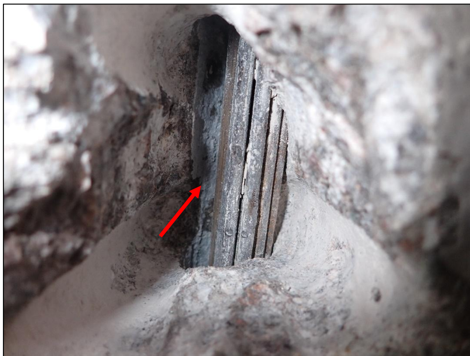
Foto 20: Detail sondy P20, předpínací výztuž nosník KA-61, spodní líc nosníku č. 4, poloha viz Příloha 1. Na předpínací výztuži byla nalezena koroze. Hodnocení korozního stavu přepínací výztuže: stupeň 3. Kanálek vyplněn z méně než 50% injektážní směsí. Krytí předpínací výztuže cca 60 mm.
