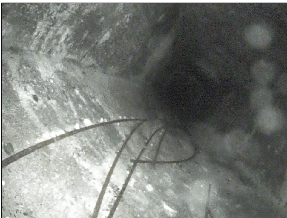
Foto 5: Detail vnitřního povrchu komory nosníku. Sonda E5, nosník č. 5. Pohled k opěře O2. Neaktivní stopy po průsacích spojené s výluhy. Lokální degradace povrchu betonu. Lokální koroze měkké výztuže nosníku. Na dně komory zkorodované zbytky předpínací výztuže.
