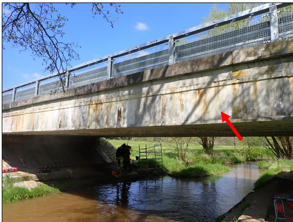
Foto 7: Pohled na bok nosníku. Patrný stopy po zatékání spojené s výluhy. Degradace betonu a měkké výztuže nosníků. Patrna trhлина s výluhy pojiva kopírující trajektorii před. výztuže.
