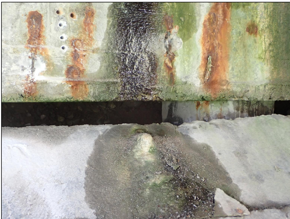
Foto 3: Detail opěry O1. Výrazné stopy po průsacích. V oblastech průsaků dochází k degradaci betonu a korozi obnažené výztuže úložného prahu opěry. Dochází k sedání zpevnění svahů pod opěrou. Obnažené hlavy pilot v místě vetknutí do úložného prahu.
