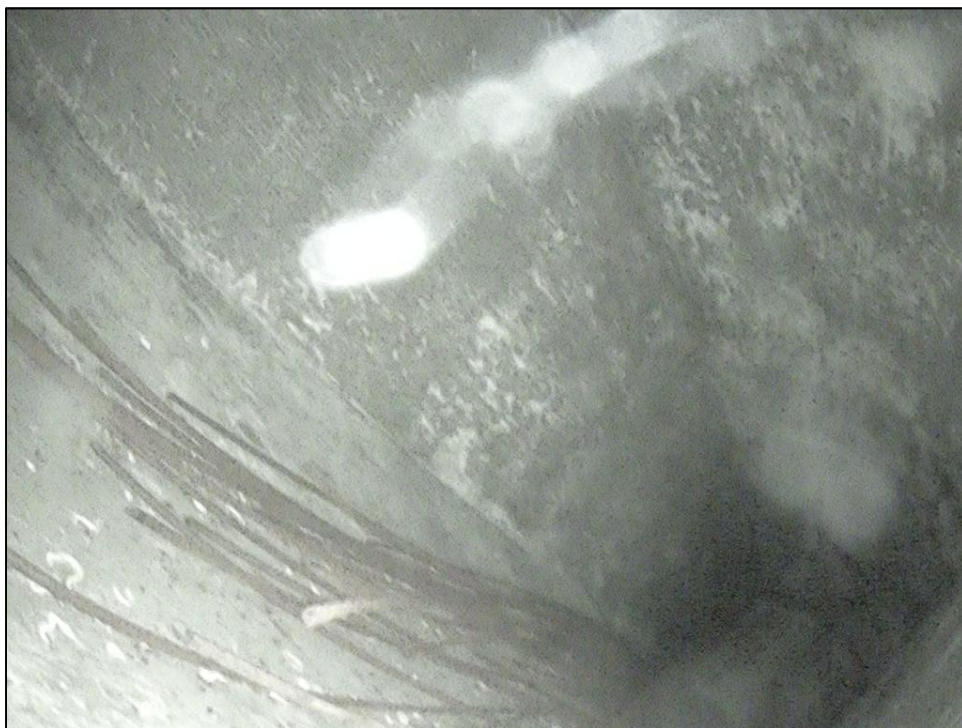
Foto 4: Detail vnitřního povrchu komory nosníku. Sonda E4, nosník č. 4. Pohled k opěře O2. Neaktivní stopy po průsacích spojené s výluhy. Lokální degradace povrchu betonu. Lokální koroze měkké výztuže nosníku. Na dně komory zkorodované zbytky předpínací výztuže.
