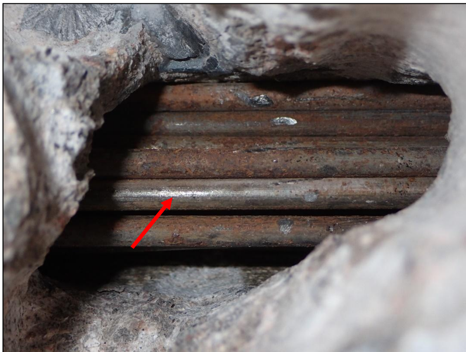
Foto 25: Detail sondy P25, předpínací výztuž nosník KA-61, spodní líc nosníku č. 4, poloha viz Příloha 1. Na předpínací výztuži byla nalezena koroze. Hodnocení korozního stavu předpínací výztuže: stupeň 4. Kanálek vyplněn z méně než 10% injektážní směsí. Krytí předpínací výztuže cca 70 mm.
