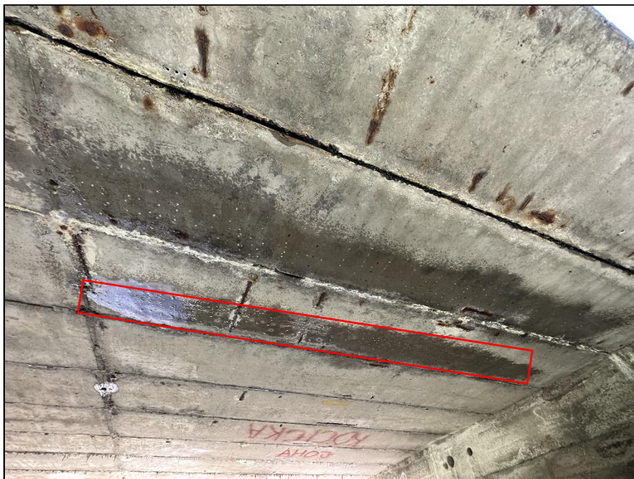
Foto 1: Nosník č. 7 – předpínací výztuž (bez chráničky), celkový pohled na zkušební oblast s vyznačenou sítí bodů
