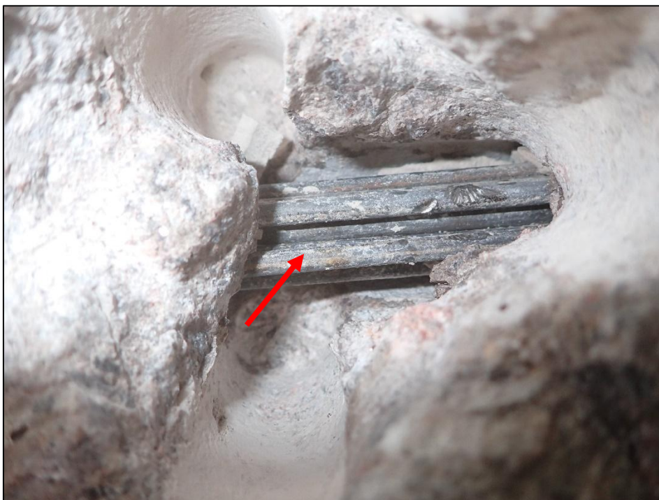
Foto 24: Detail sondy P24, předpínací výztuž nosník KA-61, spodní líc nosníku č. 3, poloha viz Příloha 1. Na předpínací výztuži byla nalezena koroze. Hodnocení korozního stavu předpínací výztuže: stupeň 2. Kanálek vyplněn z více než 50% injektážní směsí. Krytí předpínací výztuže cca 50 mm.
