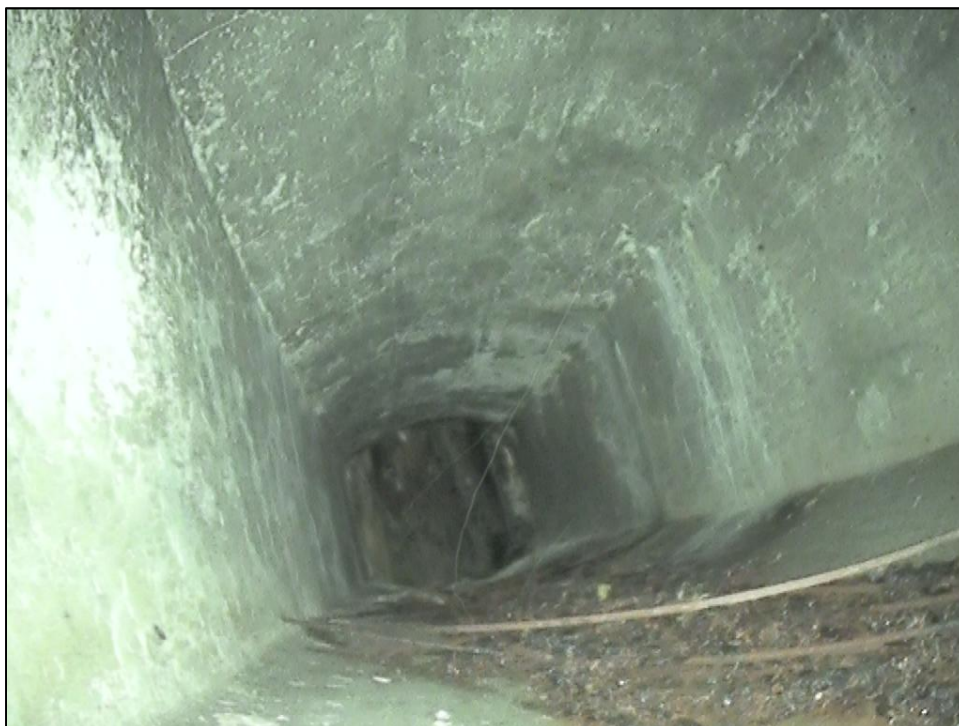
Foto 8: Detail vnitřního povrchu komory nosníku. Sonda E8, nosník č. 8. Pohled k opěře O2. Neaktivní stopy po průsacích spojené s výluhy. Lokální degradace povrchu betonu. Lokální koroze měkké výztuže nosníku. Na dně komory zkorodované zbytky předpínací výztuže.
