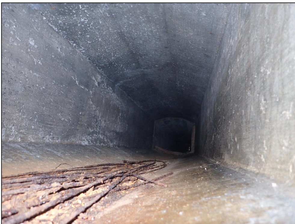
Foto 9: Detail vnitřního povrchu komory nosníku. Sonda E9, nosník č. 9. Pohled k opěře O2. Neaktivní stopy po průsacích spojené s výluhy. Lokální degradace povrchu betonu. Lokální koroze měkké výztuže nosníku. Na dně komory zkorodované zbytky předpínací výztuže.
