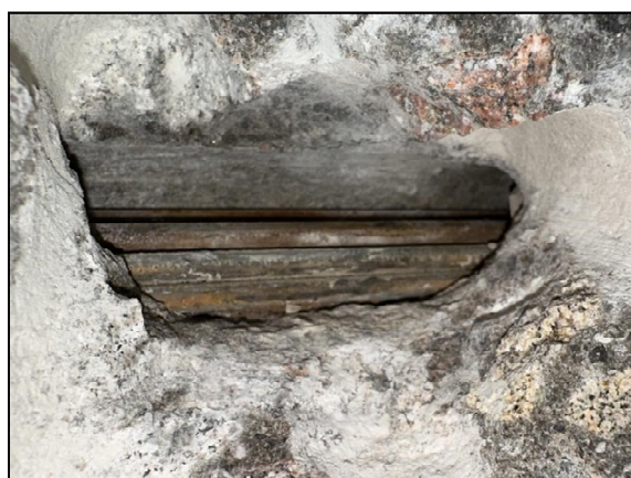
Foto 4 a 5: Nosník č. 8 – předpínací výztuž (bez chráničky), v oblasti poklesu potenciálu (+ 3,3 m) byla nalezena silná koroze prutu podélné betonářské výztuže, byla nalezena plošná povrchová koroze předpínací výztuže (stupeň 3) a téměř nezainjektovaný kanálek
