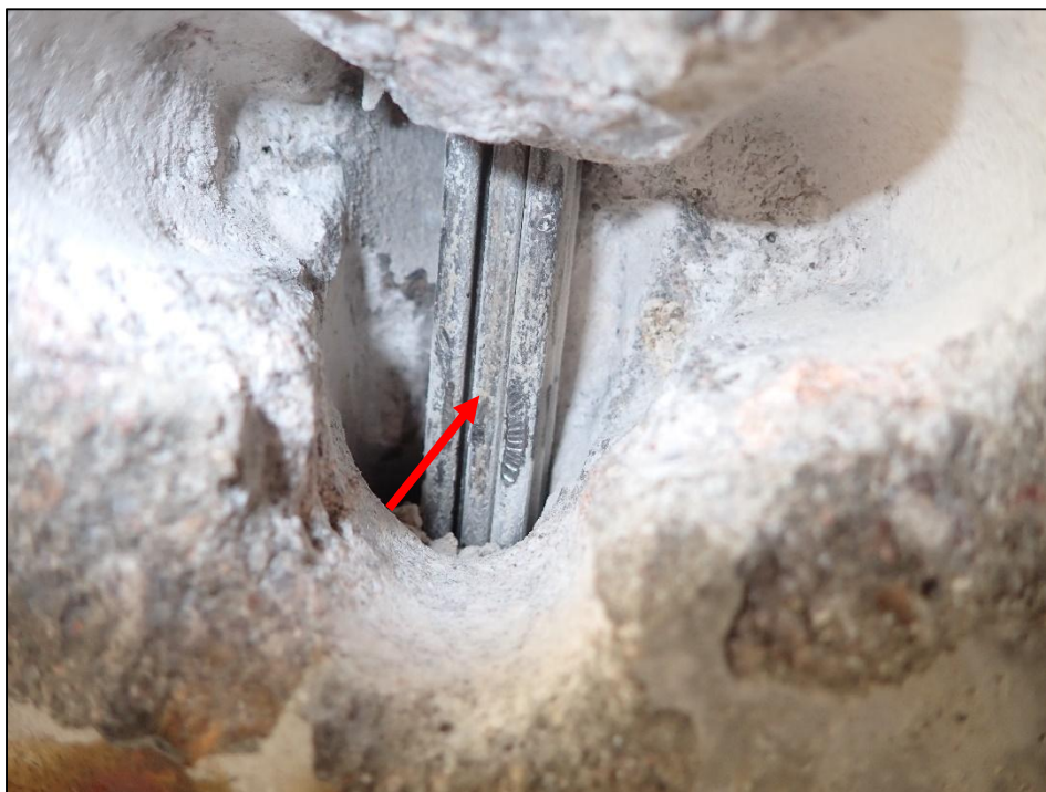
Foto 14: Detail sondy P14, předpínací výztuž nosník KA-61, spodní líc nosníku č. 9, poloha viz Příloha 1. Na předpínací výztuži byla nalezena koroze. Hodnocení korozního stavu přepínací výztuže: stupeň 3. Kanálek vyplněn z méně než 10% injektážní směsí. Krytí předpínací výztuže cca 40 mm.
