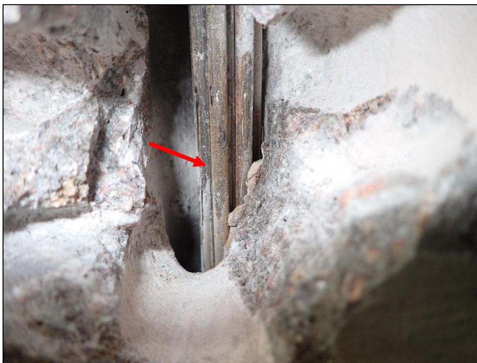
Foto 11: Detail sondy P11, předpínací výztuž nosník KA-61, spodní líc nosníku č. 5, poloha viz Příloha 1. Na předpínací výztuži byla nalezena koroze. Hodnocení korozního stavu přepínací výztuže: stupeň 3. Kanálek vyplněn z méně než 10% injektážní směsí. Krytí předpínací výztuže cca 50 mm.
