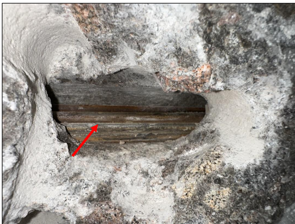
Foto 18: Detail sondy P18, předpínací výztuž nosník KA-61, spodní líc nosníku č. 8, poloha viz Příloha 1. Na předpínací výztuži byla nalezena koroze. Hodnocení korozního stavu předpínací výztuže: stupeň 3. Kanálek vyplněn z méně než 10% injektážní směsí. Krytí předpínací výztuže cca 50 mm.
