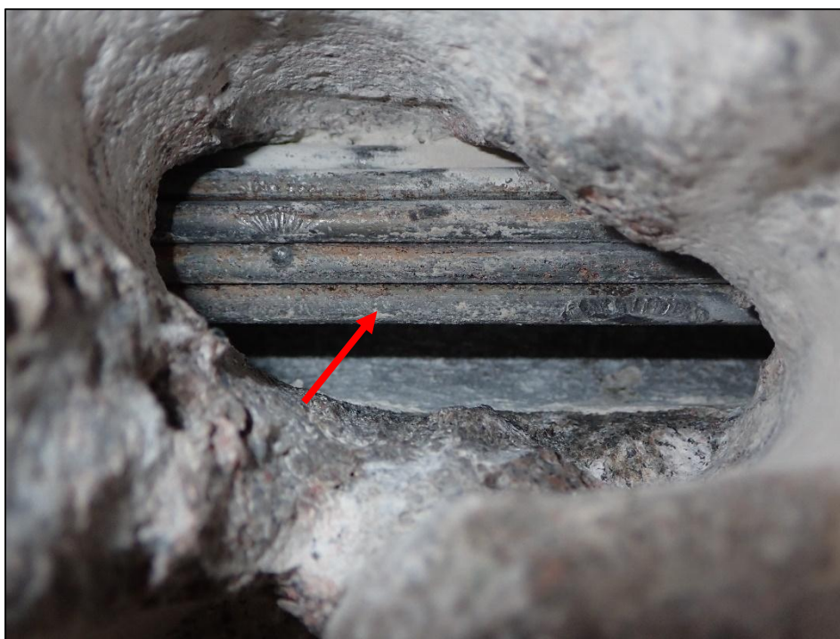
Foto 26: Předpínací výztuž nosník KA-61, spodní líc nosníku č. 4, poloha viz Příloha 1. Na předpínací výztuži byla nalezena koroze. Hodnocení korozního stavu předpínací výztuže: stupeň 3. Kanálek vyplněn z méně než 50% injektážní směsí. Krytí předpínací výztuže cca 60 mm.
