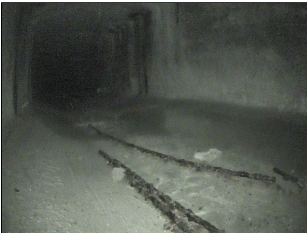
Foto 2: Detail vnitřního povrchu komory nosníku. Sonda E2, nosník č. 2. Pohled k opěře O2. Neaktivní stopy po průsacích spojené s výluhy. Lokální degradace povrchu betonu. Lokální koroze měkké výztuže nosníku. Na dně komory zkorodované zbytky předpínací výztuže.
