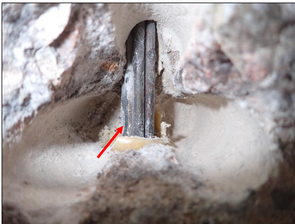
Foto 7: Detail sondy P7, předpínací výztuž nosník KA-61, spodní líc nosníku č. 7, poloha viz Příloha 1. Na předpínací výztuži byla nalezena koruze. Hodnocení korozního stavu předpínací výztuže: stupeň 3. Kanálek zcela vyplněn injektážní směsí. Krytí předpínací výztuže cca 45 mm.
