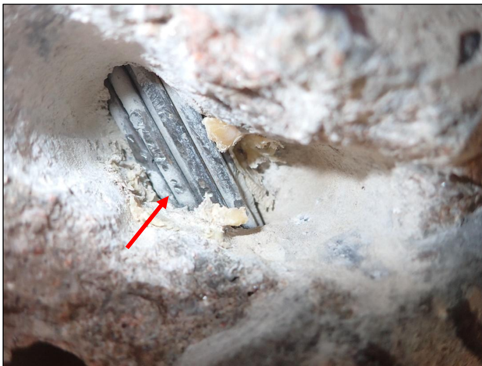
Foto 8: Detail sondy P8, předpínací výztuž nosník KA-61, spodní líc nosníku č. 6, poloha viz Příloha 1. Na předpínací výztuži byla nalezena koruze. Hodnocení korozního stavu předpínací výztuže: stupeň 3. Kanálek zcela vyplněn injektážní směsí. Krytí předpínací výztuže cca 45 mm.
