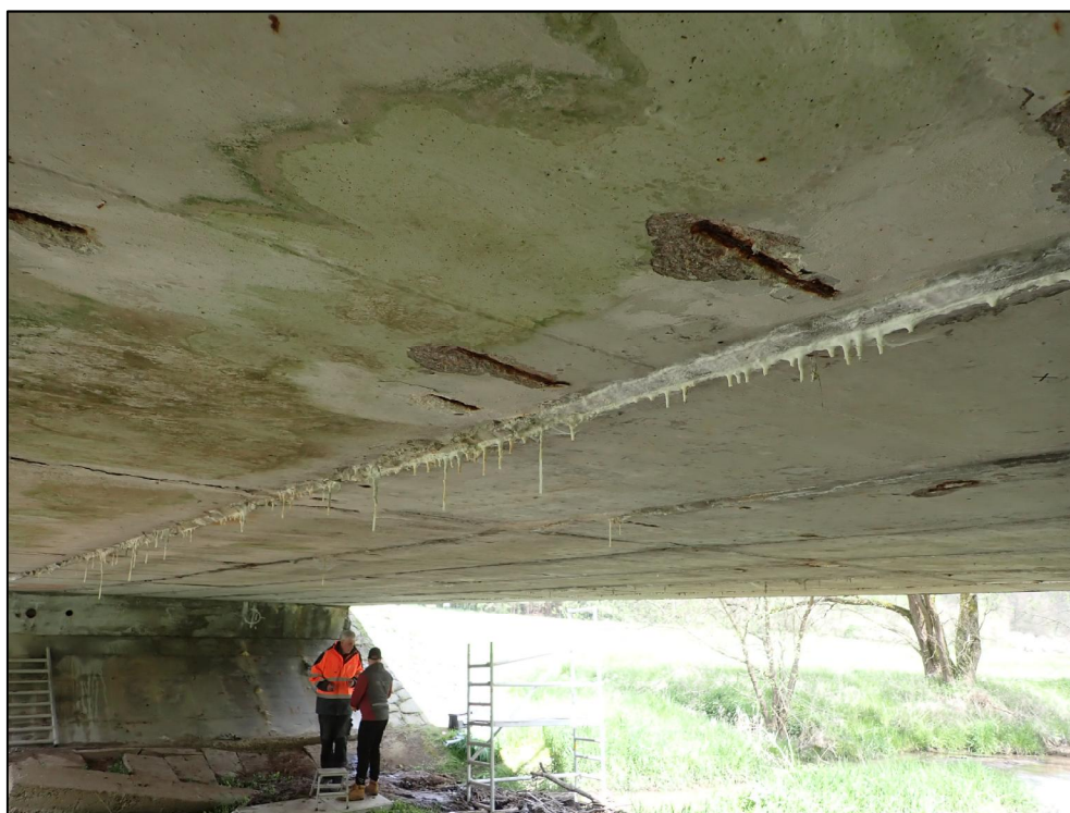
Foto 6: Pohled na spodní líc nosníků. Na spodním lici nosníků jsou patrné podélné intenzivně prosakující spáry mezi nosníky, resp. prosakující příčné pracovní spáry mezi dílci daného nosníku. Ojedinele jsou patrné trhliny s výluhy pojiva kopírující trajektorii před. výztuže.
