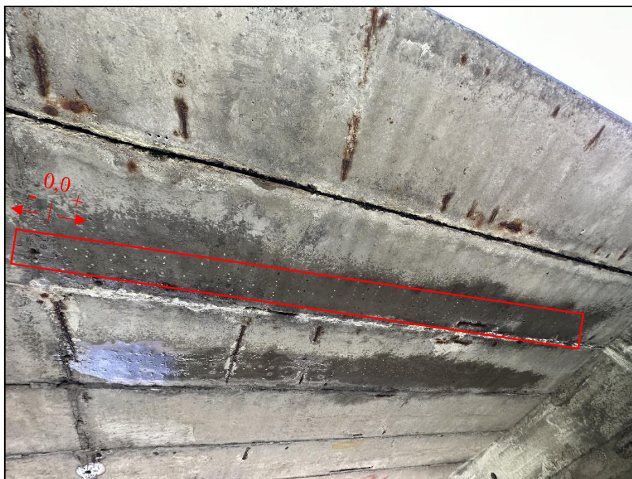
Foto 3: Nosník č. 8 – předpínací výztuž (bez chráničky), celkový pohled na zkušební oblast s vyznačenou sítí bodů
