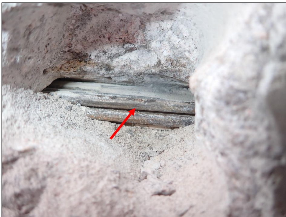
Foto 13: Detail sondy P13, předpínací výztuž nosník KA-61, bok nosníku č. 9, poloha viz Příloha 1. Na předpínací výztuži byla nalezena koroze. Hodnocení korozního stavu přepínací výztuže: stupeň 6 – částečně volný kabel. Kanálek vyplněn z méně než 10% injektážní směsí. Krytí předpínací výztuže cca 35 mm.
