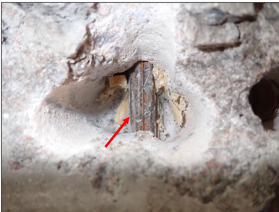
Foto 6: Detail sondy P6, předpínací výztuž nosník KA-61, spodní líc nosníku č. 8, poloha viz Příloha 1. Na předpínací výztuži byla nalezena koroz. Hodnocení korozního stavu přepínací výztuže: stupeň 3. Kanálek vyplněn z méně než 10% injektážní směsí. Krytí předpínací výztuže cca 45 mm.
