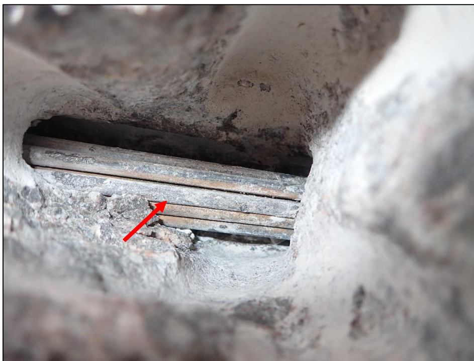
Foto 19: Detail sondy P19, předpínací výztuž nosník KA-61, spodní líc nosníku č. 4, poloha viz Příloha 1. Na předpínací výztuži byla nalezena koroze. Hodnocení korozního stavu přepínací výztuže: stupeň 3. Kanálek vyplněn z méně než 50% injektážní směsí. Krytí předpínací výztuže cca 65 mm.
