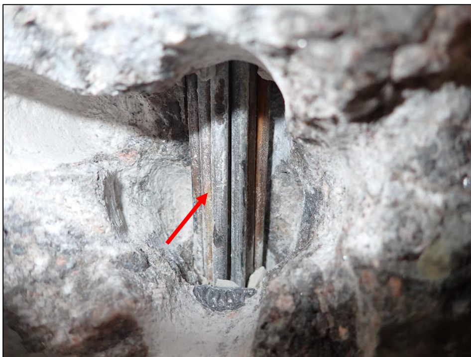
Foto 21: Detail sondy P21, předpínací výztuž nosník KA-61, spodní líc nosníku č. 4, poloha viz Příloha 1. Na předpínací výztuži byla nalezena korozí. Hodnocení korozního stavu přepínací výztuže: stupeň 3. Kanálek vyplněn z méně než 50% injektážní směsí. Krytí předpínací výztuže cca 45 mm.
