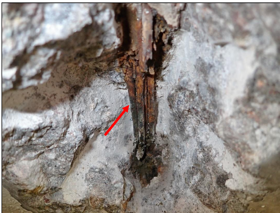
Foto 10: Detail sondy P10, předpínací výztuž nosník KA-61, spodní líc nosníku č. 4, poloha viz Příloha 1. Na předpínací výztuži byla nalezena koroze. Hodnocení korozního stavu přepínací výztuže: stupeň 6 – celkový rozpad výztuže. Kanálek vyplněn z méně než 10% injektážní směsí. Krytí předpínací výztuže cca 50 mm.
