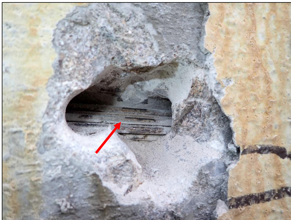
Foto 2: Detail sondy P2, předpínací výztuž nosník KA-61, bok nosníku č. 1, poloha viz Příloha 1. Na předpínací výztuži byla nalezena koroze. Hodnocení korozního stavu přepínací výztuže: stupeň 6 – částečně volný kabel. Kanálek vyplněn z méně než 10% injektážní směsí. Krytí předpínací výztuže cca 40 mm.
