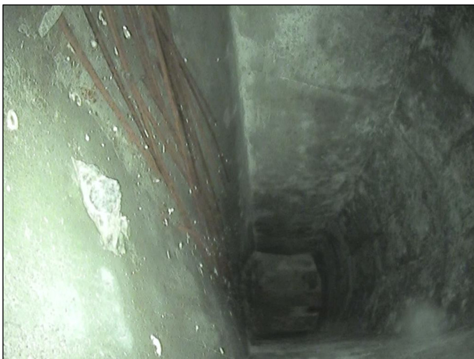
Foto 6: Detail vnitřního povrchu komory nosníku. Sonda E6, nosník č. 6. Pohled k opěře O2. Neaktivní stopy po průsacích spojené s výluhy. Lokální degradace povrchu betonu. Lokální koroze měkké výztuže nosníku. Na dně komory zkorodované zbytky předpínací výztuže.
