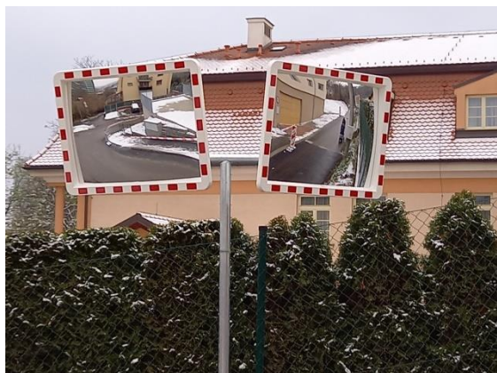
Návrh řešení umístění dvou ks dopravních zrcadel na jednom sloupku pomocí ocel. pozinkovaného držáku dvou zrcadel
