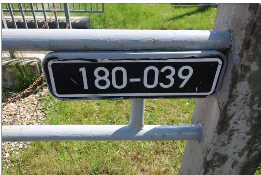
evidenční číslo je umístěno na výplni zábradlí
