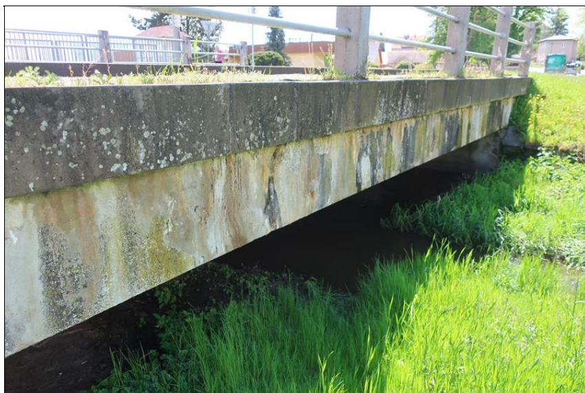
levý bok mostu od O2
