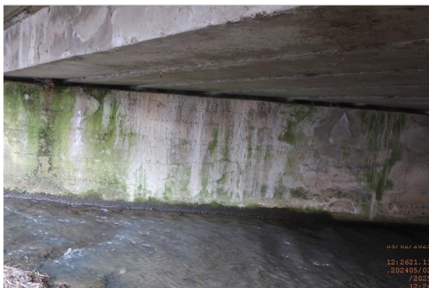
stopy po průsacích s výluhy pojiva z úložné spáry na líc dřívku O1
