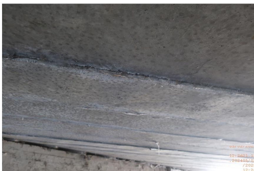
příčný podhled nosné konstrukce
