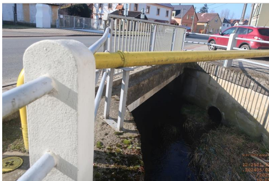
levý bok mostu
