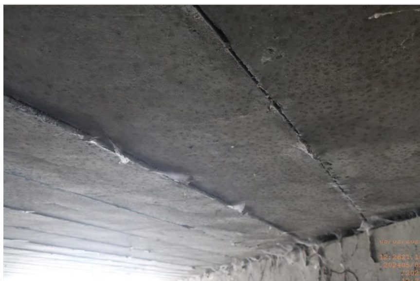
podhled nosné konstrukce
