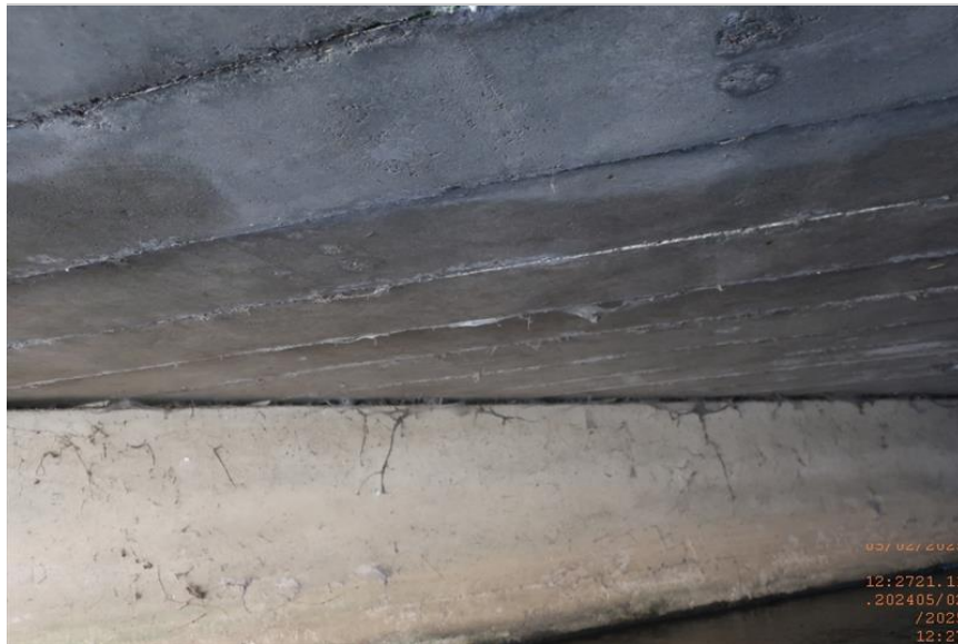
příčný podhled NK zleva
