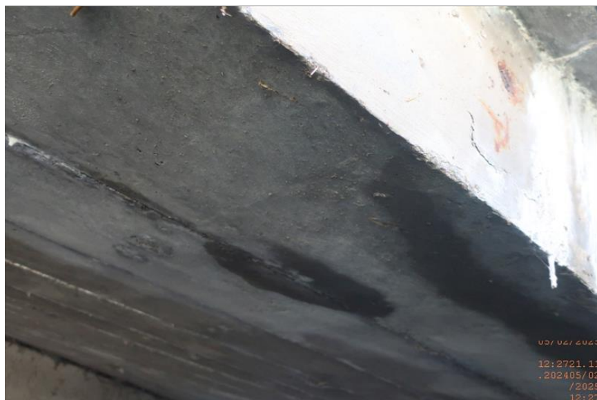
aktivní průsak sparou mezi nosníky
