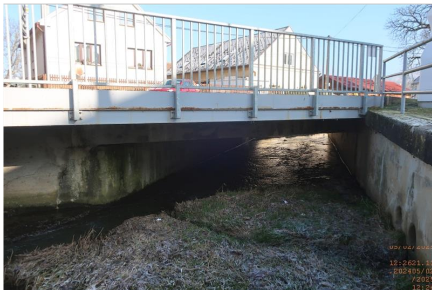
pravý bok mostu
