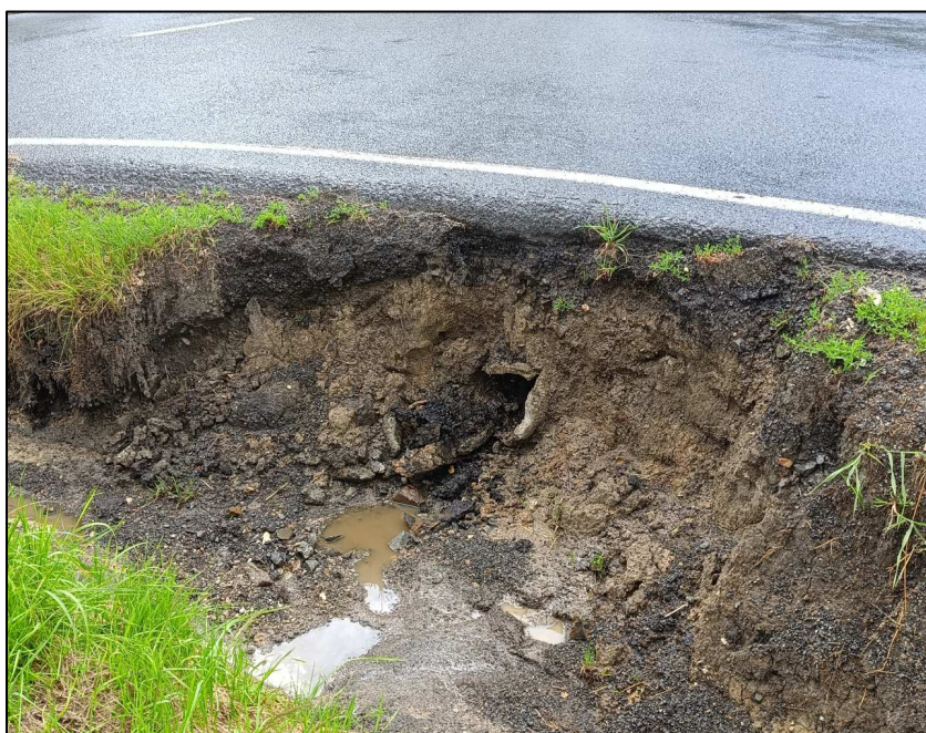
Obr. 1 – Výtok propustku na sil. III/19011 v km 0,006
