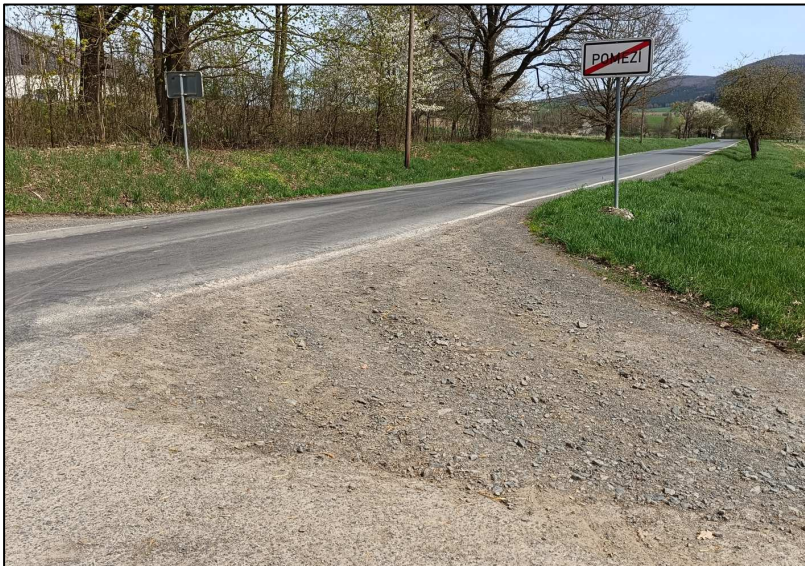
Obr. 3 – Nároží připojení účelové komunikace s povrchem z nestmeleného kameniva
