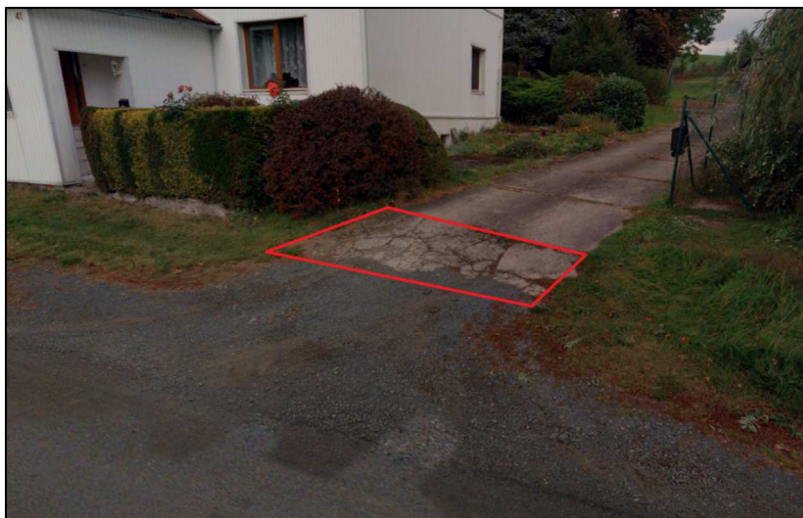
Obr. 2 – Rozsah demontáže CB desky
