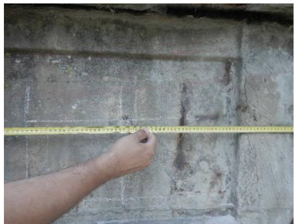
Obr. 102: Fasáda konce nosníku N1 nad Pi2 ve 2. poli. Měření polohy detekov. měkké výztuže.
