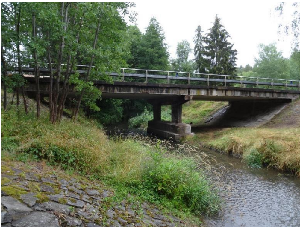
Obr.2-5: Levá (povodní) strana mostu.
