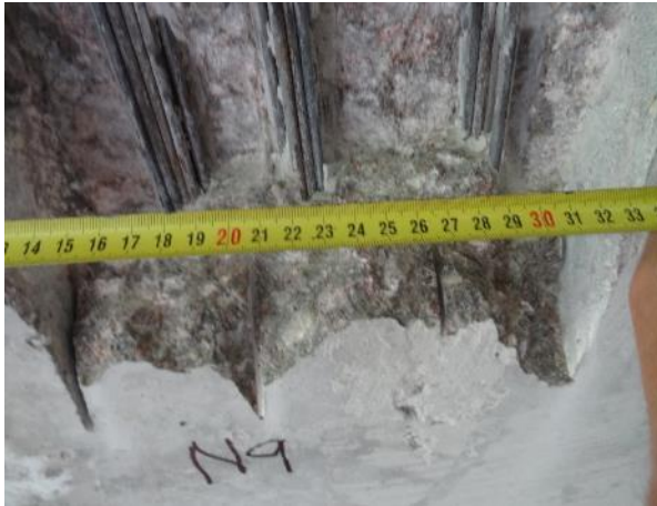
Obr. 43: Podhled nosníku N9, 1,9m od čela Op1. S NK7 , K4P – K6P. Půdorysná poloha kabelu K7 vztažena k podél. kraji nosníku.
