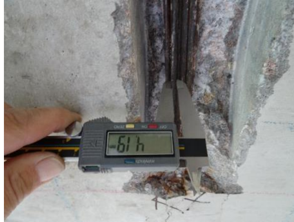
Obr. 62: SNK9, K7. Měření \varnothing předpínacího drátu.
