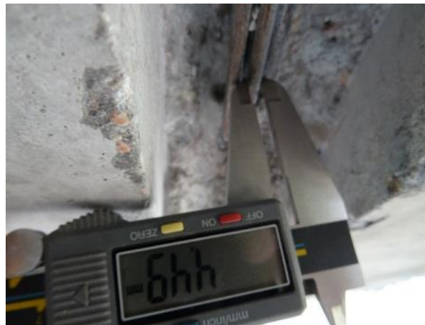
Obr. 24: SNK4, K5. Měření \varnothing předpínacího drátu.
