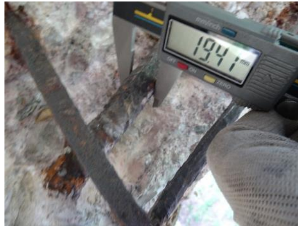
Obr. 46: S ss6 . Zjištěný \varnothing smykové výztuže. výztuže.
