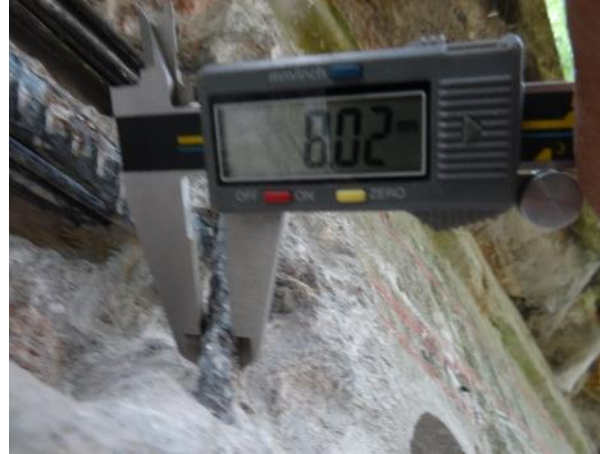
Obr. 164: Měření \varnothing svislé výztuže v místě sekané sondy S NK23 .
