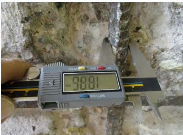
Obr. 54: S ss8 . Zjištěný \varnothing svislé výztuže.
