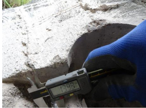
Obr. 20: S SS3 . Zjištěný \varnothing vodorov. výztuže.
