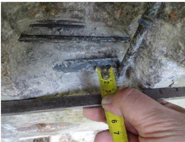
Obr. 77: SNK11. Měření minim. krytí obnažené měkké výztuže v místě sondy.
