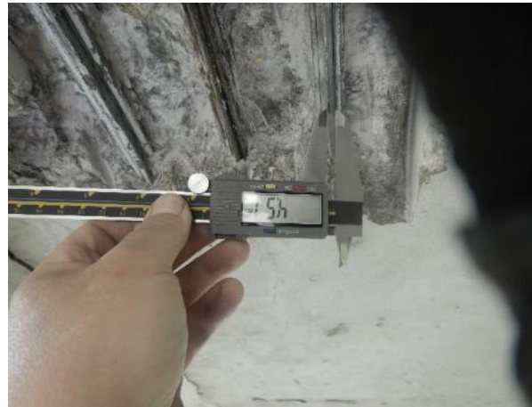
Obr. 34: SNK5, K6. Měření \varnothing předpínacího drátu.
