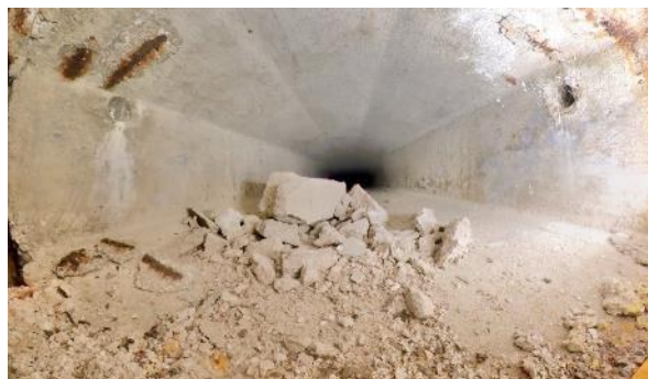
Obr. 40: N8P2. Pohled směrem od Pi2 k Op3.
