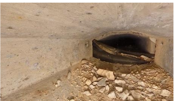
Obr. 27: N3P2. Pohled směrem od Op3 k Pi2.
