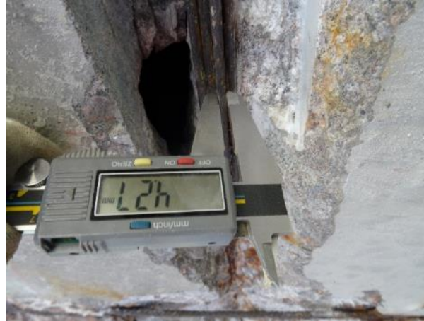
Obr. 110: SNK17, K7. Měření \varnothing předpínacího drátu.
