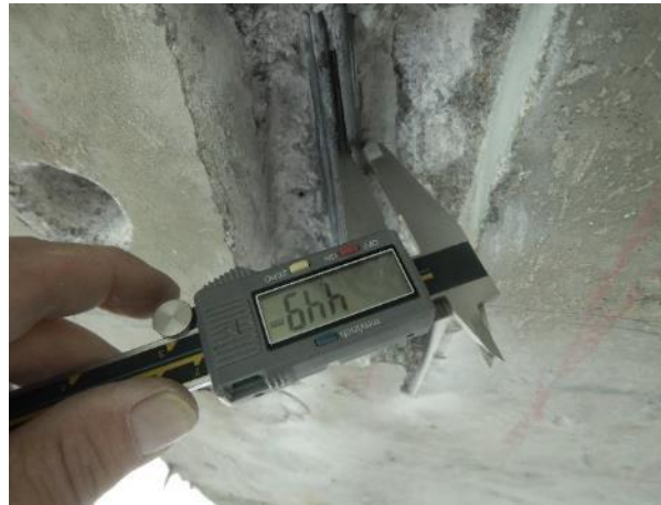
Obr. 64: SNK9, K4. Měření \varnothing předpínacího drátu.
