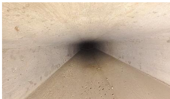
Obr. 14: N7P1. Pohled směrem k Pi2.
