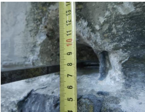
Obr. 83: S NK 12, K3. Měření polohy kabelu vůči spodnímu povrchu nosníku
