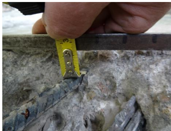
Obr. 148: Měření polohy detekované, resp. obnažené měkké výztuže.
