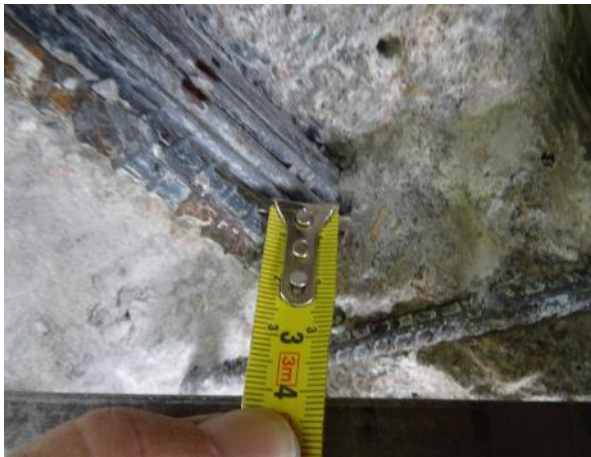
Obr. 159: SNK23, K3. Minim. krytí kabelu K3 vůči fasádní straně nosníku.
