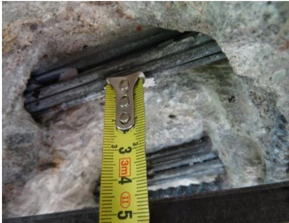
Obr. 157: SNK23, K2. Minim. krytí kabelu K2 vůči fasádní straně nosníku.
