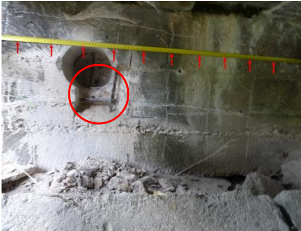
Obr. 15: Levý kraj Op3 se zvýrazněním polohy sondy S ss3 . S Měření roztečí detekované svislé výztuže.
