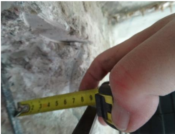
Obr. 11: Sss2. Měření krycí vrstvy svislé výztuže.
