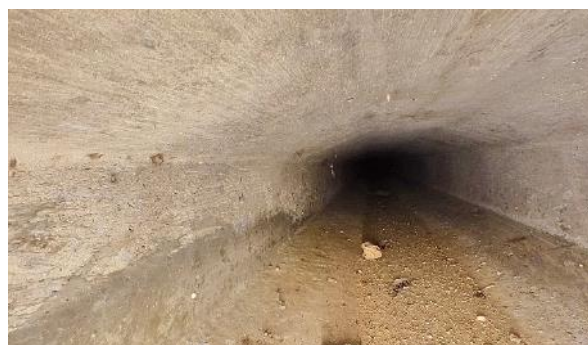
Obr. 28: N3P2. Pohled směrem od Pi2 k Op3.
