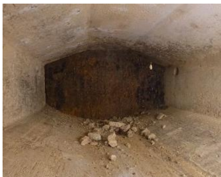
Obr. 47: N10P2. Pohled směrem od Pi2 k Op3.
