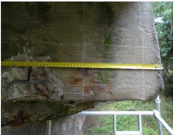
Obr. 29: Pi2 – Levá konzola ÚP staviva. Měření roztečí detekované svislé výztuže.
