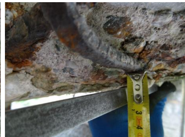
Obr. 42: S ss6 . Měření krycí vrstvy obvod. třmínek v jeho v spodní, vodorovné rovině vůči pohledu náběhu stativa.
