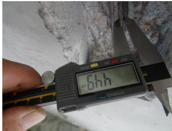
Obr. 28: SNK4, K7. Měření \varnothing předpínacího drátu.
