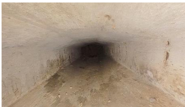
Obr. 3: N2P1. Pohled směrem k Op1.
