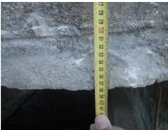
Obr. 101: SNK16. Výšková poloha kabelu K3 vůči spodnímu povrchu nosníku N1.
