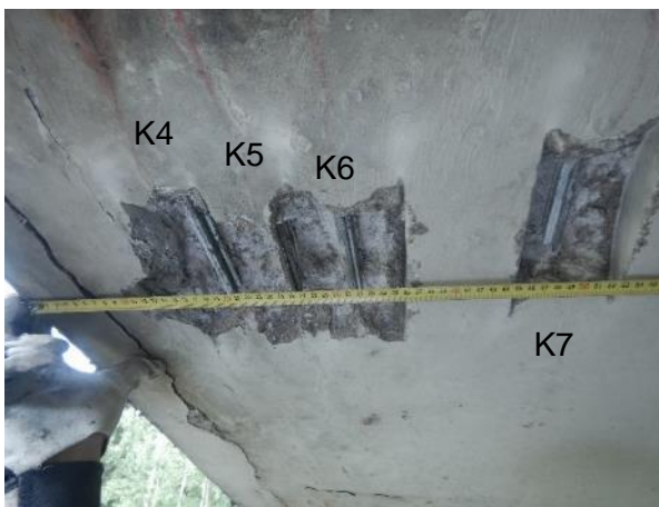
Obr. 29: Pohled nosníku N1, 6,8 m od čela Op1, 5,6 od čela ÚP Pi2. SNK5, K4 – K7. Půdorysná poloha kabelu K7 vztahena k podél. kraji nosníku.
