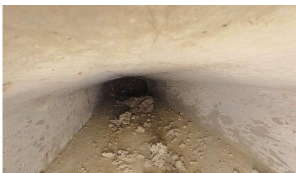
Obr. 9: N5P1. Pohled směrem k Op1.
