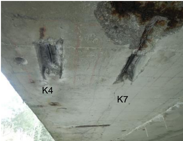
Obr. 57: Podhled nosníku N10 v místě sondy S NK9 (6,3 m od čela Op1 a 6,1m od Pi2). Obnažené kabely K4P a K7
