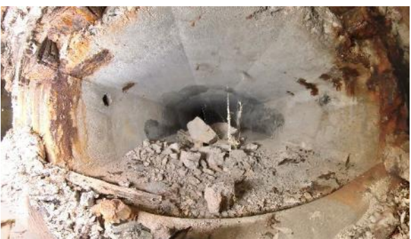
Obr. 43: N9P1. Pohled směrem od Pi2 k Op1.
