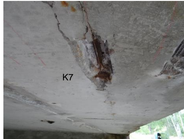
Obr. 104: Obnažený kabel K7 nosníku N1 v pohledu směrem k Pi2.
