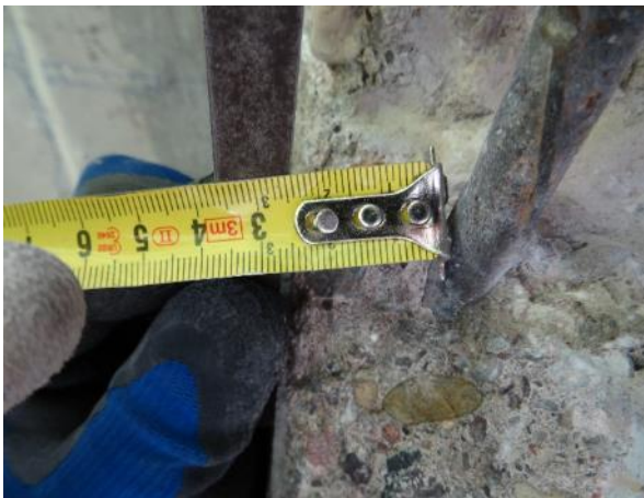
Obr. 35: S ss5 . Měření krycí vrstvy spodní vodorovné výztuže (rozdělovací) uvnitř obvod. třmínku.
