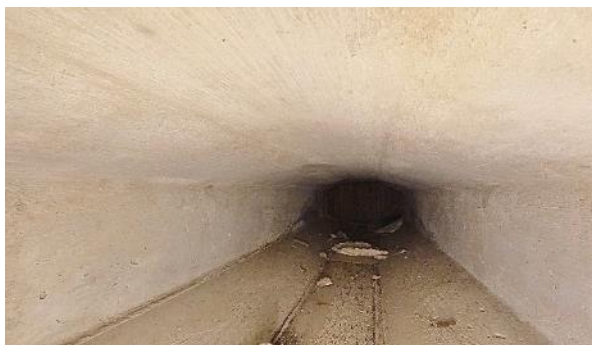
Obr. 15: N8P1. Pohled směrem k Op1.
