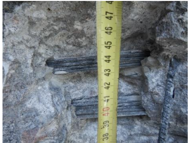
Obr. 100: SNK16. Výšková poloha kabelu K2 vůči spodnímu povrchu nosníku N1.
