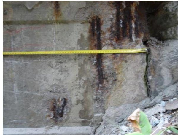
Obr. 166: Fasáda konce nosníku N10 ve 2. poli nad Op3. Měření polohy detekované (georadarem), resp. obnažené měkké výztuže.
