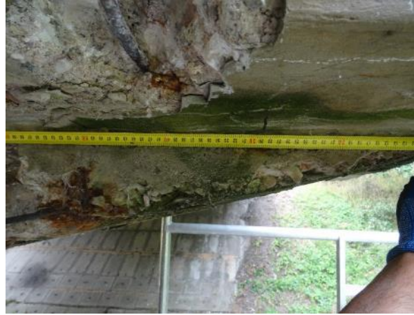
Obr. 38: Bok šikmého náběhu pravostran. konzoly stativa. Měření roztečí detekované výztuže.
