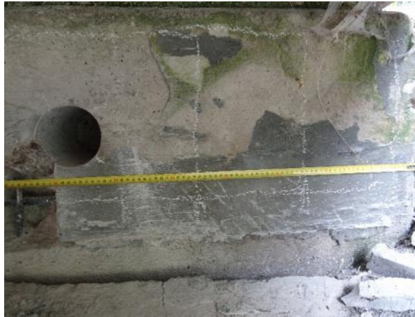
Obr. 22: Pravý kraj Op3. Měření roztečí detekované svislé výztuže.
