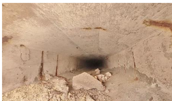
Obr. 22: N1P2. Pohled směrem od Pi2 k Op3.
