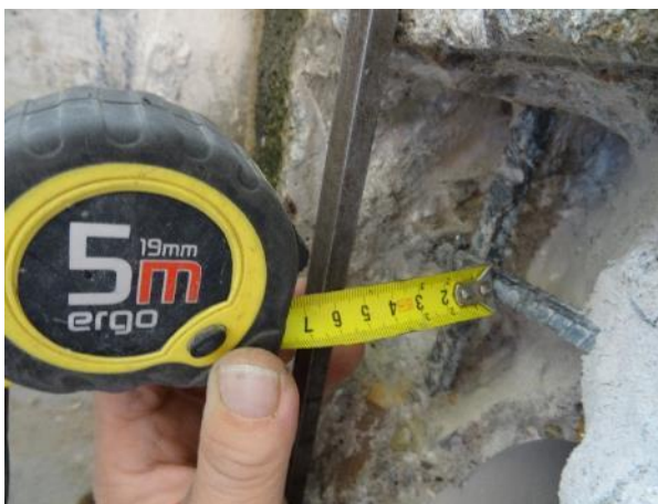
Obr. 5: Sss1. Měření krytí svislé výztuže.
