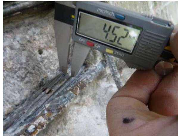
Obr. 160: SNK23, K3. Měření \varnothing předpínacího drátu kabelu K3.
