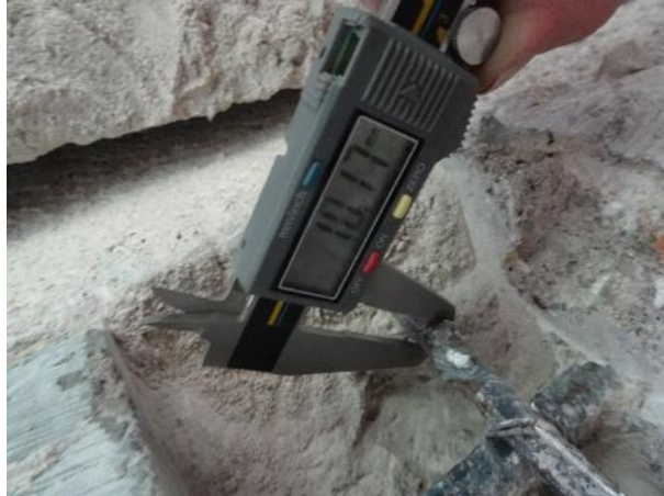
Obr. 26: S SS4 . Zjištěný \varnothing svislé výztuže.
