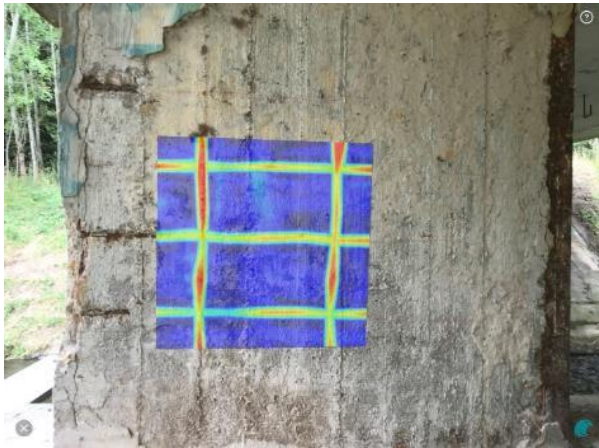
Obr. 5.3-9: Levá stojka Pi2. Rastr výztuže ve stojce detekované plošným georadarovým skenem skenu zobrazeným přímo na konstrukci.
