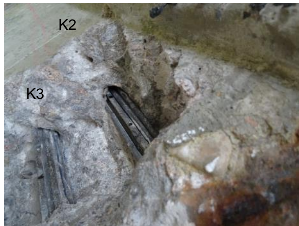
Obr. 132: S NK 20, K2 a K3. Kanálek vyplněn jen ve spodní část. K2 – dráty bez koroze. K3 – na drátech přítomnost koroze. zplodin.
