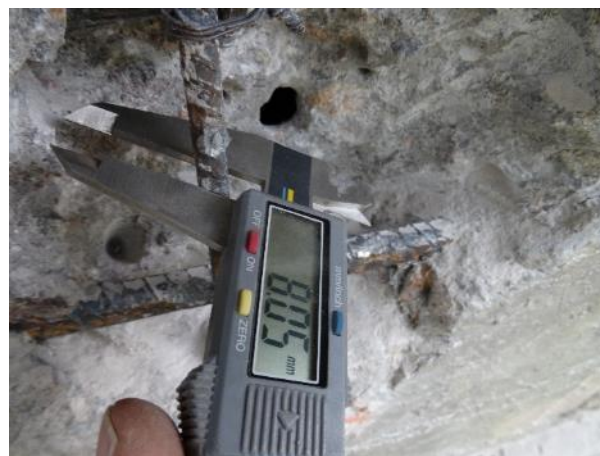
Obr. 12: Měření \varnothing svislé výztuže.
