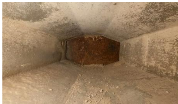
Obr. 24: N1P2. Pohled směrem k Op3.
