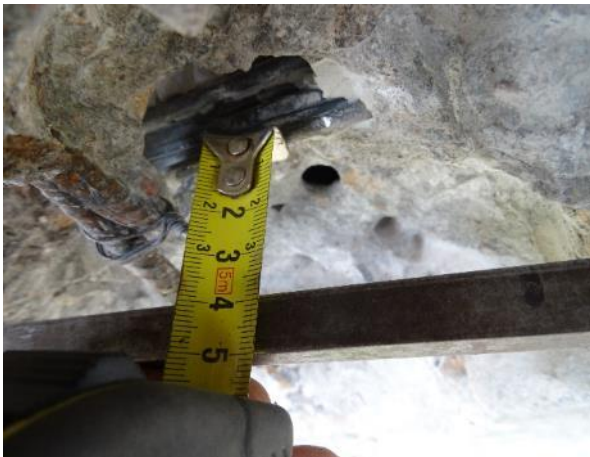
Obr. 9: SNK2, K3. Minim. krytí kabelu K3 vůči fasádní straně nosníku.
