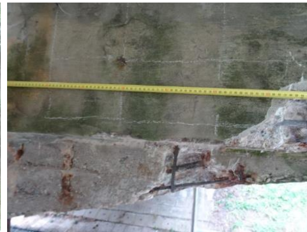
Obr. 30: Pi2 – Levá konzola ÚP staviva. Měření roztečí detekované svislé výztuže – pokr.
