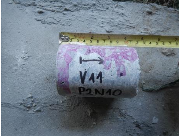
Obr. 5.1-11: Vzorek betonu V11 o \varnothing 75 mm odebraný v 2. poli z fasádní stěny nosníku N10 v oblasti jeho konce u Op3.
