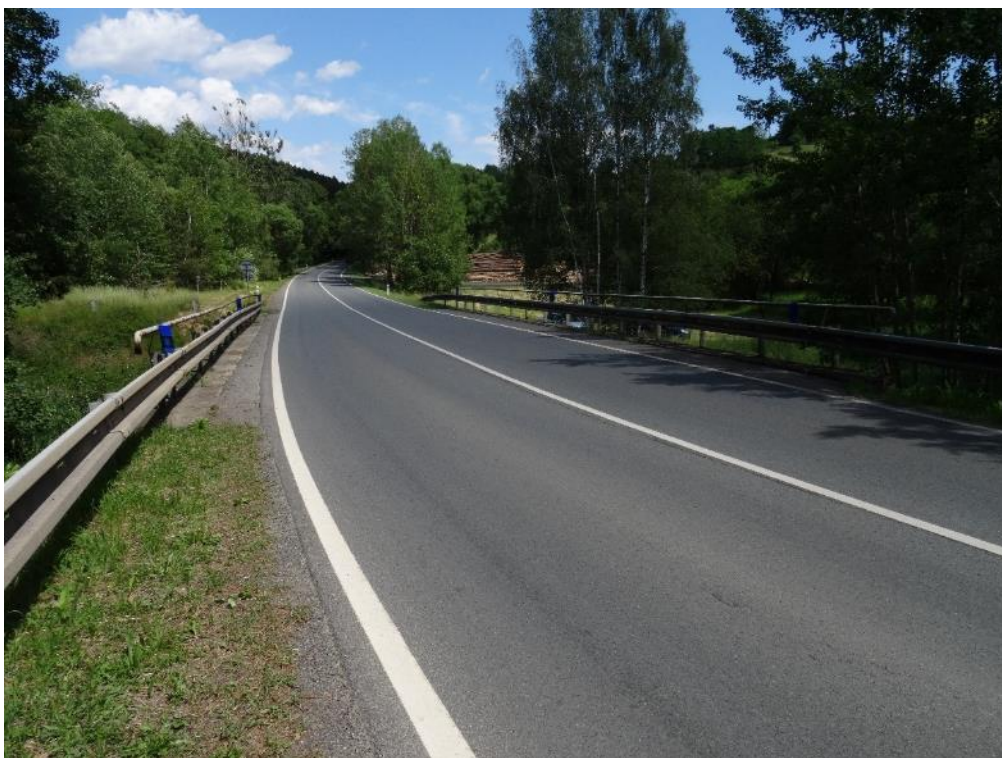
Obr.2-3: Pohled na most proti směru staničení.
