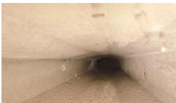
Obr. 19: N10P1. Pohled směrem k Op1.
