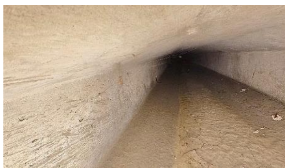
Obr. 20: N10P1. Pohled směrem k Pi2.
