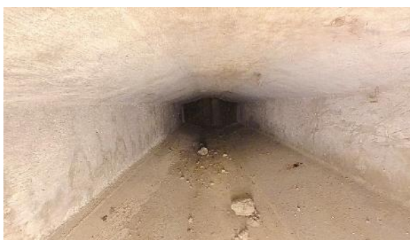
Obr. 17: N9P1. Pohled směrem k Op1.
