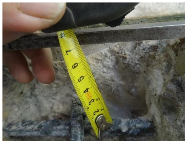
Obr. 6: Sss1. Měření krytí vodorovné výztuže.
