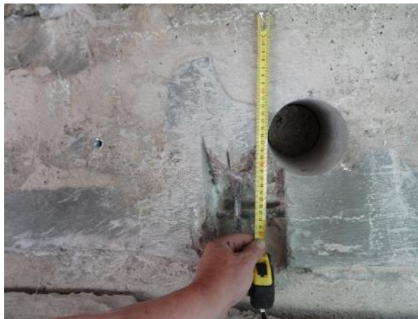
Obr. 24: Pravý kraj Op3. Měření polohy detekované vodorovné výztuže.
