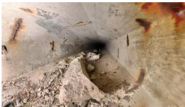
Obr. 45: N10P1. Pohled směrem od Pi2 k Op1.
