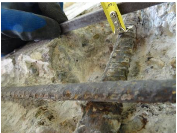
Obr. 5.3-16: Sss8. Měření krycí vrstvy svislé výztuže (dle dochov. PD pol. č. 4) vyvedené ze stojky pilíře do konzoly stativa.
