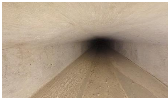
Obr. 6: N3P1. Pohled směrem k Pi2.
