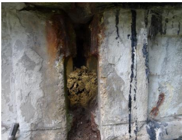
Obr. 89: SNK14 a SNK22. Stav kotev předpětí na konci nosníků N10 nad Pi2.
