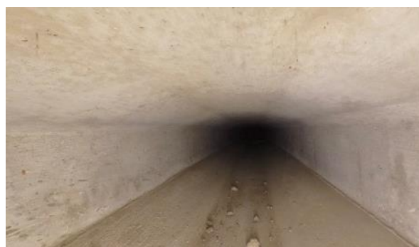
Obr. 10: N5P1. Pohled směrem k Pi2.
