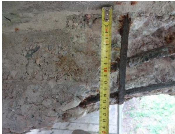
Obr. 40: Bok šikmého náběhu pravostran. konzoly stativa. Měření polohy detekované šikmé výztuže.
