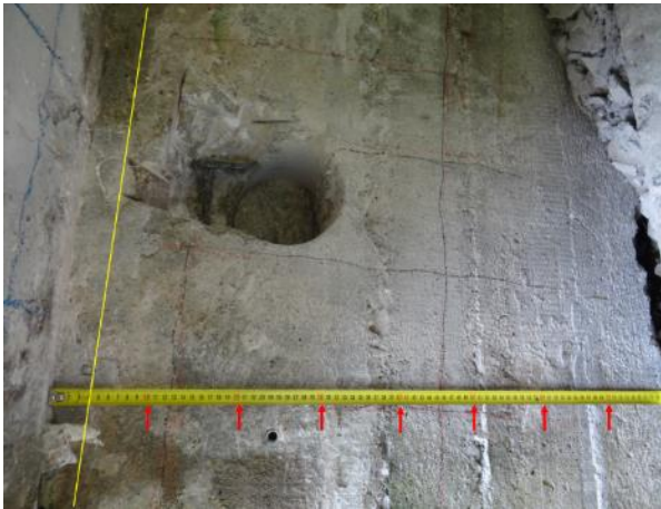
Obr. 9: Pravý konec Op1. Měření polohy detekované vodorovné výztuže.
