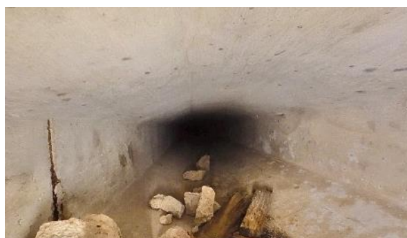
Obr. 42: N9P2. Pohled směrem od Pi2 k Op3.
