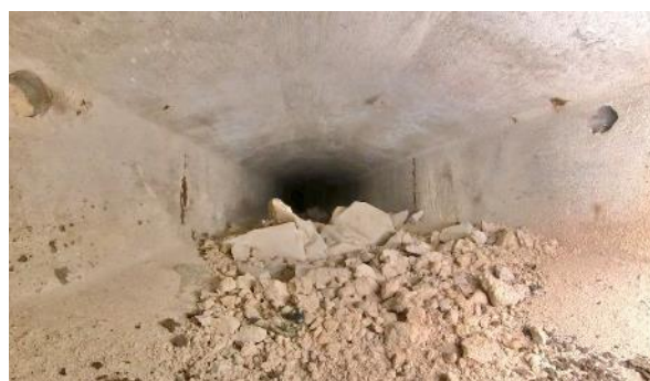
Obr. 26: N2P2. Pohled směrem od Pi2 k Op3.
