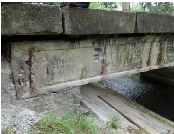
Obr. 143: Konec nosníku N1 nad Op3 (2. pole).
