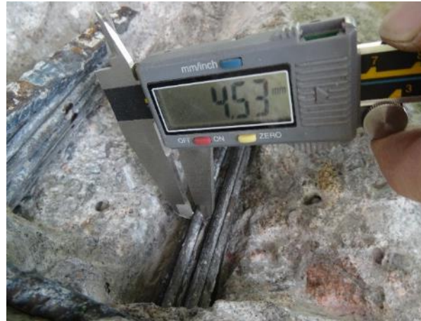
Obr. 158: SNK23, K2. Měření \varnothing předpínacího drátu kabelu K2.
