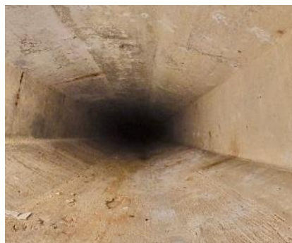
Obr. 48: N10P2. Pohled směrem od Op3 k Pi2.
