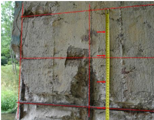
Obr. 51: Měření polohy detekované vodor. výztuže (obvodové třmínky stojky).
