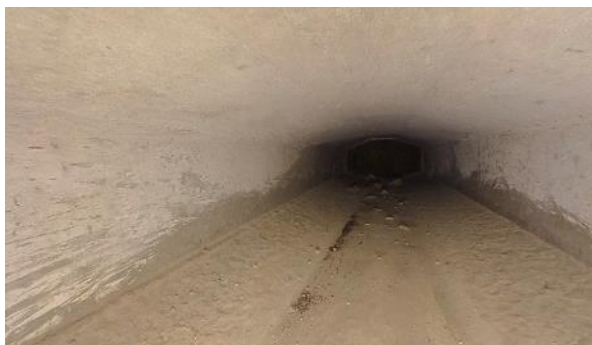
Obr. 5: N3P1. Pohled směrem k Op1.
