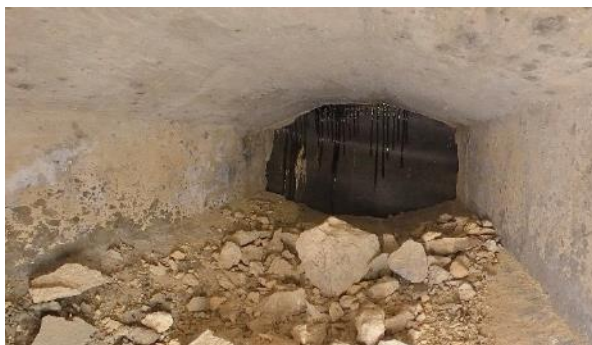
Obr. 31: N5P2. Pohled směrem od Op3 k Pi2.
