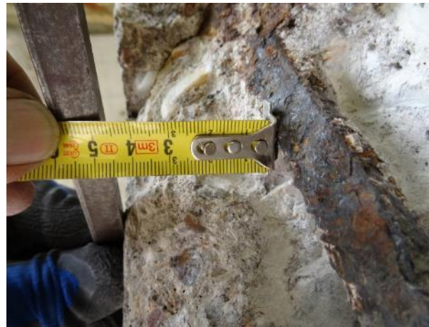
Obr. 52: S ss8 . Měření krycí vrstvy svislé rohové výztuže (dle dochov. PD pol. č. 3) vyvedené ze stojky pilíře do konzoly stativa.
