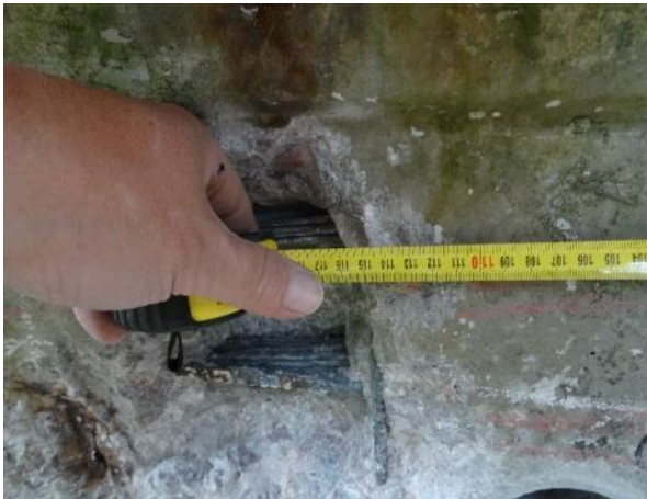
Obr. 165: S NK23 . Měření polohy sekané sondy vůči konci nosníku nad Op3. n
