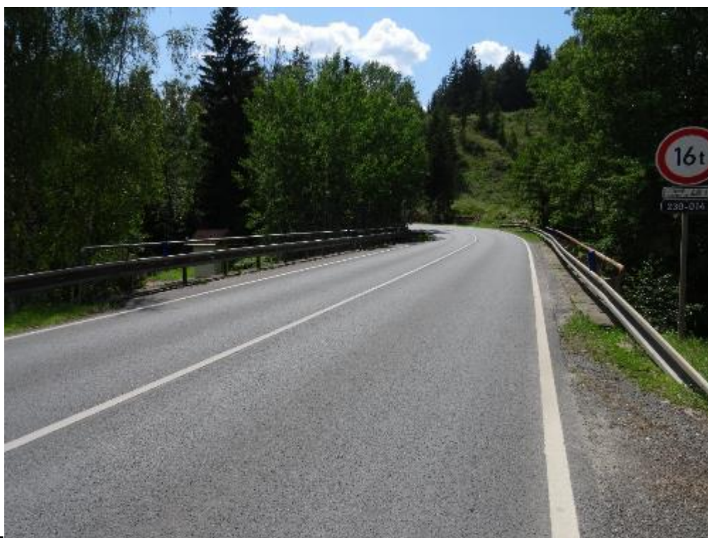
Obr.2-2: Pohled na most ve směru staničení.
