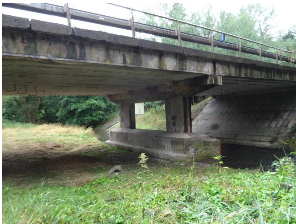
Obr.2-4: Pravá (návodní) strana mostu.
