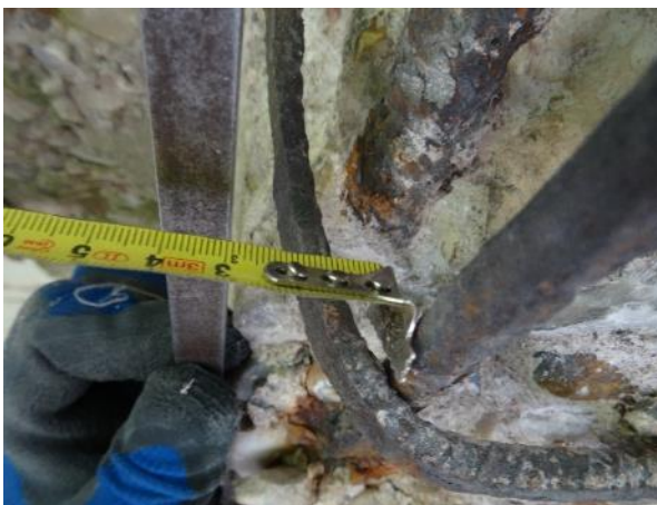
Obr. 47: S ss6 . Měření krycí vrstvy koutové rozdělovací výztuže (dle dochov. PD pol. č. 10) vyvedené z stojky pilíře.
