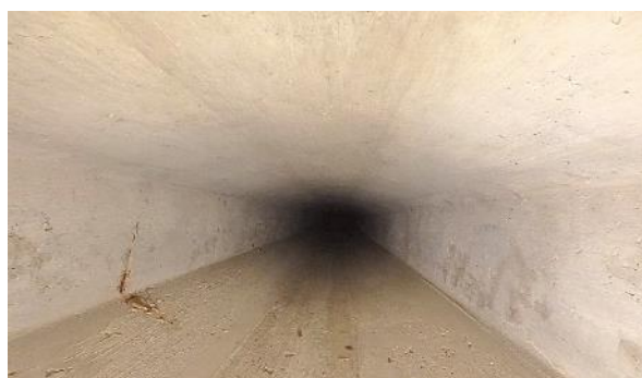
Obr. 12: N6P1. Pohled směrem k Pi2.
