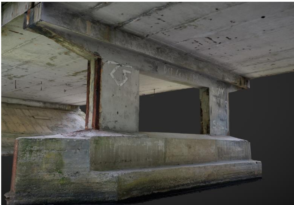
Obr.4.1-11: Pi2 Pi2) v pohledu z 2. mosního otvoru (MO) a zachycená část pohledu NK v 1. a 2.poli.
