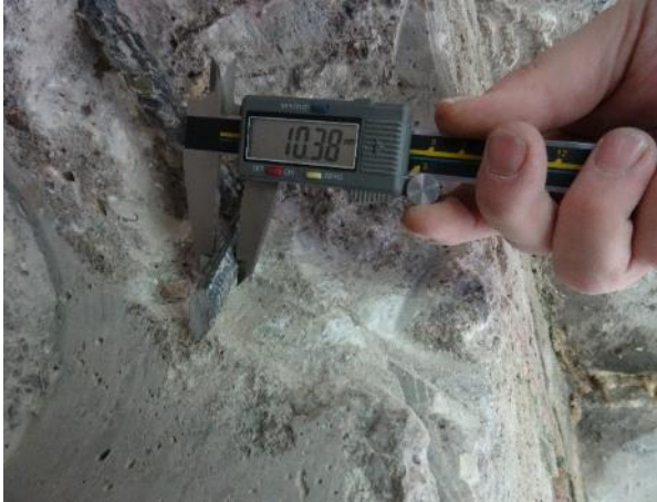
Obr. 13: S ss2 . Zjištěný \varnothing svislé výztuže.
