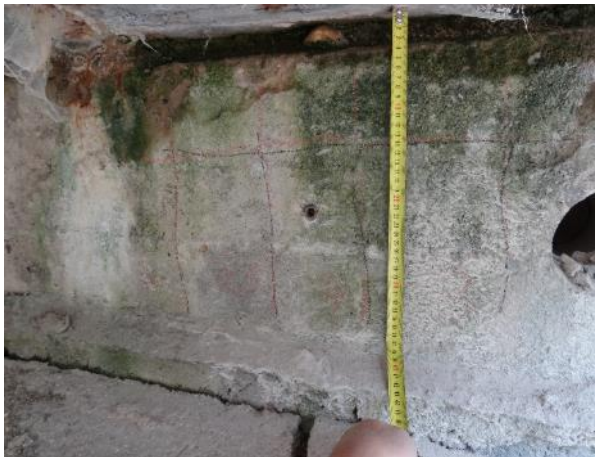
Obr. 3: Měření polohy detekované vodorovné výztuže.
