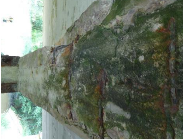
Obr. 37: Podhled šikmého náběhu pravé konzoly stativa. Obnažená korodující výztuž Dna středových třmínek stativa.
