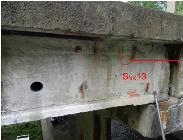
Obr. 85: Konec nosníku N10 nad Pi2. Označená poloha sekané sondy SNK13.
