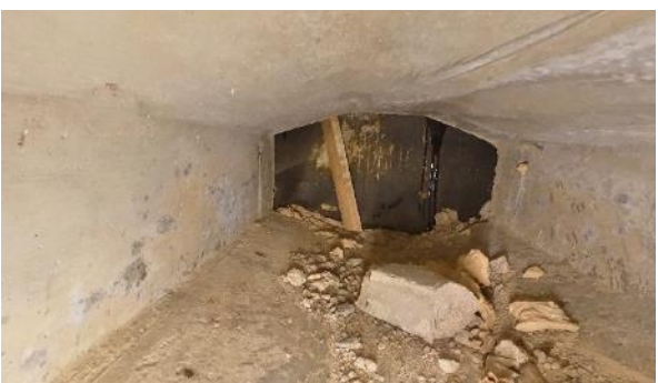
Obr. 35: N7P2. Pohled směrem od Op3 k Pi2.
