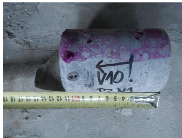
Obr. 5.1-10: Vzorek betonu V10 o \varnothing 75 mm odebraný v 2. poli z fasádní stěny nosníku N1 v oblasti jeho konce u Pi2.
