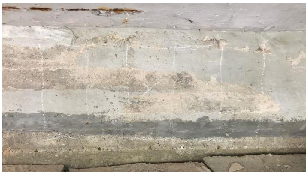
Obr. 5.3-5: Rastr detekované výztuže ve střední části Op3.
