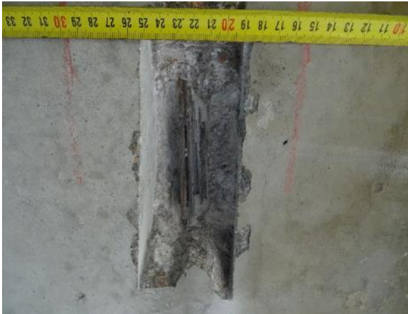
Obr. 21: Podhled nosníku N1, 1,9 m od čela Op1. SNK4, K5. Půdorysná poloha kabelu K5 vztahena k podél. kraji nosníku. Červené rysky – vyznačená poloha kabelu K4 a K6.
