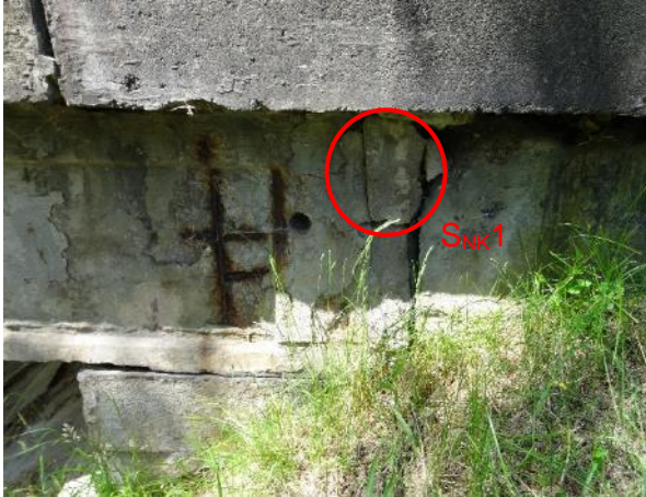
Obr. 1: Konec nosníku N1 nad Op1. Označená poloha sekané sondy SNK1.
