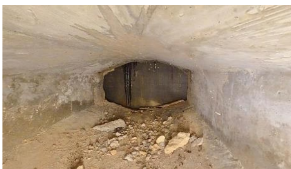
Obr. 33: N6P2. Pohled směrem od Op3 k Pi2.
