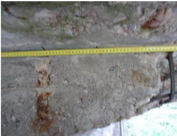
Obr. 39: Bok šikmého náběhu pravostran. konzoly stativa. Měření roztečí detekované výztuže – pokračování.
