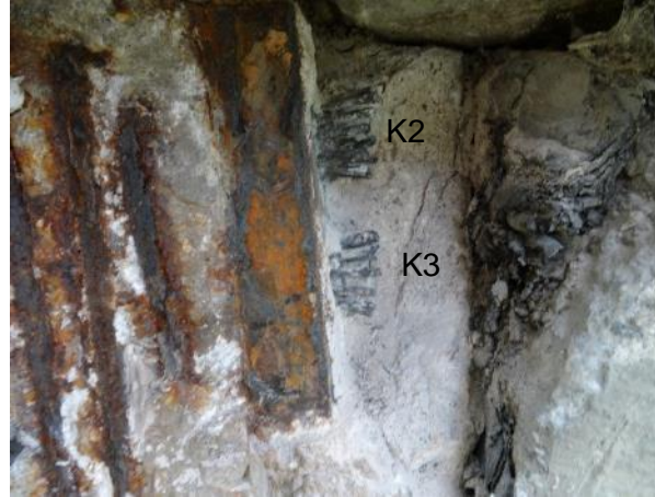
Obr. 2: Sekaná sonda SNK1 – obnažená kotva kabelů K2, K3.
