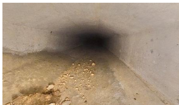
Obr. 36: N7P2. Pohled směrem od Pi2 k Op3.
