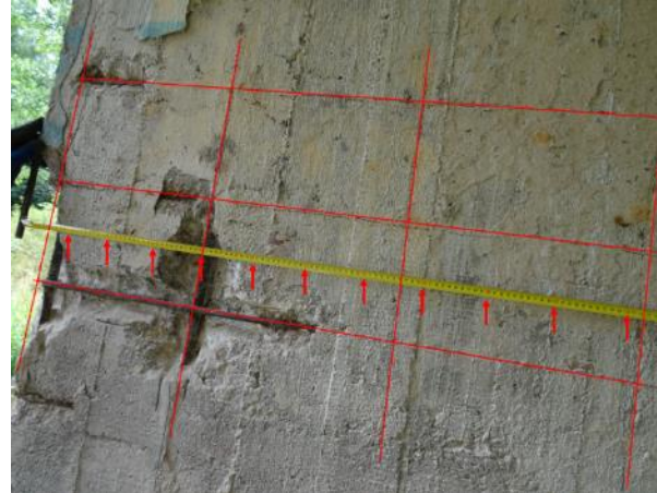
Obr. 50: Levá stojka Pi2. Měření roztečí detekované svislé výztuže.
