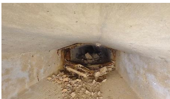
Obr. 41: N9P2. Pohled směrem od Op3 k Pi2.
