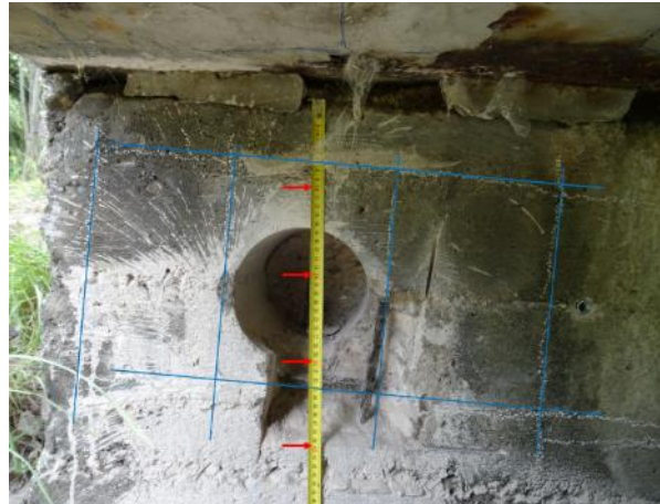
Obr. 16: Levý kraj Op3. Měření polohy detekované vodorovné výztuže
