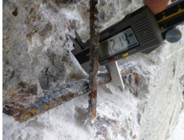
Obr. 14: Měření \varnothing vodorovné výztuže.
