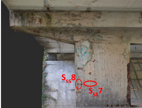
Obr. 49: Levá část Pi2. Stav levé stojky před provedením sekaných sond. Označeno místo zamýšlené sondy S ss7 a S ss8 .
