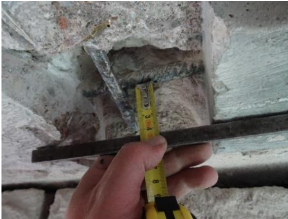
Obr. 27: S SS4 . Měření krycí vrstvy vodorovné výztuže
