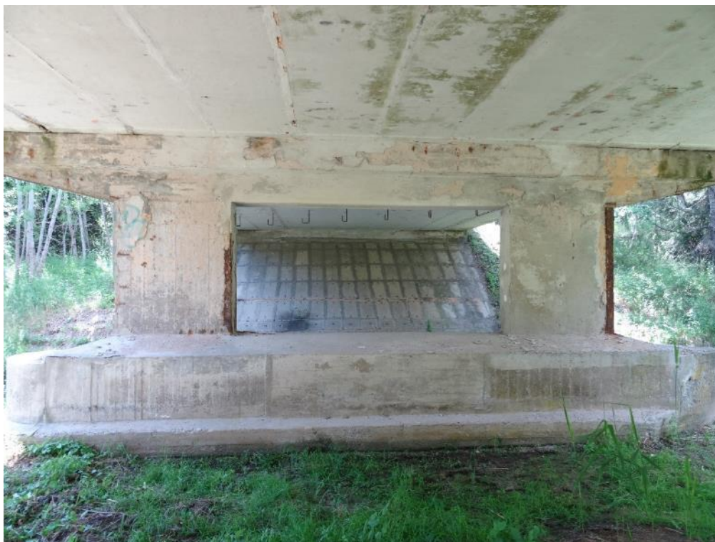
Obr.2-7: Středová podpěra v pohledu z 1. MO a zachycená část pohledu NK v 1. poli.
