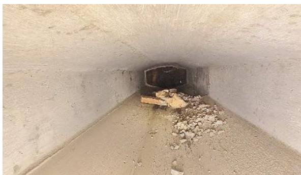
Obr. 13: N7P1. Pohled směrem k Op1.
