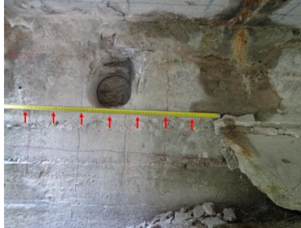
Obr. 8: Pravý konec Op1. Měření roztečí detekované svislé výztuže – pokračování.
