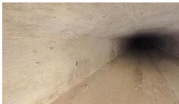
Obr. 4: N2P1. Pohled směrem k Pi2.
