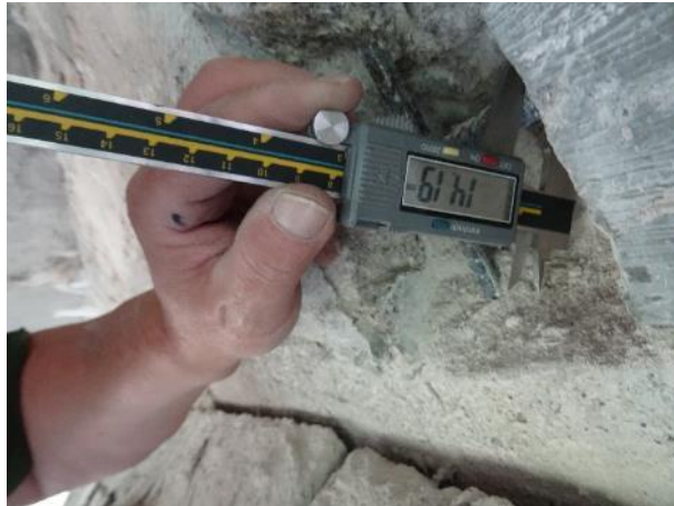
Obr. 28: S SS4 . Zjištěný \varnothing vodorov. výztuže.
