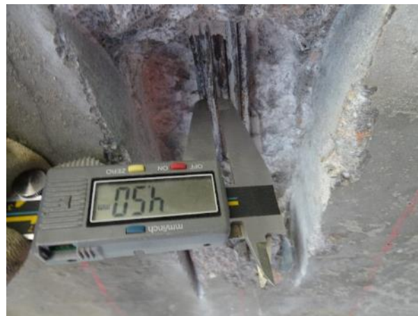
Obr. 114: SNK17, K5. Měření \varnothing předpínacího drátu.
