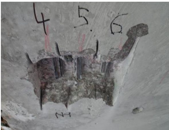
Obr. 41: Podhled nosníku N9, 1,9m od čela Op1. S NK7 , K4P – K6P.
