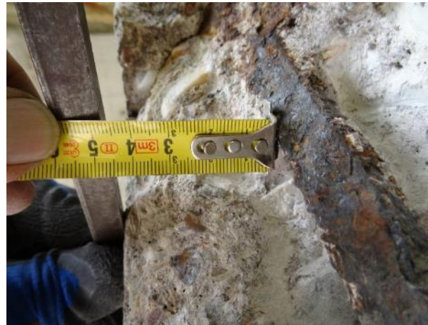
Obr. 5.3-15: Sss8. Měření krycí vrstvy svislé rohové výztuže (dle dochov. PD pol. č. 3) vyvedené ze stojky pilíře do konzoly stativa.
