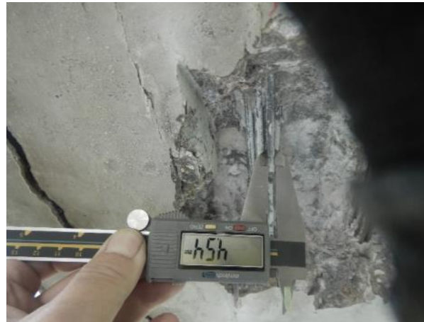
Obr. 32: SNK5, K4. Měření \varnothing předpínacího drátu.
