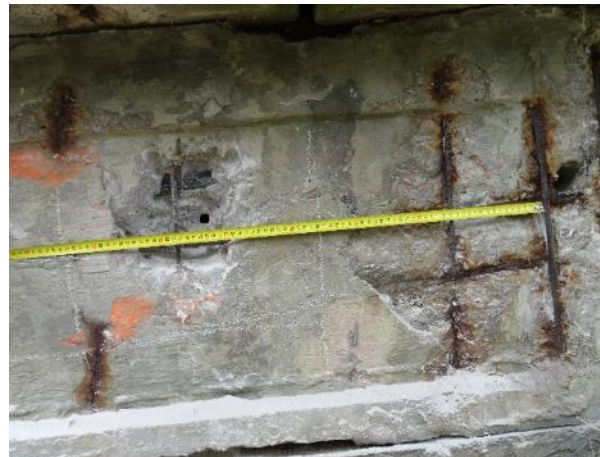
Obr. 10: Konec N1 nad Op1. Měření polohy měkké výztuže1.
