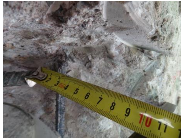
Obr. 12: Sss2. Měření krytí vodorovné výztuže.
