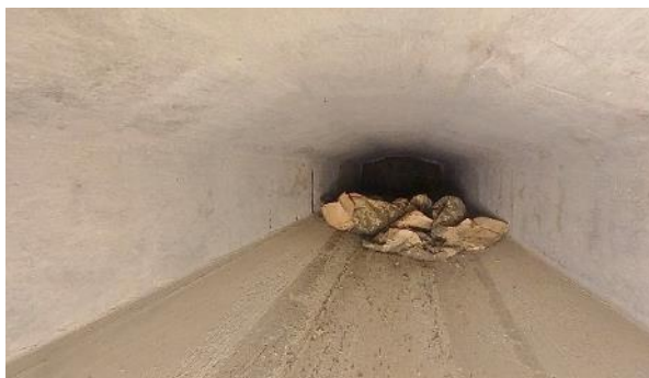
Obr. 7: N4P1. Pohled směrem k Op1.
