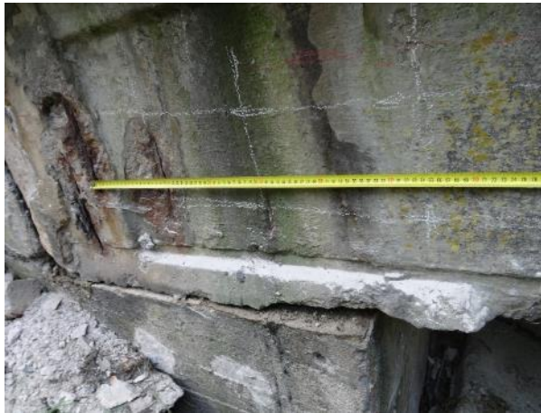
Obr. 70: Konec nosníku N10 nad Op1. Měření rozmístění detekované měkké výztuže.
