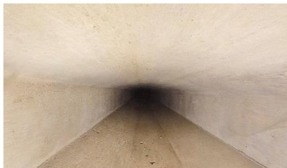
Obr. 16: N8P1. Pohled směrem k Pi2.
