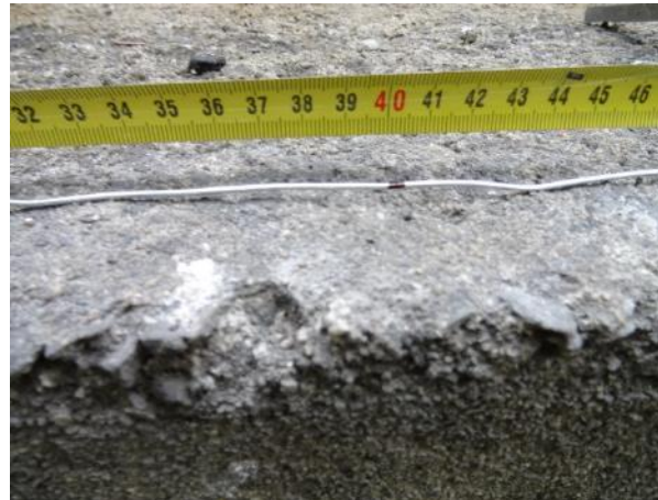
Obr. 134: S NK 20, K2. Změřená délka prostupu ocel. lanka nevyplněným kanálkem směrem ke kotvě.
