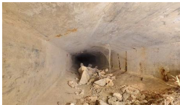
Obr. 46: N10P2. Pohled směrem od Pi2 k Op3.
