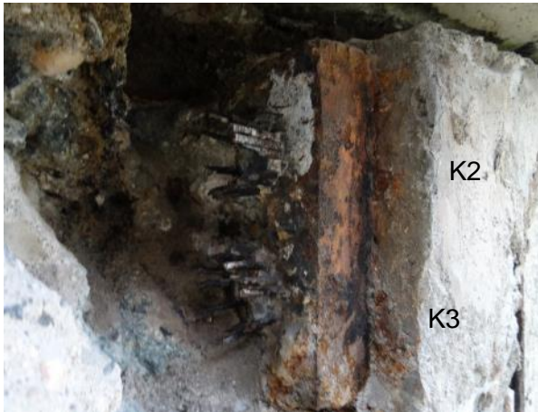
Obr. 139: SNK21. Obnažená levá horní kotva s kabely K2 a K3.
