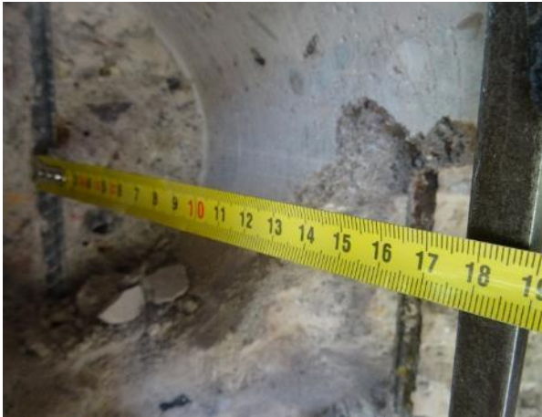
Obr. 21: Měření polohy třmínku hlouběji uloženého v Op1.
