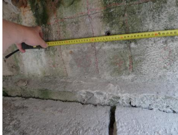
Obr. 2: Měření roztečí detekované svislé výztuže – pokračování.
