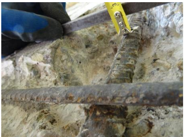
Obr. 53: S ss8 . Měření krycí vrstvy svislé výztuže (dle dochov. PD pol. č. 4) vyvedené ze stojky pilíře do konzoly stativa.
