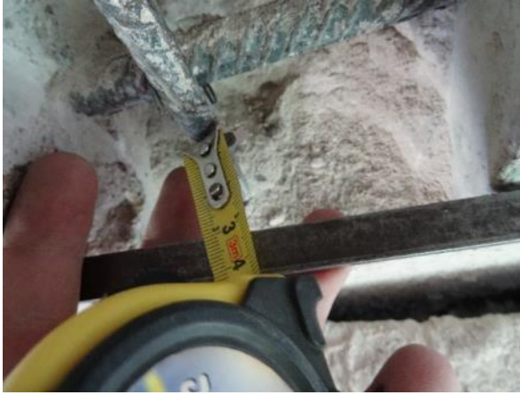
Obr. 25: S SS4 . Měření krycí vrstvy svislé výztuže
