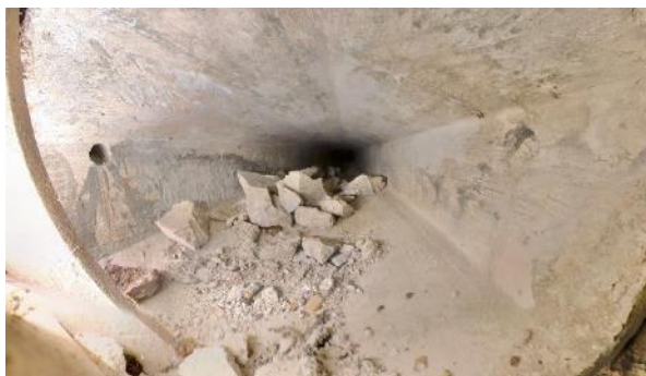
Obr. 39: N8P1. Pohled směrem od Pi2 k Op1.
