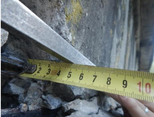
Obr. 19: SNK3, K3. Minim. krytí kabelu K3 vůči fasádní straně nosníku.
