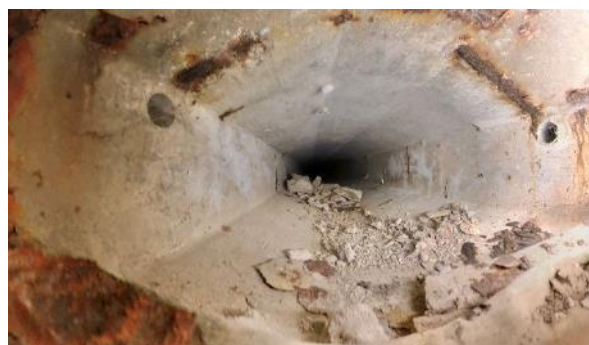
Obr. 44: N9P2. Pohled směrem od Pi2 k Op3.
