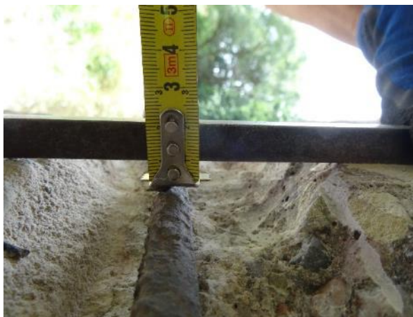
Obr. 55: S SS8 . Měření krycí vrstvy obvod. třmínku stojky.
