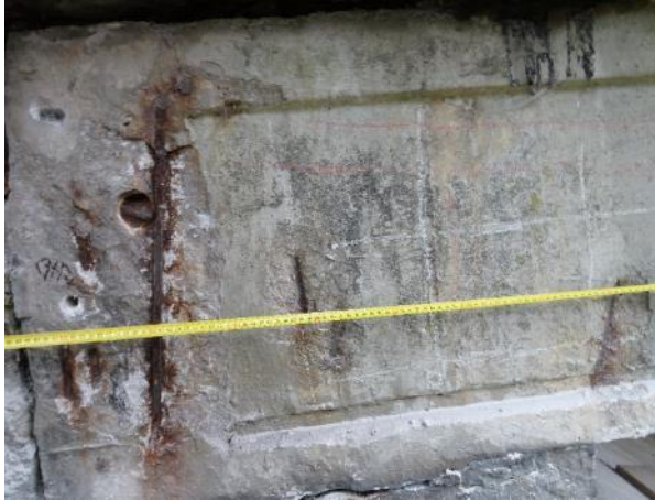
Obr. 145: Měření polohy detekované, resp. obnažené měkké výztuže.
