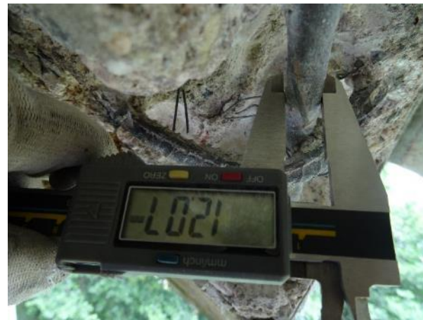
Obr. 36: S ss5 . Zjištěný \varnothing vodorov. výztuže.
