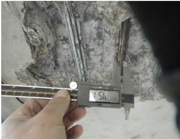
Obr. 33: SNK5, K5. Měření \varnothing předpínacího drátu.
