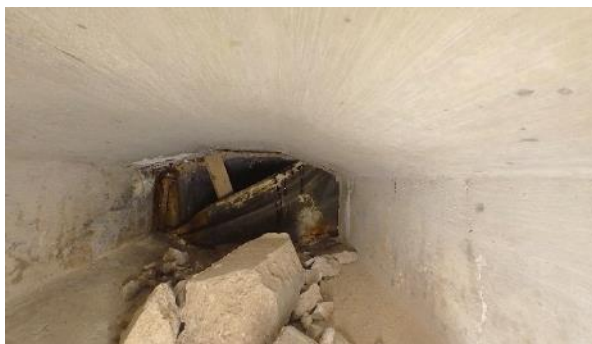
Obr. 37: N8P2. Pohled směrem od Op3 k Pi2.
