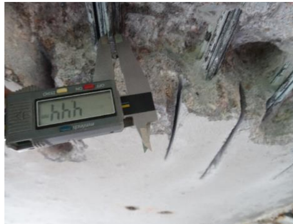
Obr. 52: SNK8, K6. Měření \varnothing předpínacího drátu.
