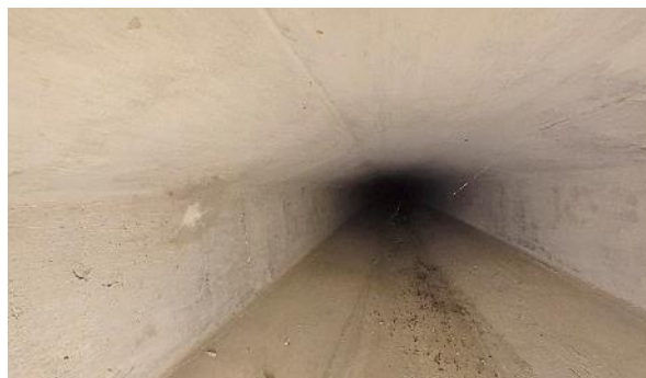
Obr. 8: N4P1. Pohled směrem k Pi2.
