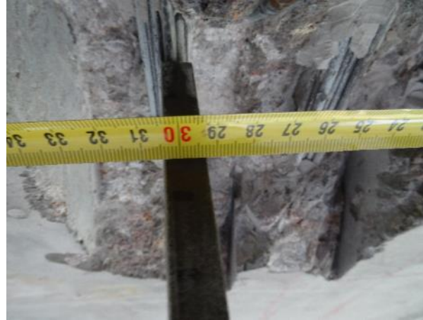
Obr. 128: S NK 19, K6. Půdorys. poloha kabelu K6 vztahena k podél. kraji nosníku.
