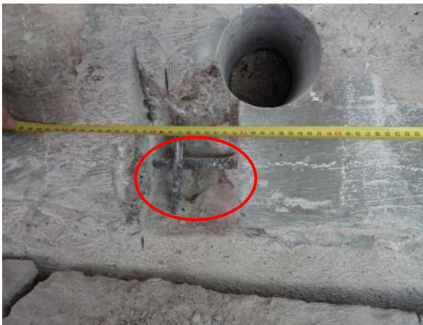
Obr. 23: Pravý kraj Op3 se zvýrazněním polohy sondy S SS4 . Měření roztečí detekované svislé výztuže – pokračování.
