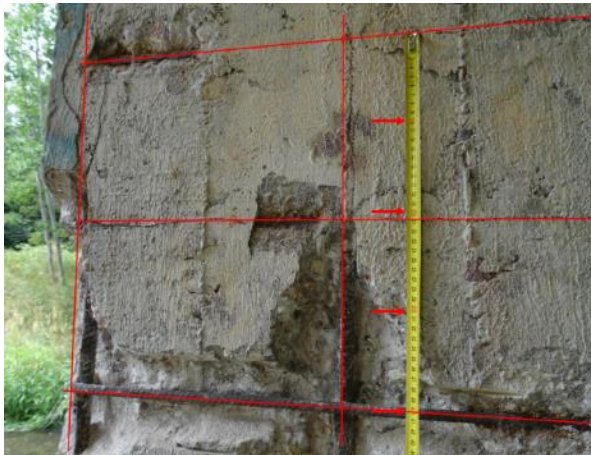
Obr. 5.3-14: Měření polohy detekované vodor. výztuže (obvodové třmínky stojky).
