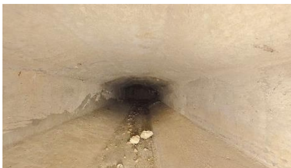
Obr. 1: N2P1. Pohled směrem k Op1.
