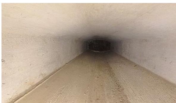
Obr. 11: N6P1. Pohled směrem k Op1.
