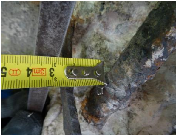
Obr. 45: S ss6 . Měření krycí vrstvy smykové výztuže (dle dochov. PD pol. č. 3) vyvedené z stojky pilíře.
