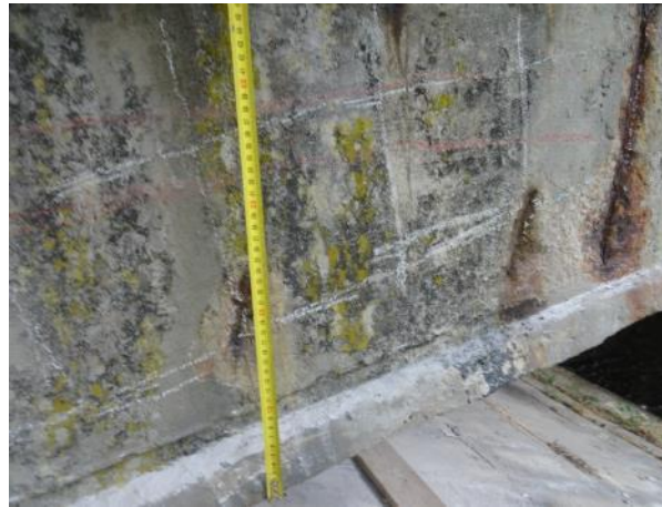
Obr. 148: Měření polohy detekované, resp. obnažené měkké výztuže.
