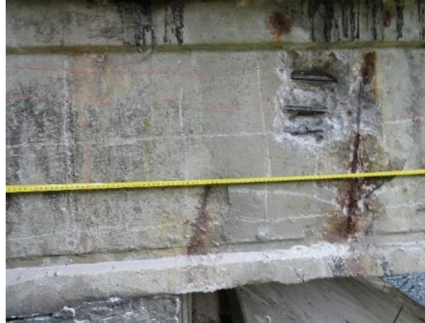
Obr. 146: Měření polohy detekované, resp. obnažené měkké výztuže (pokračování).
