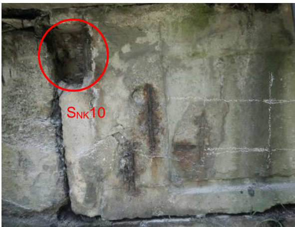
Obr. 65: Konec nosníku N10 nad Op1. Označená poloha sekané sondy SNK10.
