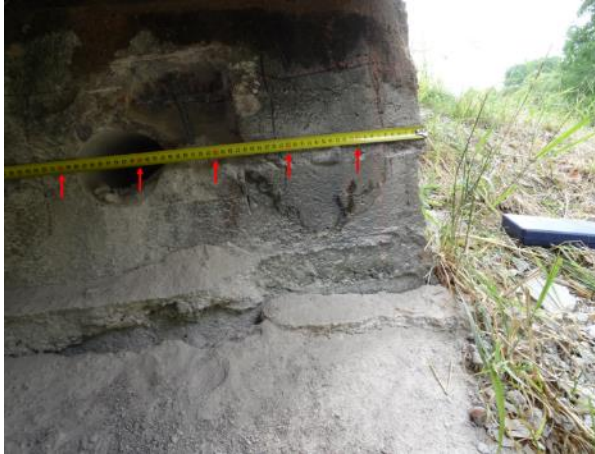
Obr. 1: Měření roztečí detekované svislé výztuže. U měření metrem vyznačené desítky centimetrů.
