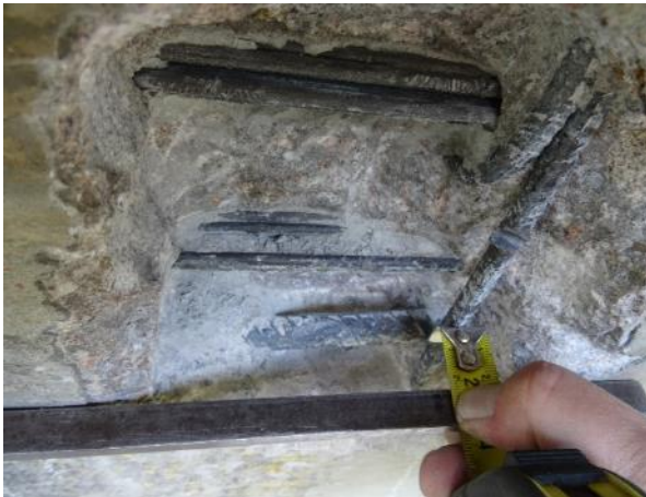
Obr. 75: SNK11. Měření minim. krytí obnažené měkké výztuže v místě sondy.
