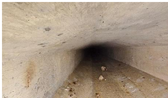
Obr. 30: N4P2. Pohled směrem od Pi2 k Op3.
