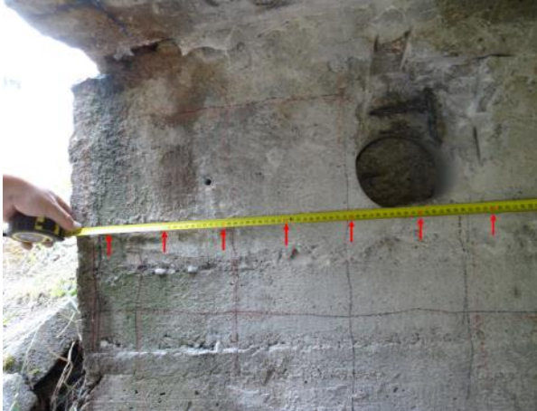
Obr. 7: Pravý konec Op1. Měření roztečí detekované svislé výztuže.
