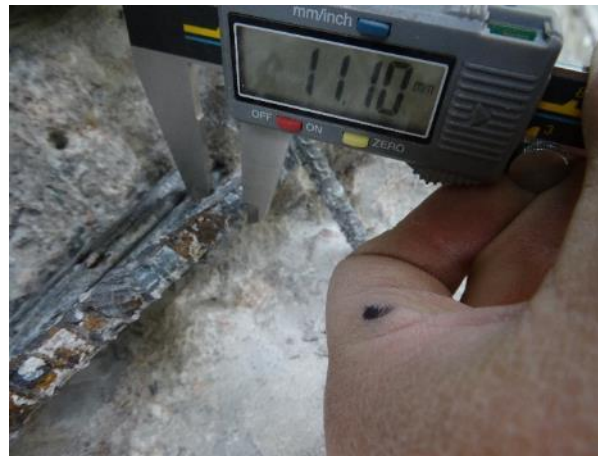
Obr. 162: Měření \varnothing vodorovné výztuže v místě sekané sondy SNK23.
