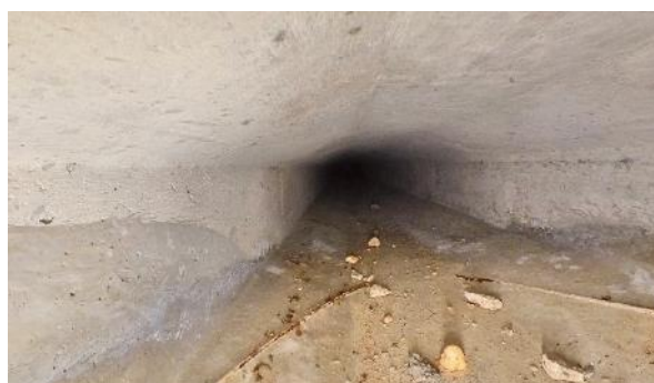
Obr. 34: N6P2. Pohled směrem od Pi2 k Op3.
