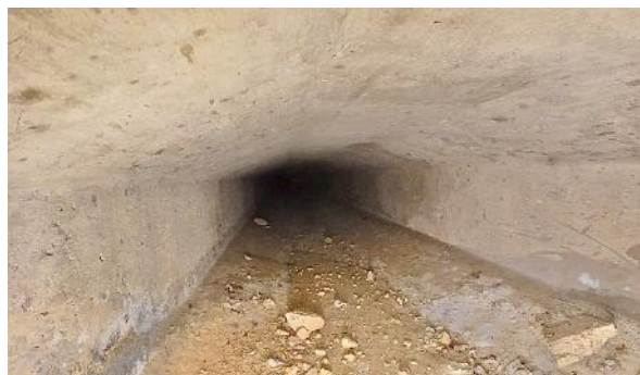
Obr. 32: N5P2. Pohled směrem od Pi2 k Op3.
