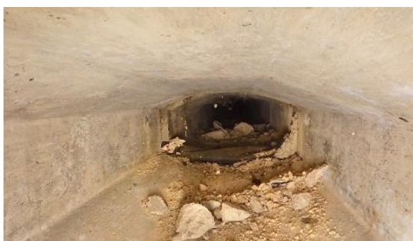
Obr. 25: N2P2. Pohled směrem od Op3 k Pi2.
