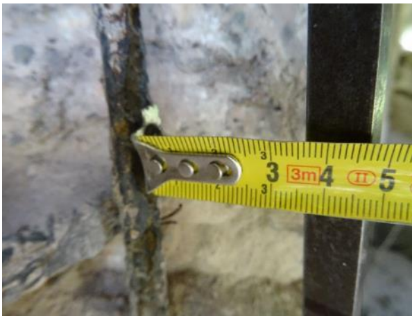
Obr. 17: S ss3 . Měření krycí vrstvy svislé výztuže.
