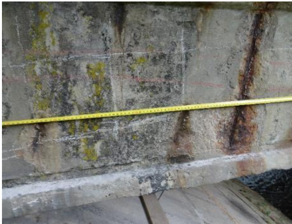
Obr. 147: Měření polohy detekované, resp. obnažené měkké výztuže.
