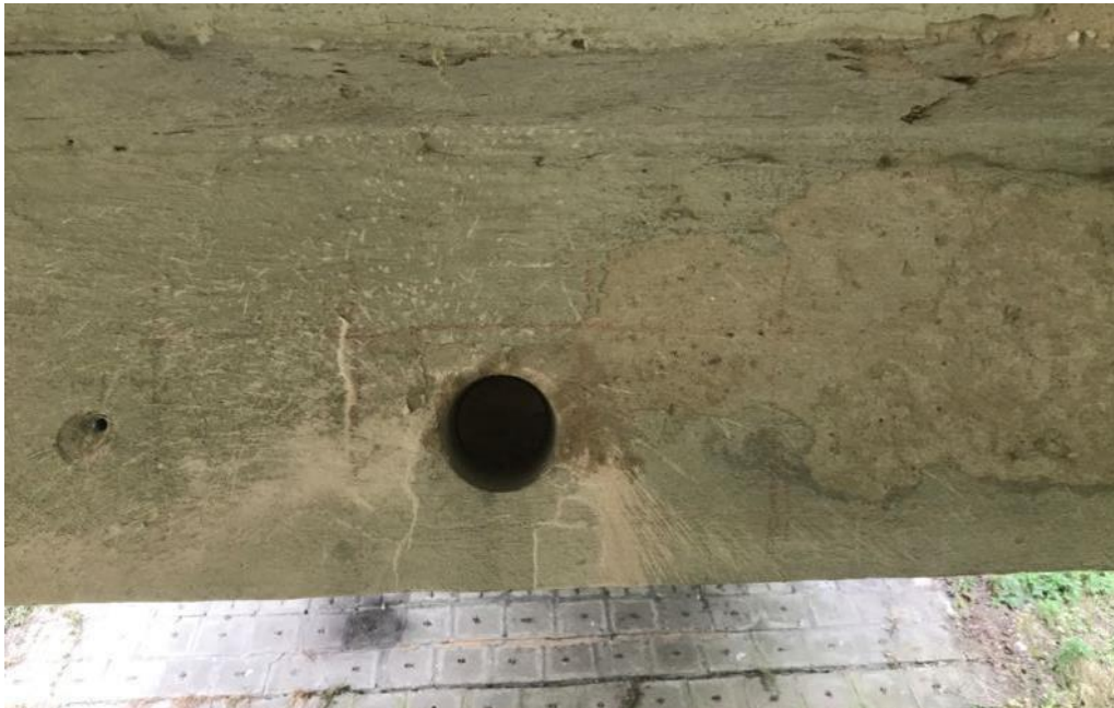
Obr. 5.3-7: Rastr detekované výztuže ve stavivu Pi2 mezi stojkami v jeho spodní části.
