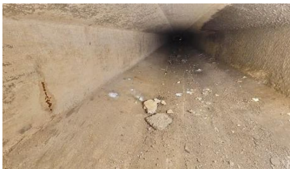
Obr. 23: N1P2. Pohled směrem od Op3 k Pi2.
