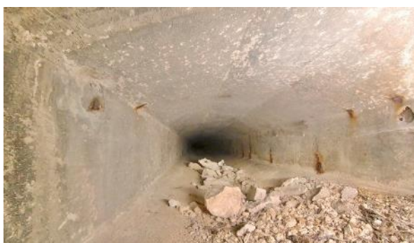
Obr. 21: N1P1. Pohled směrem od Pi2 k Op1.
