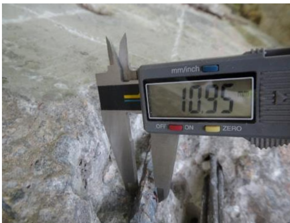
Obr. 149: Měření \varnothing vodorovné výztuže obnažené v místě sekané sondy S NK20 .
