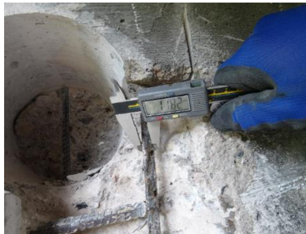
Obr. 18: S ss3 . Zjištěný \varnothing svislé výztuže.
