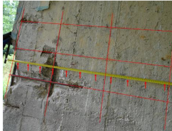
Obr. 5.3-13: Levá stojka Pi2. Měření roztečí detekované svislé výztuže.
