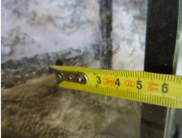
Obr. 19: S SS3 . Měření krycí vrstvy vodorovné výztuže.
