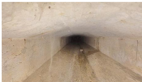
Obr. 2: N2P1. Pohled směrem k Pi2.
