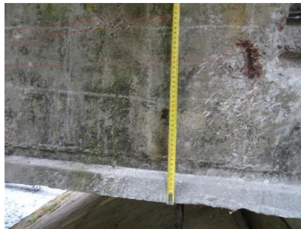
Obr. 168: Fasáda konce nosníku N10 ve 2. poli nad Op3. Měření polohy detekované měkké výztuže v opačném směru.
