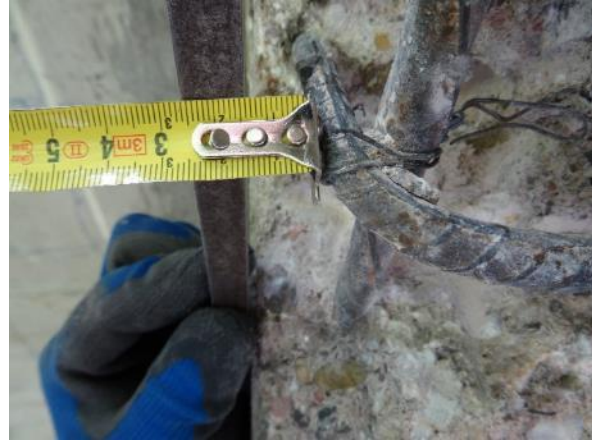
Obr. 32: S ss5 . Měření krycí vrstvy obvod. třmínku ÚP staviva v jeho svislé rovině.
