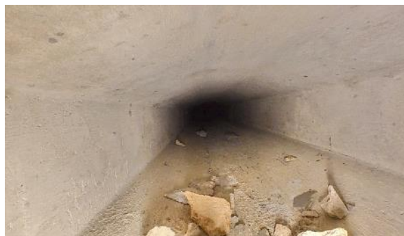
Obr. 38: N8P2. Pohled směrem od Pi2 k Op3.
