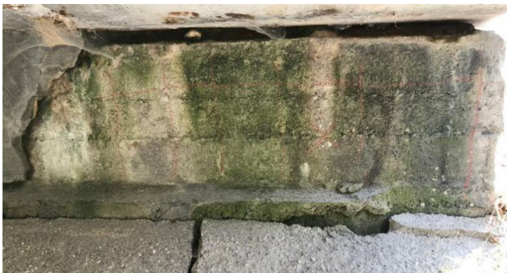
Obr. 5.3-3: Levý konec opěry 1.
