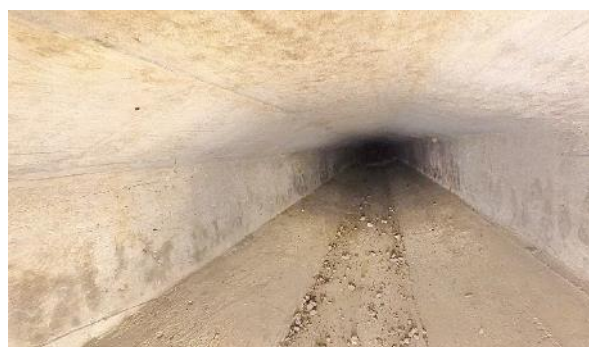
Obr. 18: N9P1. Pohled směrem k Pi2.
