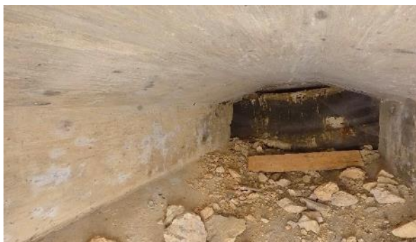
Obr. 29: N4P2. Pohled směrem od Op3 k Pi2.
