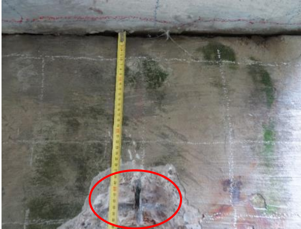
Obr. 31: Pi2 – Levá konzola ÚP staviva se zvýrazněním poloh sondy S ss5 . Měření polohy detekované vodorovné výztuže.
