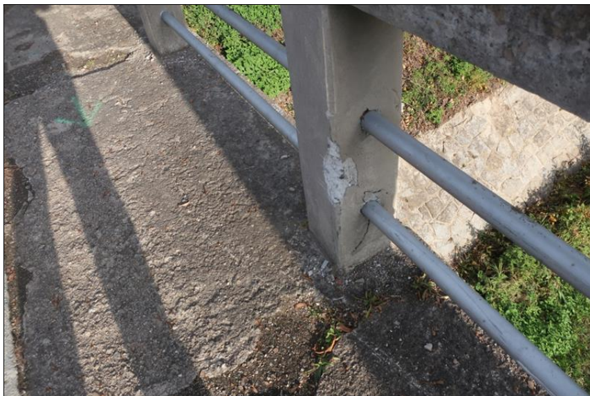
odražená hrana sloupku zábradlí
