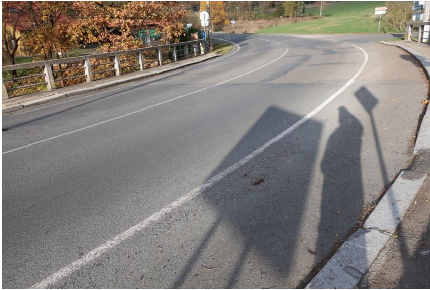
pohled na kryt vozovky
