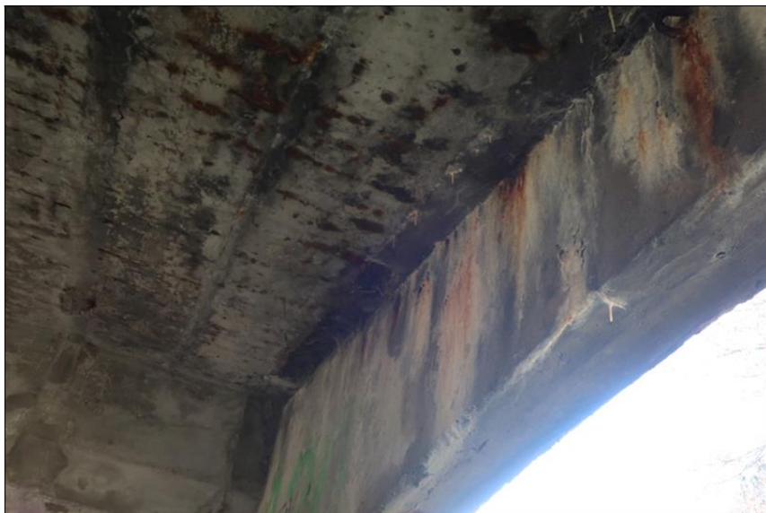
aktivní průsaky s výluhy pojiva na vnitřní straně levé plentovací zdi u O1
