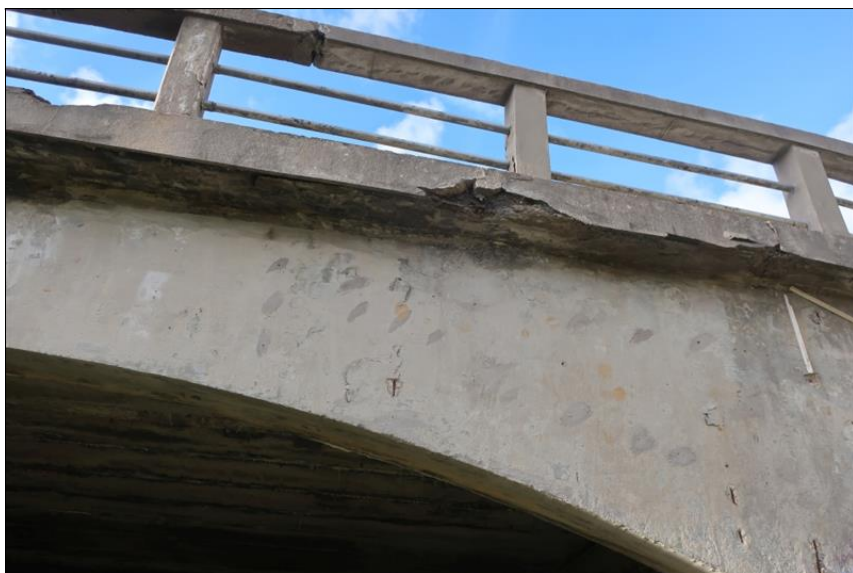
lokální rozpad pravé římsy
