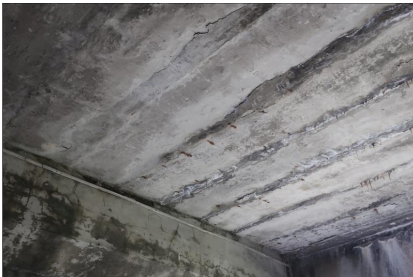
uložení NK na opěru 2 vpravo
