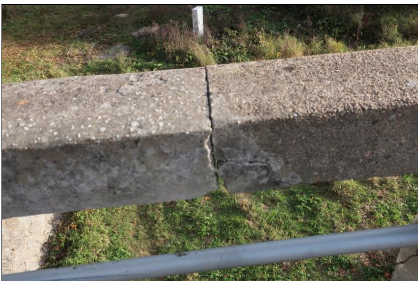
pracovní spára v madle zábradlí
