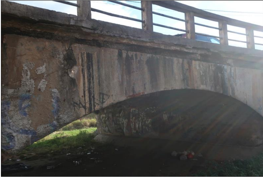
pohled na levou stranu mostu
