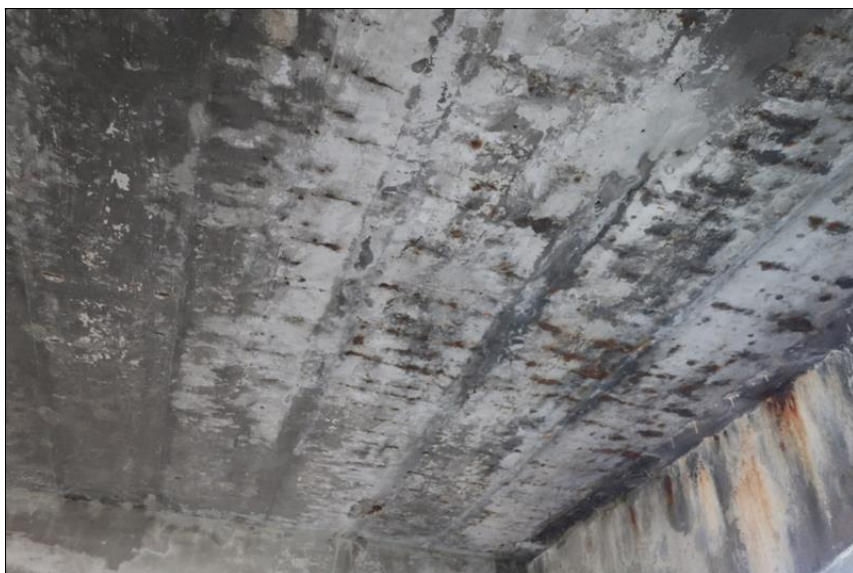
spodní líc NK při levé straně u O1 intenzivní průsaky NK
