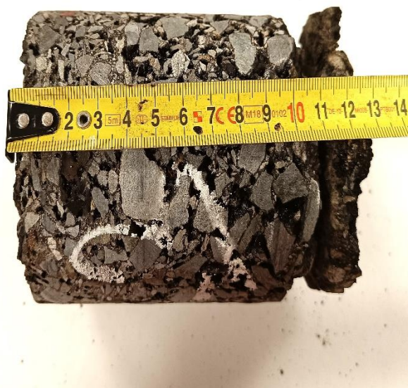
Jádrový vývrt č. 4
