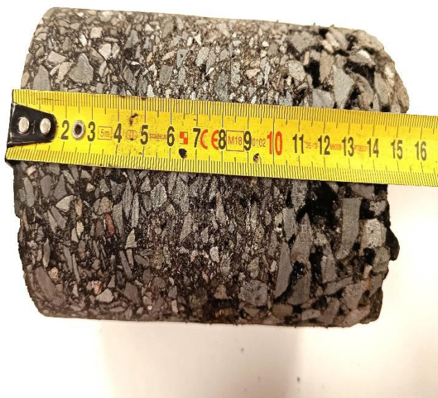
Jádrový vývrt č. 2
