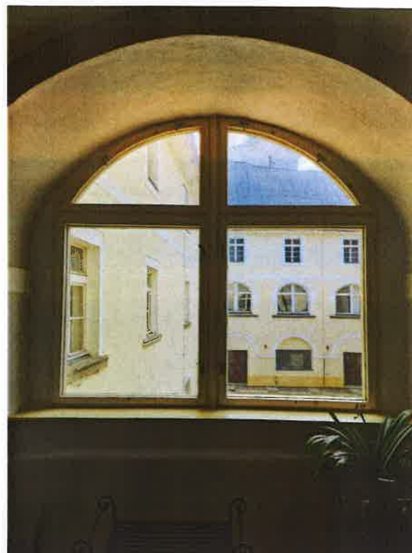
Pohled na obloukové okno z vnitřní strany. Patrné dozdění menšího okna na bocích. Západ, 2. NP.
