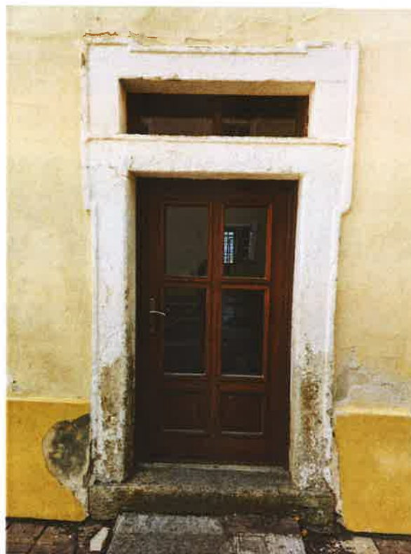
Dveřní kamenné ostění na pravé straně severní fasády. 1. NP.
