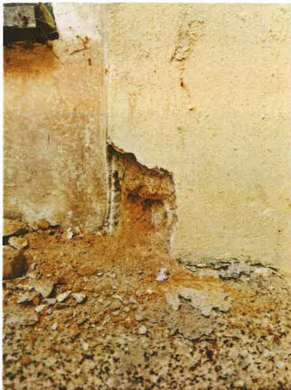
Detail sondy na obloukovém okně západní fasády, 1. NP. Styk kamenného parapetu a šambrány okna. Pravé okno.
