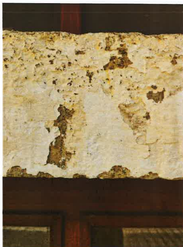
Detail barevného souvrství dveřního ostění na levé straně severní fasády. 1. NP.
