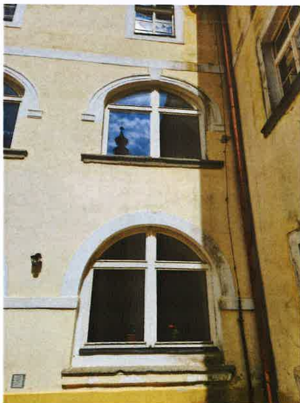
Detail obloukových oken, původně otevřených arkád. Západ, 1. a 2. NP.
