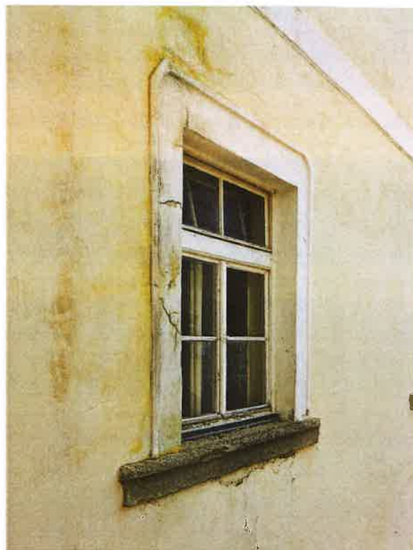
Okno s štukovou šambránou a kamenným parapetem. Sever, 2. NP.
