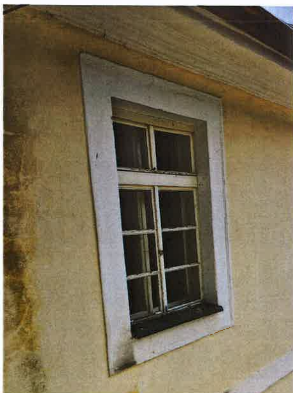
Okno s štukovou šambránou. Sever, 3. NP.
