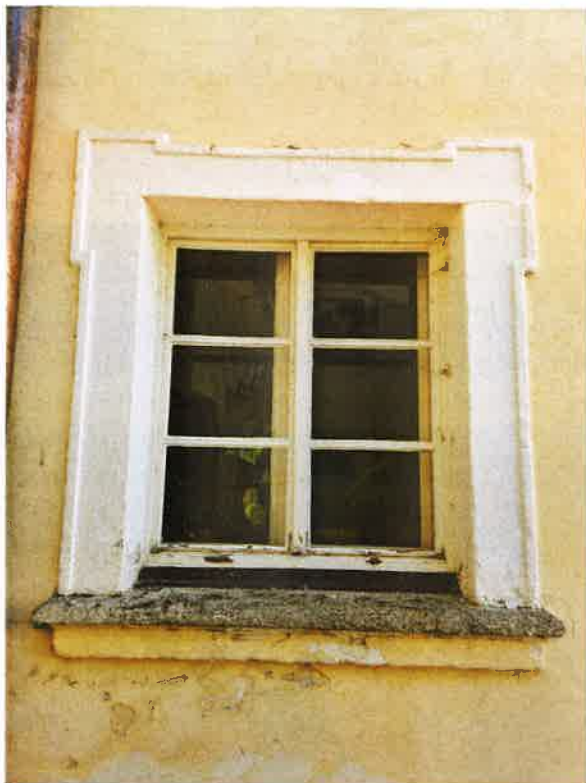
Okno s kamenným ostěním a parapetem. Jih, 1. NP.
