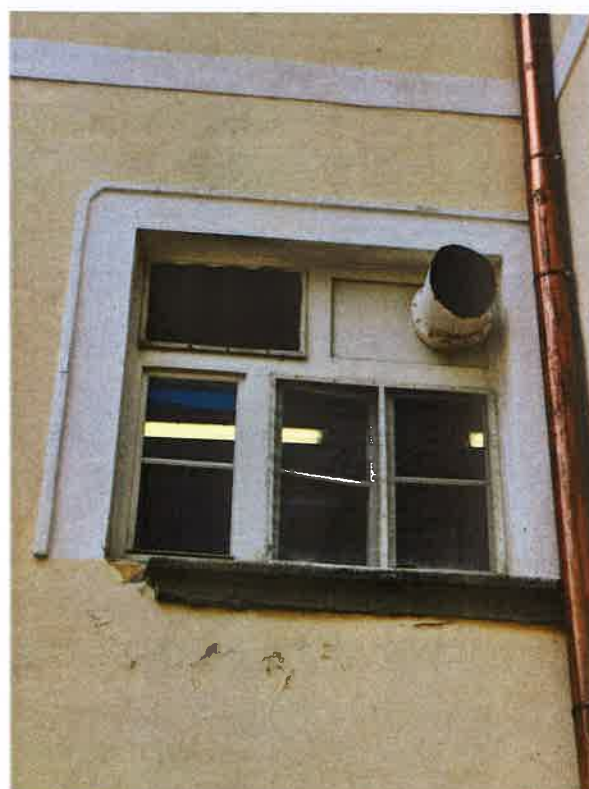
Jedno z dvou rozšířených oken na severní fasádě, 2. NP.
