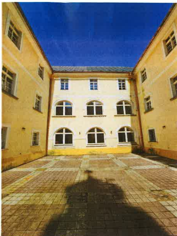
Celkový pohled na západní fasádu obdélného dvora zámku.
