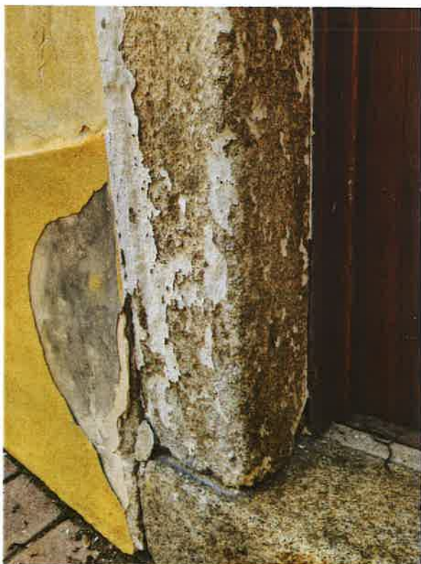
Detail - dveřní kamenné ostění na pravé straně severní fasády. 1. NP.
