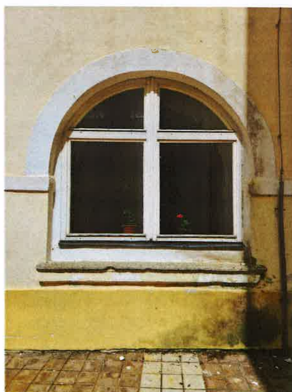
Detail obloukového okna. Západ, 1. NP
