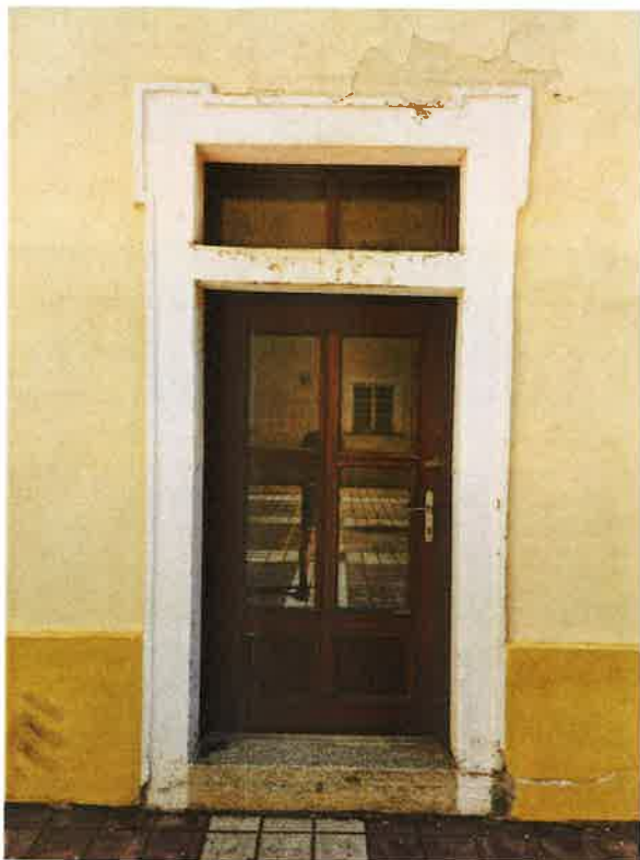
Dveřní kamenné ostění na levé straně severní fasády. 1. NP.
