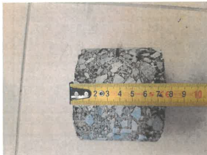
Jádrový vývrt č.2
