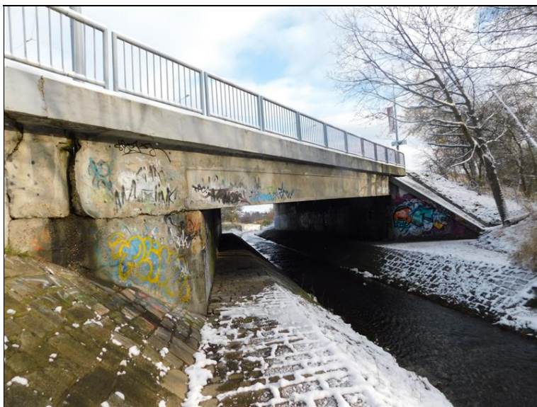
Pohled na levou stranu mostu
