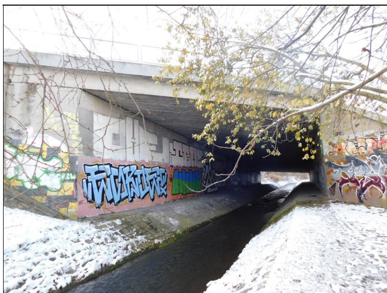
Pohled na pravou stranu mostu
