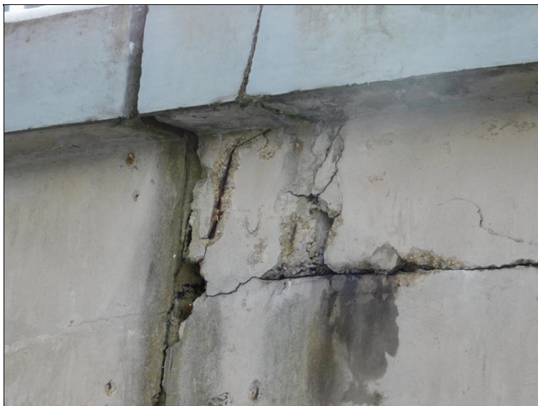
Dobetonávka za šelem nosníku nad Op1
