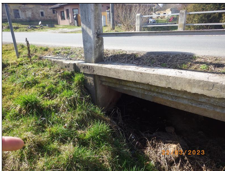
Opěra 1 a křídlo zprava
