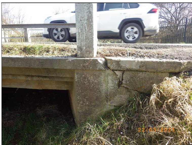
Opěra 1 a křídlo zleva
