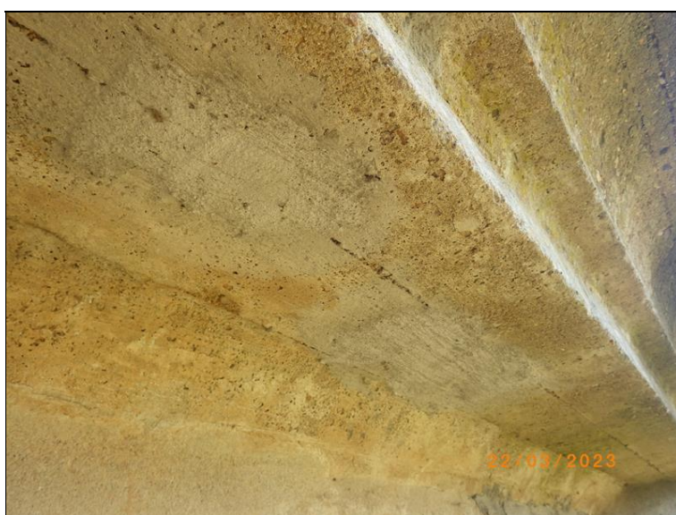
Detail lokálních oprav na podhledu trámů
