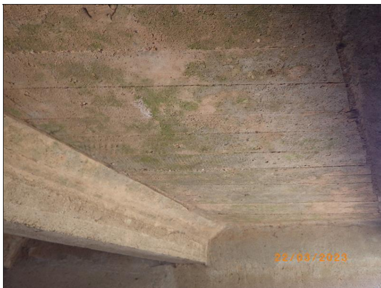
Podhled desky mezi trámy
