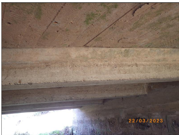
Podhled trámové konstrukce
