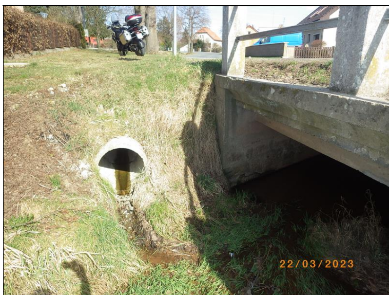
Opěra 2 a křídlo zleva
