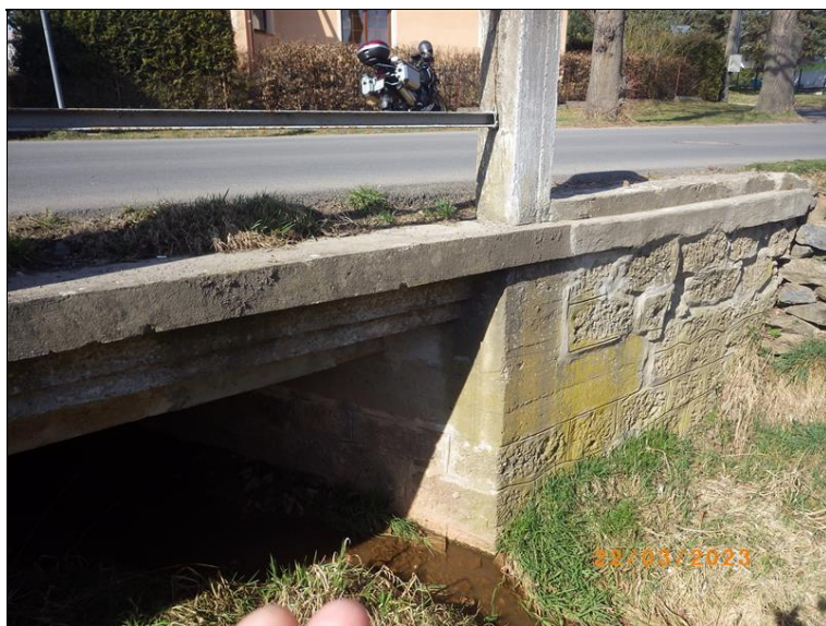
Opěra 2 a křídlo zprava
