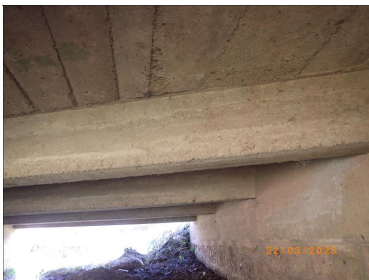
Podhled trémové konstrukce
