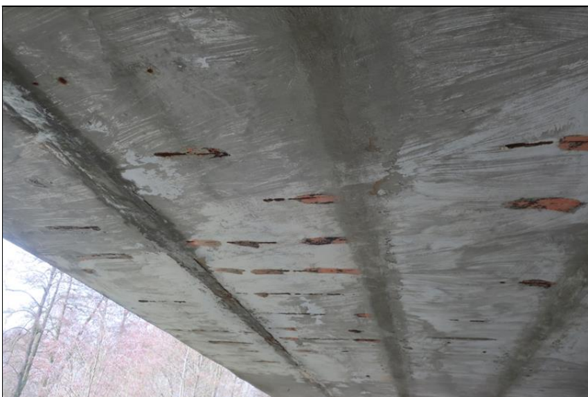
podhled 1. - 3. nosníku od O1
