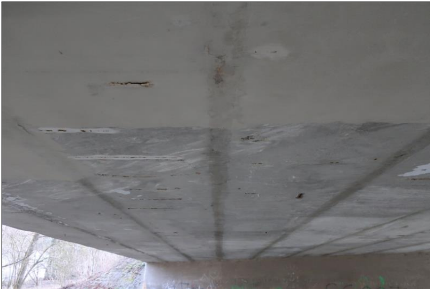
podhled 8. a 9. nosníku od O2
