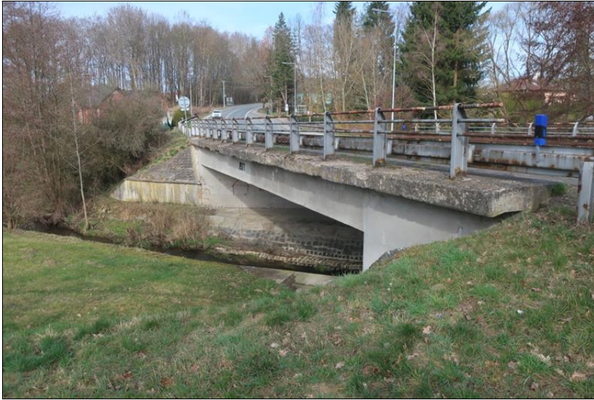
levý bok mostu od O1
