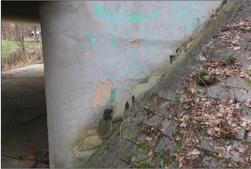
pravý bok opěry O2
