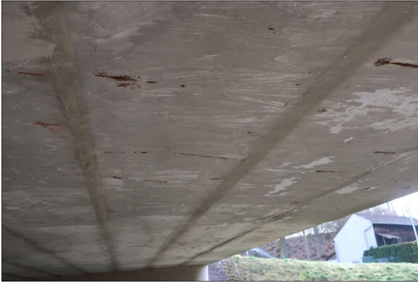
podhled 1.-3. nosníku od O2
