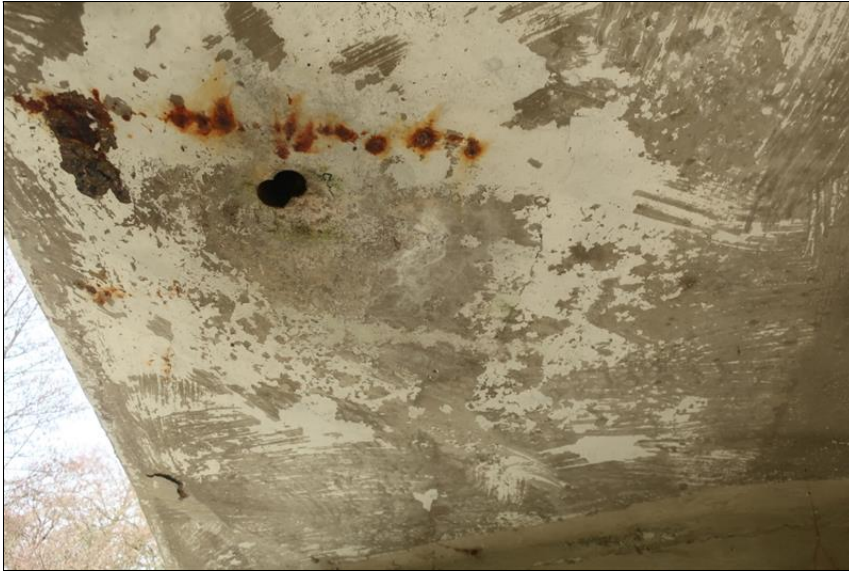
aktivní průsaky z dutiny 1. nosníku
