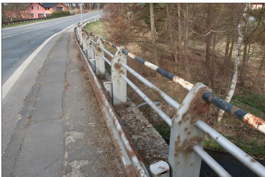
pravé zábradelní svodidlo
