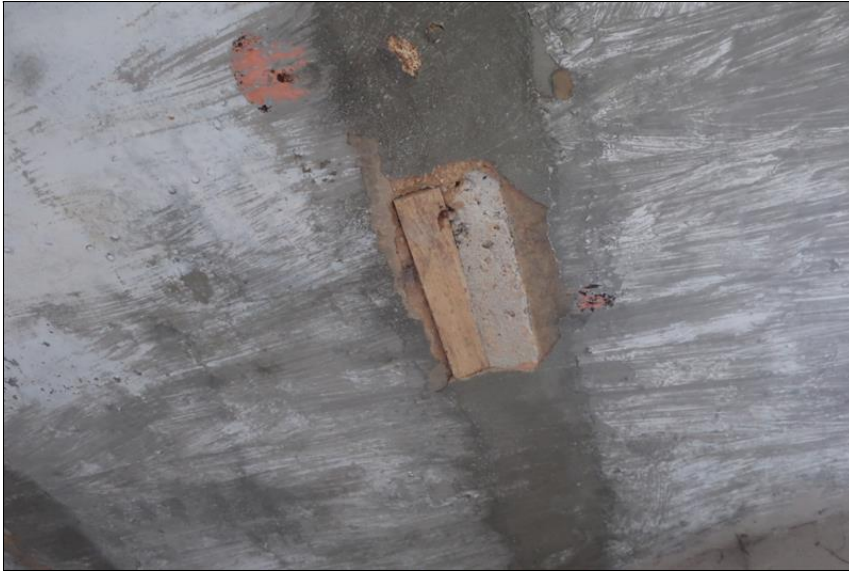
prkno ve spáře mezi nosníky
