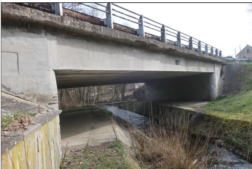
pohled na levou stranu mostu
