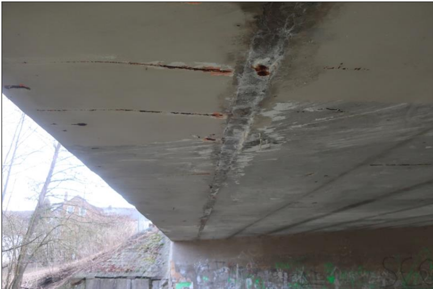
podhled 10. a 11. nosníku od O2
