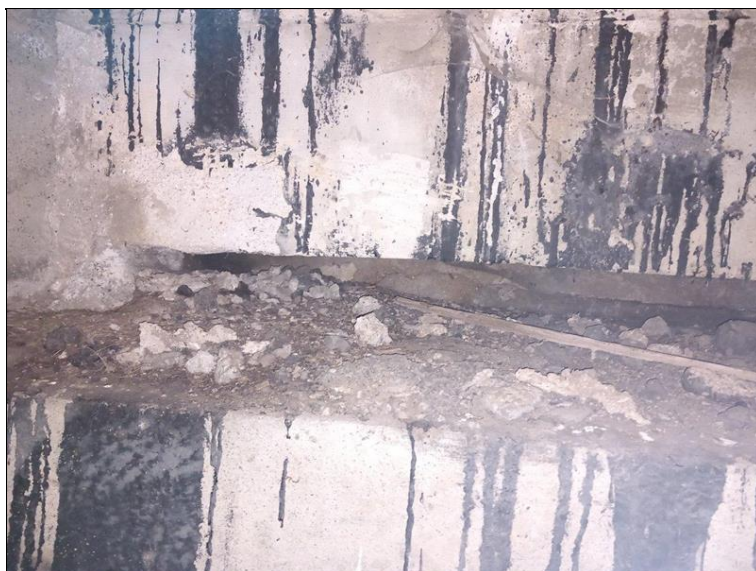
Nečistoty na úl. prahu OP2 mezi 2. a 3. trámem zleva.
