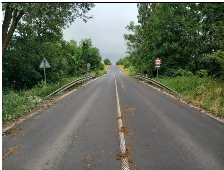
Pohled na most ve směru staničení
