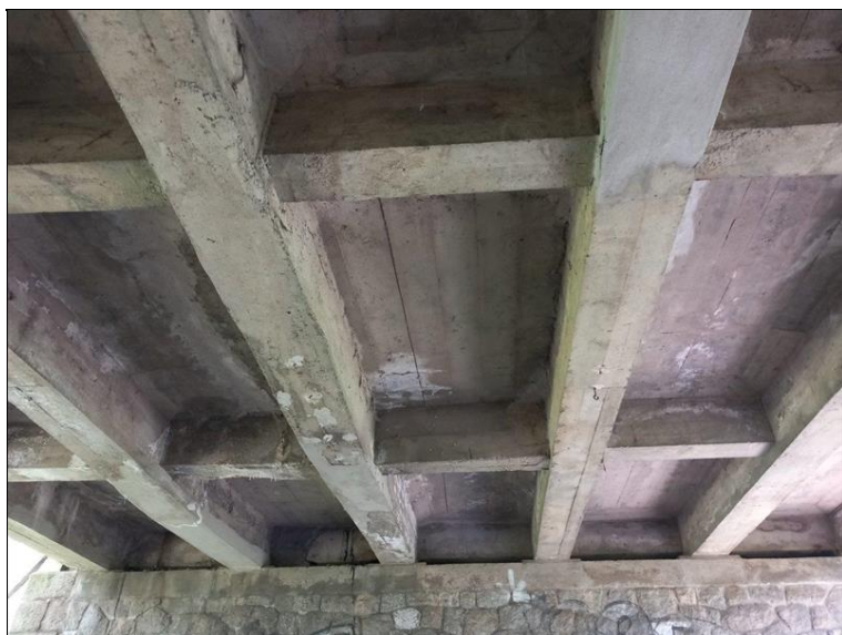
Podhled NK od OP2
