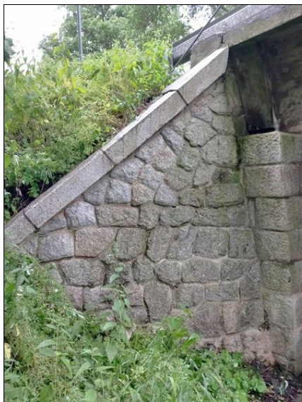
Pohled na pravé křídlo OP1
