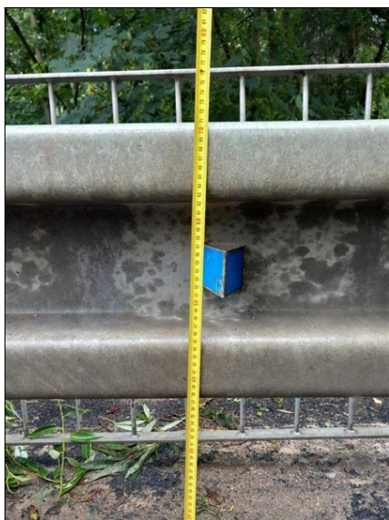
Horní hrana svodnice ve výšce 70cm od povrchu vozovky.
