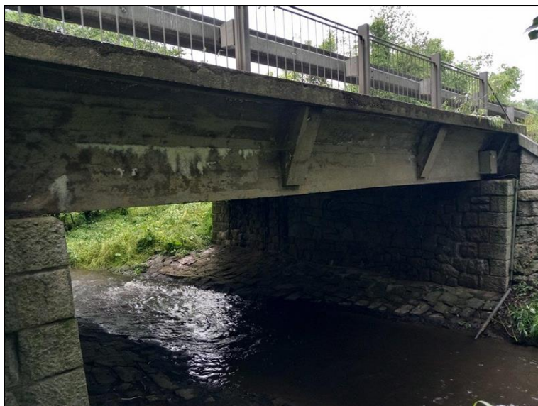
Pohled na pravou (povodní) stranu mostu.
