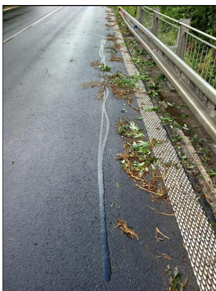
Opravené podélné trhliny ve vozovce na pravé straně.
