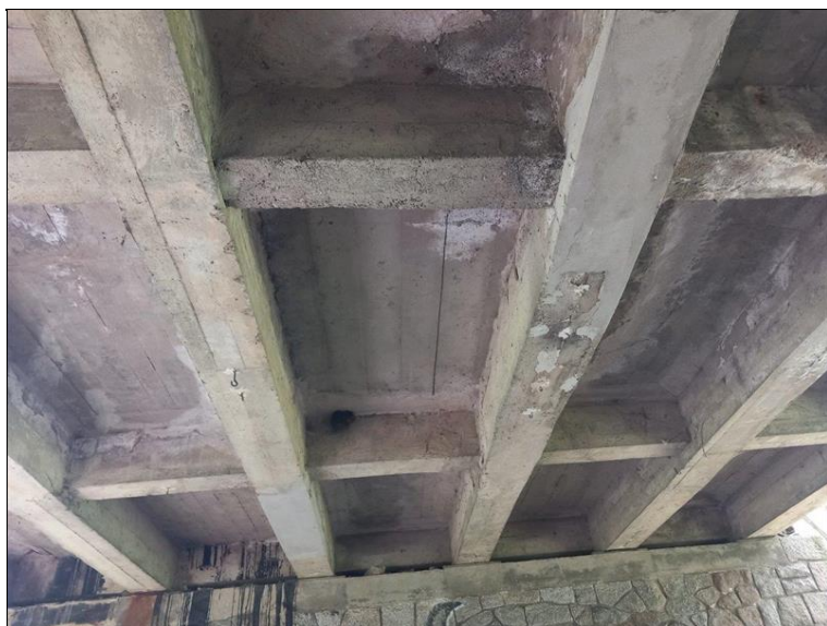
Podhled NK od OP1
