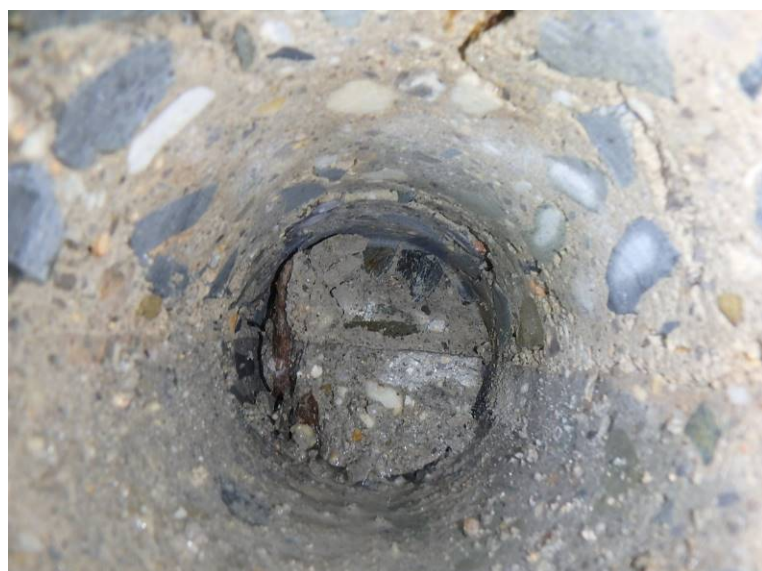
Pohled do vývrtu
