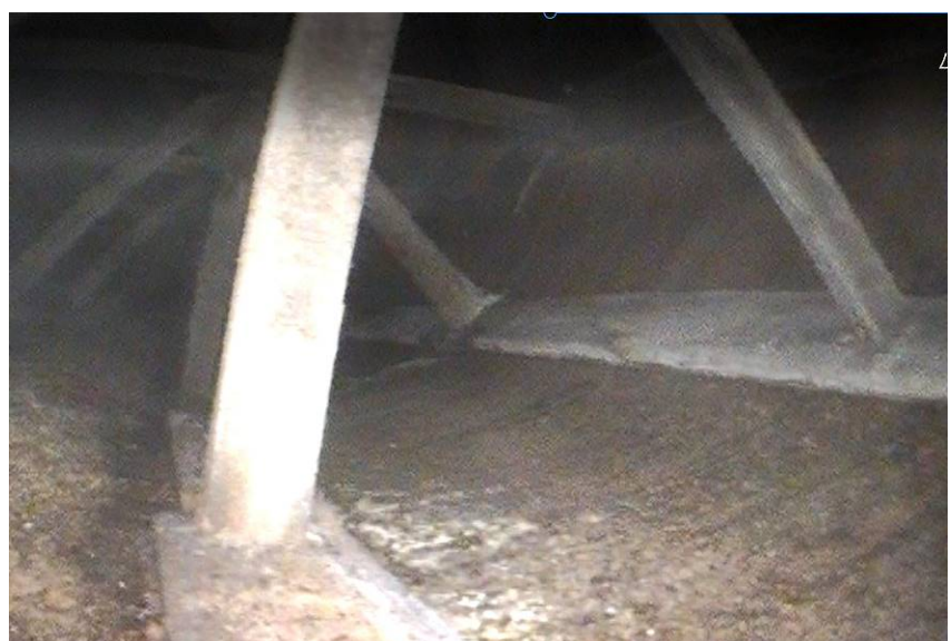
Nečistoty napadané ve spodní části SPIRO rour
