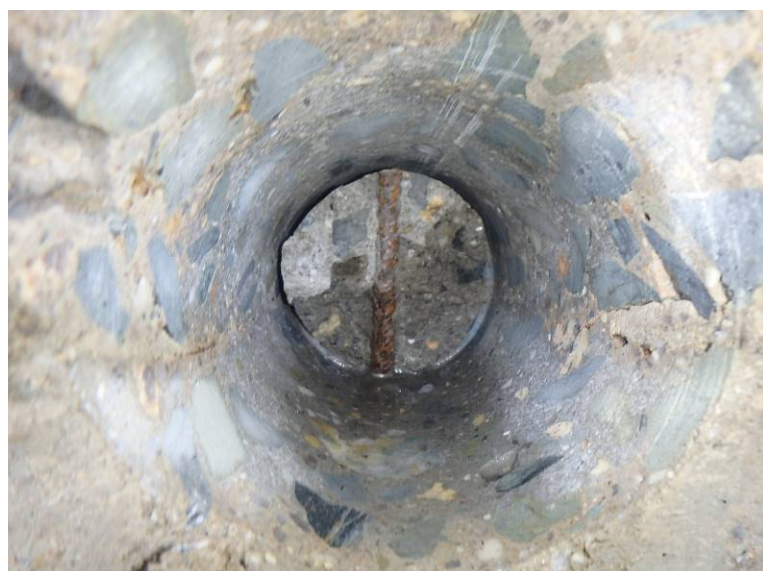
Pohled do vývrtu
