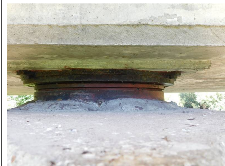
Pi3-L Pohled na ložisko boční
