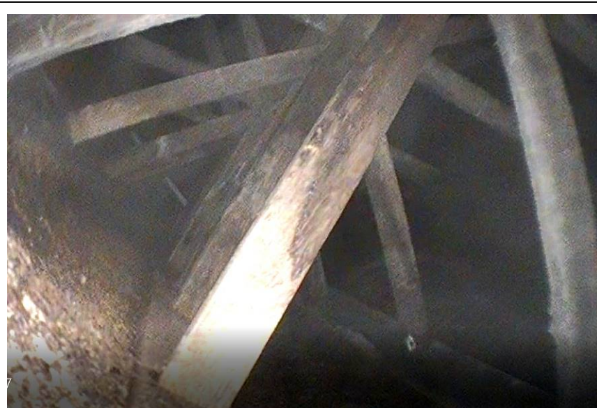
Výdřeva v odlehčovací dutině
