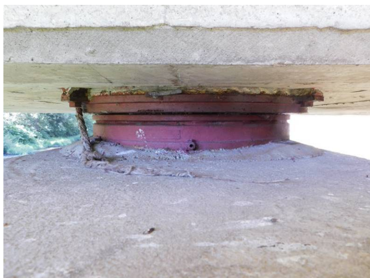
Pi2-L Pohled na ložisko boční
