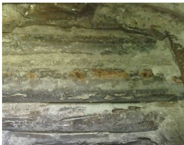
Sonda PV 11 – detail drátů
