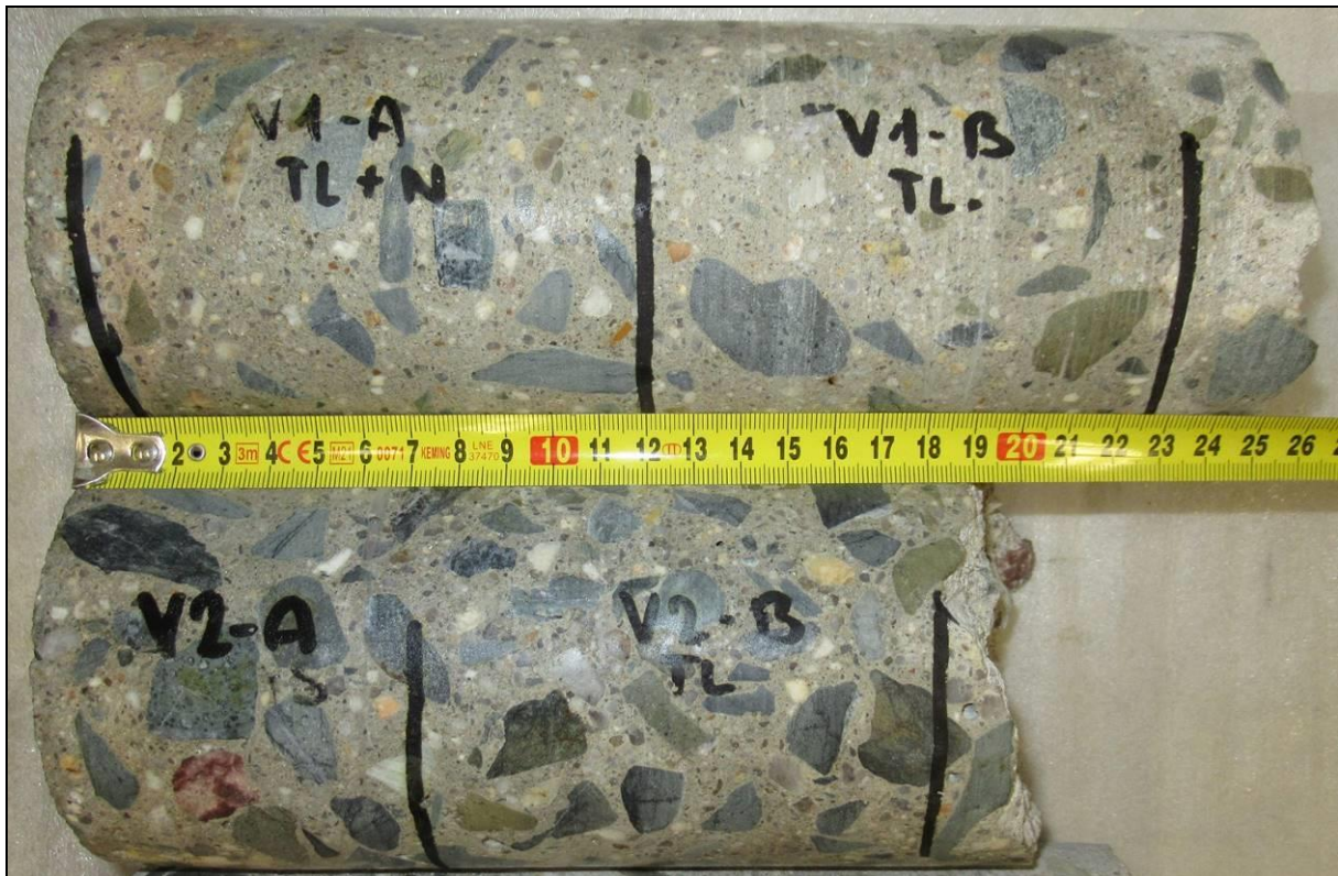
Foto 1: Pohled na vývrtů V1 a V2
