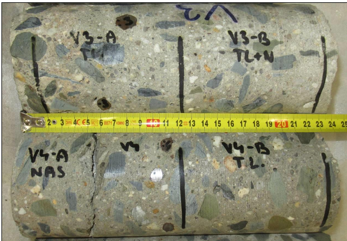
Foto 2: Pohled na vývrtů V3 a V4
