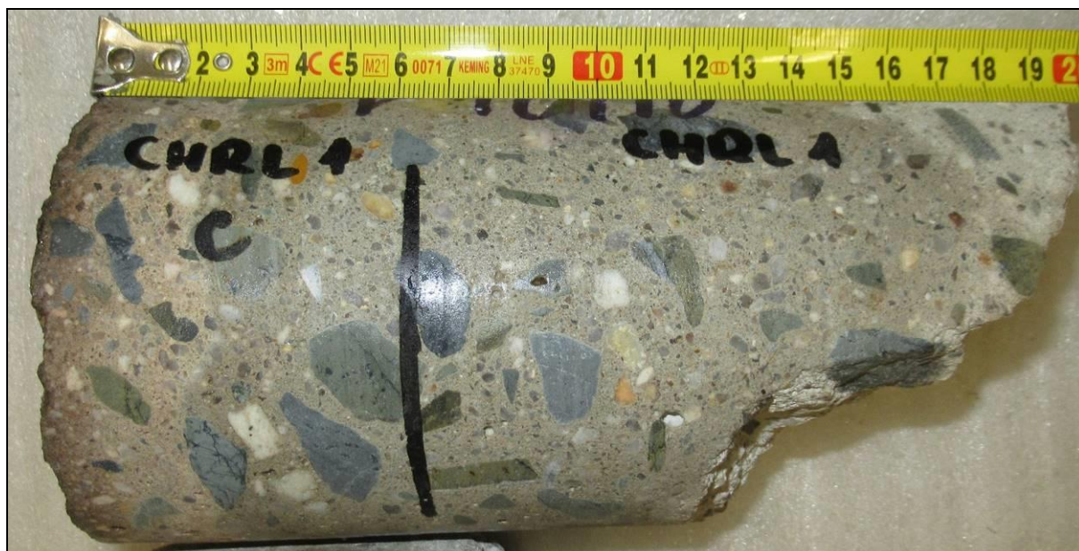
Foto 6: Pohled na vývrt CHRL1
