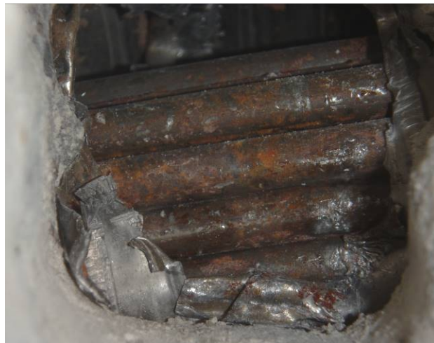
Sonda PV 10 – chránička Sandrik jen s velmi lehkou povrchovou korozí se díky absenci injektážní malty při odbourání betonu deformuje. Detail povrchu drátů v sondě PV10
