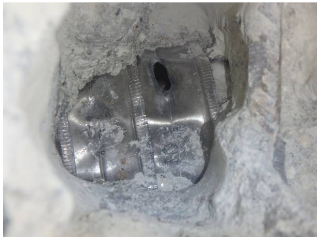
Sonda PV 10 – chránička Sandrik jen s velmi lehkou povrchovou korozí se díky absenci injektážní malty při odbourání betonu deformuje. Detail povrchu drátů v sondě PV10
